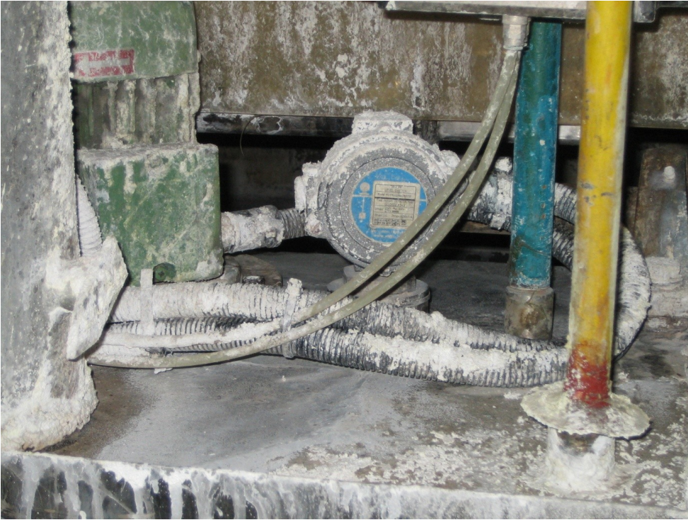
Abb. 15 Aluminiumhydroxid- und Natronlauge(kristallin)-Ablagerungen 1
