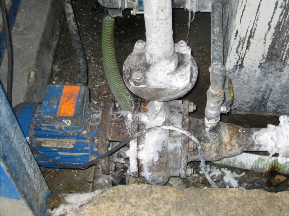
Abb. 16 Aluminiumhydroxid- und Natronlauge(kristallin)-Ablagerungen 2
