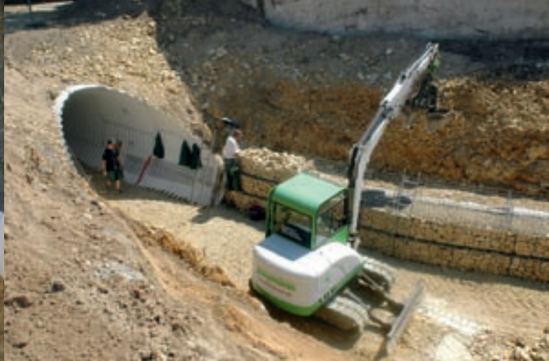
Der Verbindungstunnel wird angelegt.
