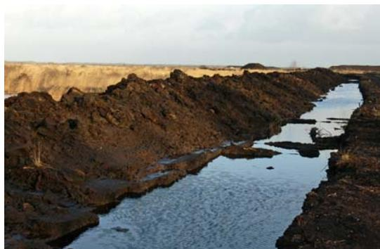
Abb. 27: Verstärkung der Außenverwallung auf Fläche 1 in TG 2
