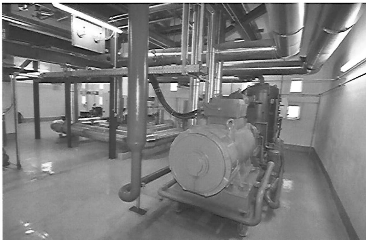
Abb. 8 Blockheizkraftwerk
