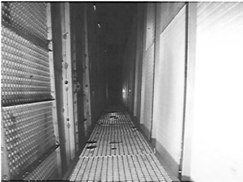
Abb. 6 Einbringung der Wärmetauscher
