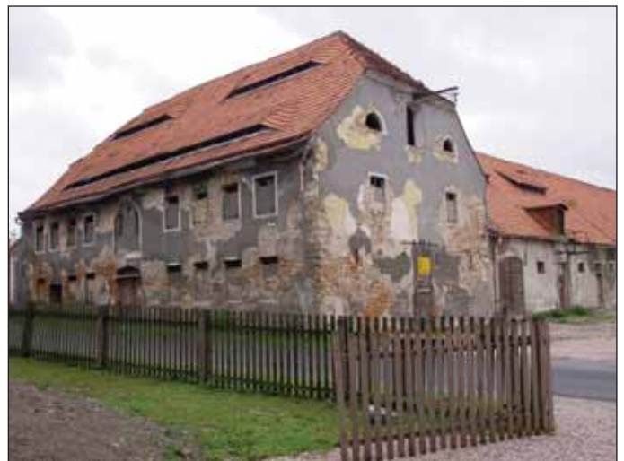
Der Speicher vor der Sanierung
