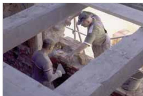
Mauerwerk wird ersetzt
