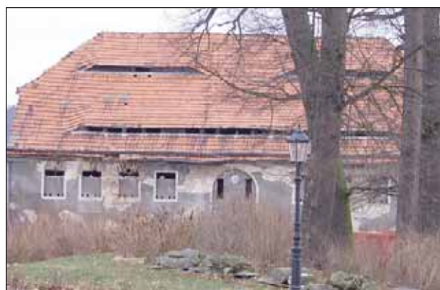
Blick auf den Speicher von der Straßenseite 2006
