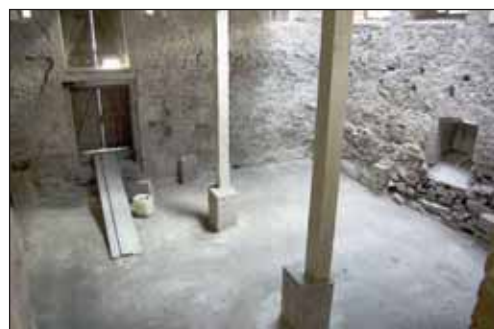
Abgesenkter Fußbodenbereich im künftigen Eingangsbereich von der Hofseite her
