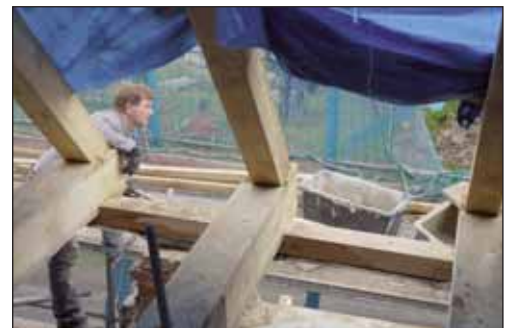
Dachbalken werden ausgetauscht
