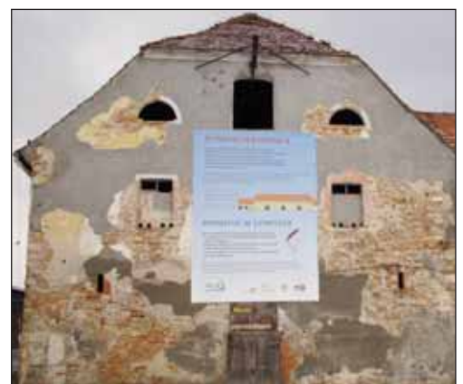
Außenmauern vor der Sanierung
