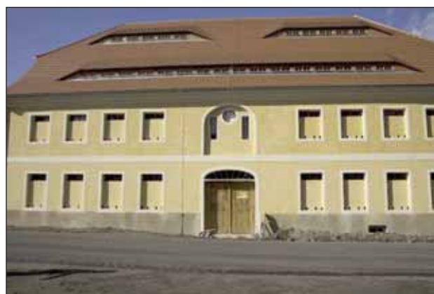
Blick auf den Speicher von der Straßenseite 2009
