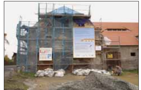
Das Dach ist gedeckt
