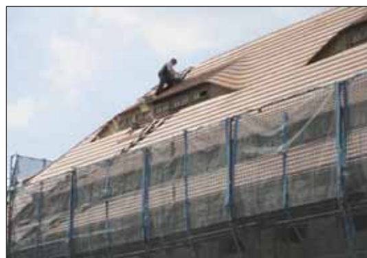
Provisorische Eindeckung des Daches
