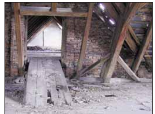
Dachstuhl vor der Sanierung
