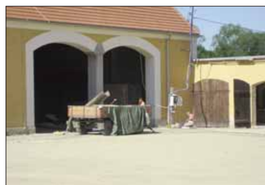
Renovierung der Remise und der Schmiede
