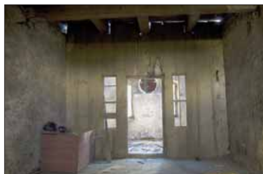
Eingang zum ehemaligen Kontor vor der Sanierung
