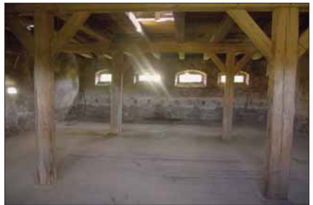
Hölzerne Stützpfeiler in einem der ehemaligen Lagerräume
