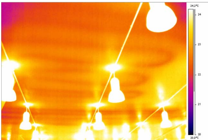
Abbildung 18: Thermografieaufnahme der Rohrschlangen der aktivierten Decke nach dem Auffüllen mit Wasser
