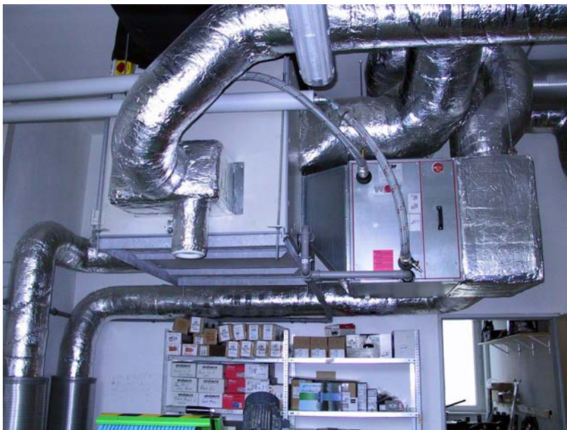
Abbildung 19: Lüftungsgerät mit Heiz-/Kühlregister (rechts)
