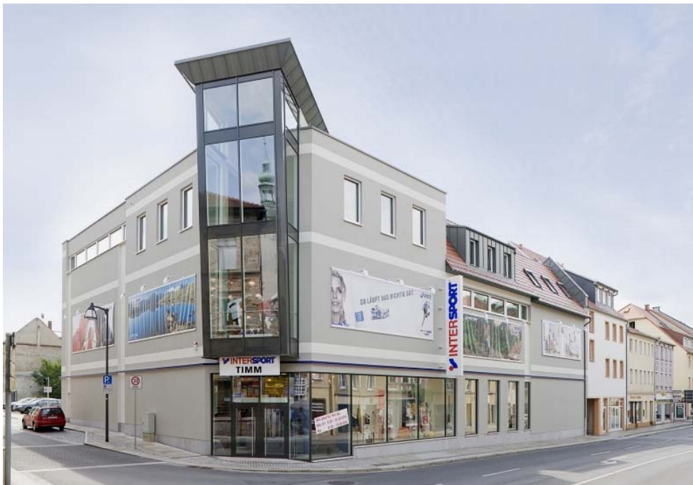
Abbildung 3: Untersuchungsobjekt Intersport Timm in Bautzen, Quelle: Rehau
