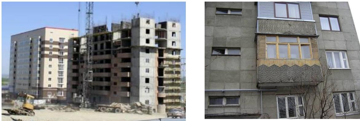
**Bild 8** Wohngebäude in Stahlbetonskelettbauweise
