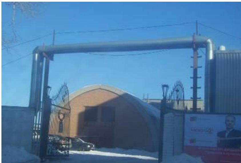
**Bild 21** oberirdisch geführte Fernwärmeleitung
