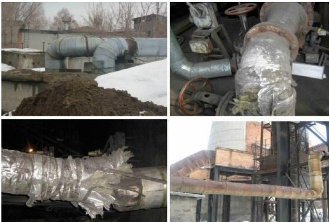
**Bild 20** Zustands der Fernwärmeverteilungen in Kasachstan
