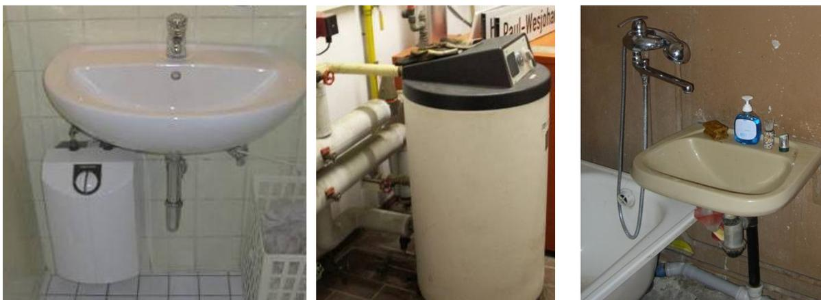
**Bild 23** Warmwasserbereitung in Wohn- und Nichtwohngebäuden (links: dezentrale Bereitung, mitte: zentrale Warmwasserbereitung, rechts: Warm- und Kaltwasserübergabe)
