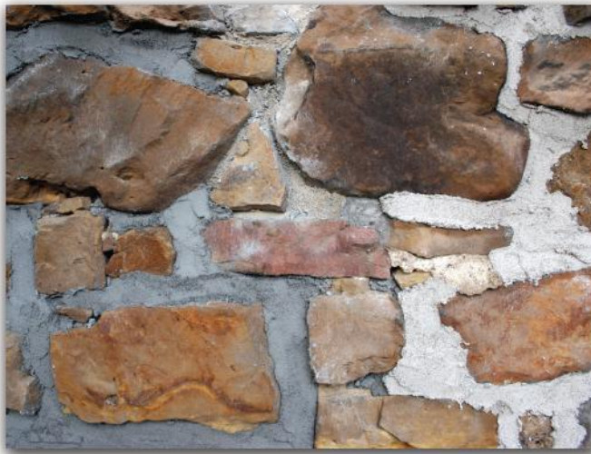
Abb. 8. Bildtafel zu den technischen Daten des Kompressenputzmörtels. Links auf der Detailaufnahme die graue und rechts die weiße Mörtelvariante in Bearbeitung.
