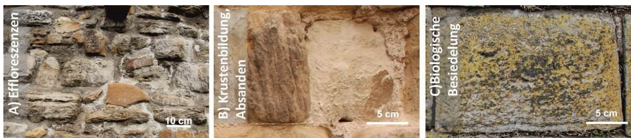
Abb. 12. Gesteinsanlagernde Oberflächenveränderungen. A) Effloreszenzen, vom Mörtel auf die Gesteine übertragen, B) links im Bild dunkel gefärbte Krustenbildung, rechts oberflächliches Absanden nach Lösung des Bindemittels, C) oberflächliche biologische Besiedelung durch Flechten (s.a. Kap. "Untersuchung der Aufwuchsflora").
