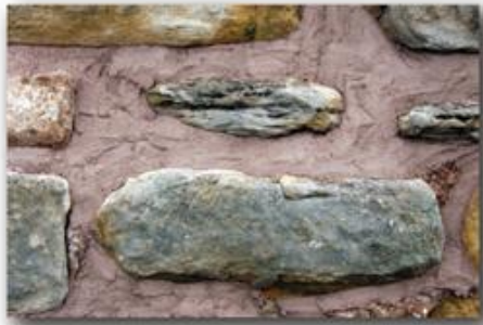
Abb. 10. Der angetragene Mörtel
