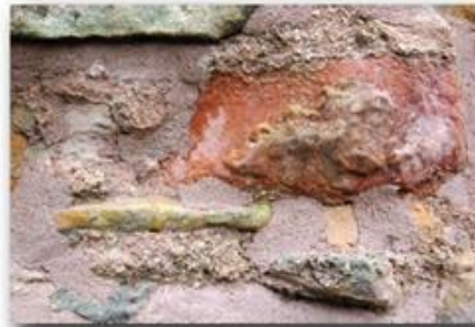
Abb. 13. Integration des Bestandsmörtels
