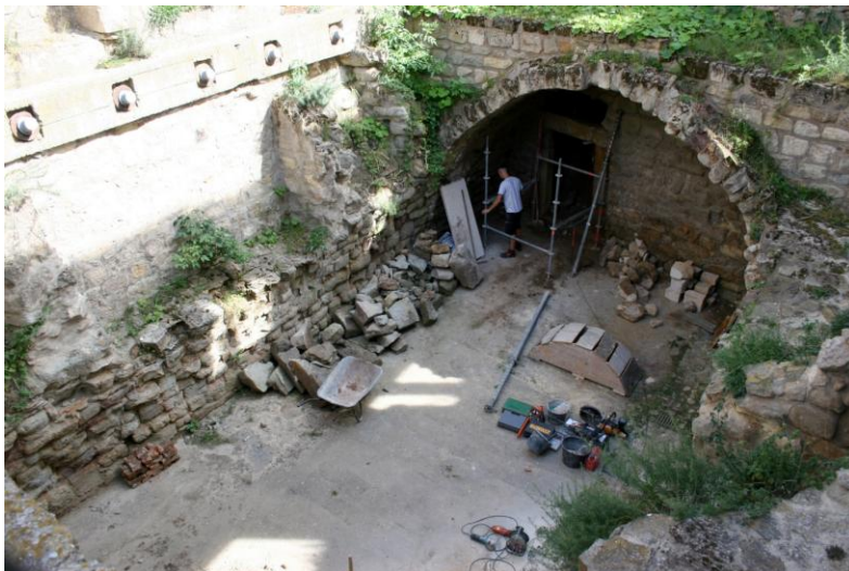
Abb. 17. Sicherungs- und Restaurierungsarbeiten im Keller des Herrenhauses.
