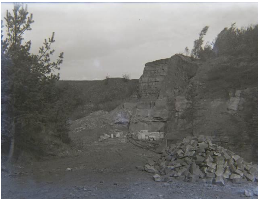
Abb. 1. Historisches Foto des Sandsteinabbaus am Seeberg bei Gotha (um 1910; von Freyberg 1937). Neben dem Gleis sind formatierte Sandsteinblöcke zu erkennen. An der Steinbruchwand ist die Wechsellaagerung von Sandsteinbänken und Tonsteineinlagen (Oberer Keuper, Rhätkeuper) aufgeschlossen.
