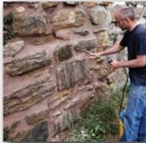
Abb. 12. Freiwaschen des Mörtels
