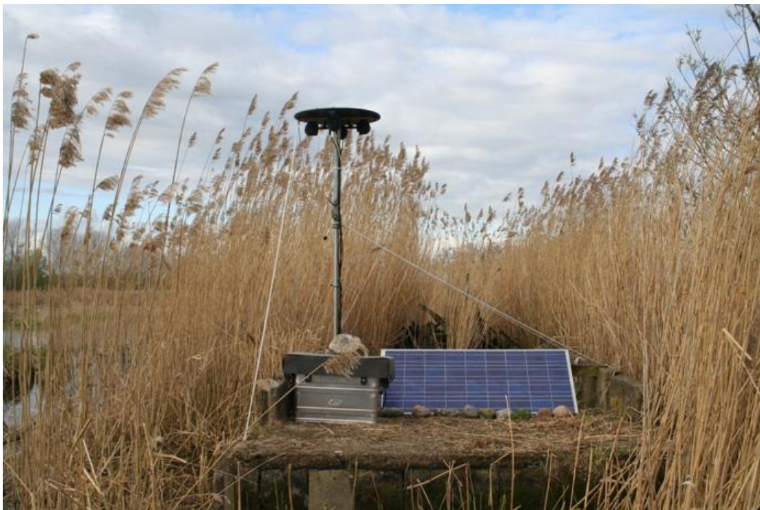
Abbildung 34: Solarbetriebene Station zur akustischen Dauererfassung.
