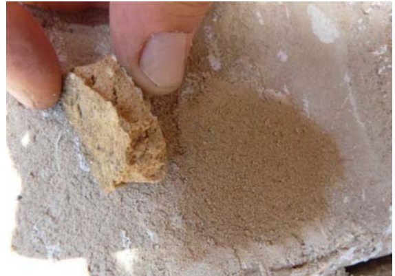
Abb. 465: Anpassen des Putzes an die originale Farbigkeit, 2010
