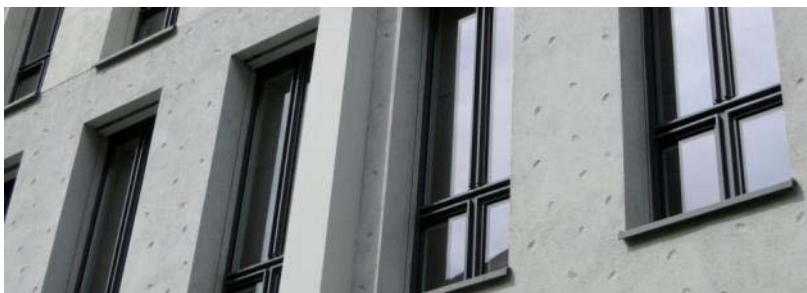
Abb. 49: Moderne Variation der Stempelputz-Technik am Haus am Zwinger in der Altstadt von Dresden
