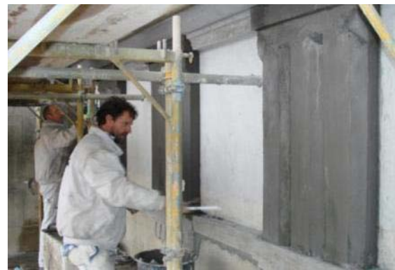
Abb. 513: Mitarbeiter der Firma K.Rogge bei der Begrädigung der Putzkanten des Typs C an den Triglyphen
