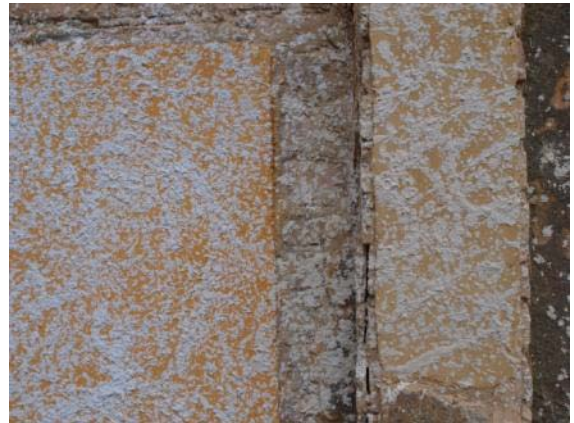
Abb. 467: Probeflächen mit Baustellenmischung
