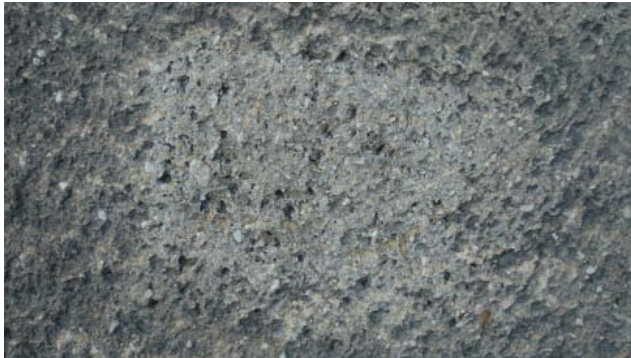
Abb. 370: Lessing-Loge, Ostfassade, mit Hirschhornsalz gereinigte Kratzputzfläche
