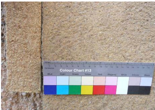
Abb. 469: Wohnhaus Potsdam, Scheibenputzfläche, links im Bild nachgestellter Edelputz, rechts Originalputz in situ
