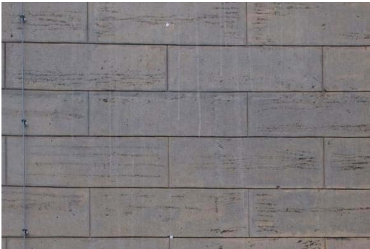
Abb. 481: Steinputzfassade mit Fugenschnitt an Nordfassade Mittelbau Nord
