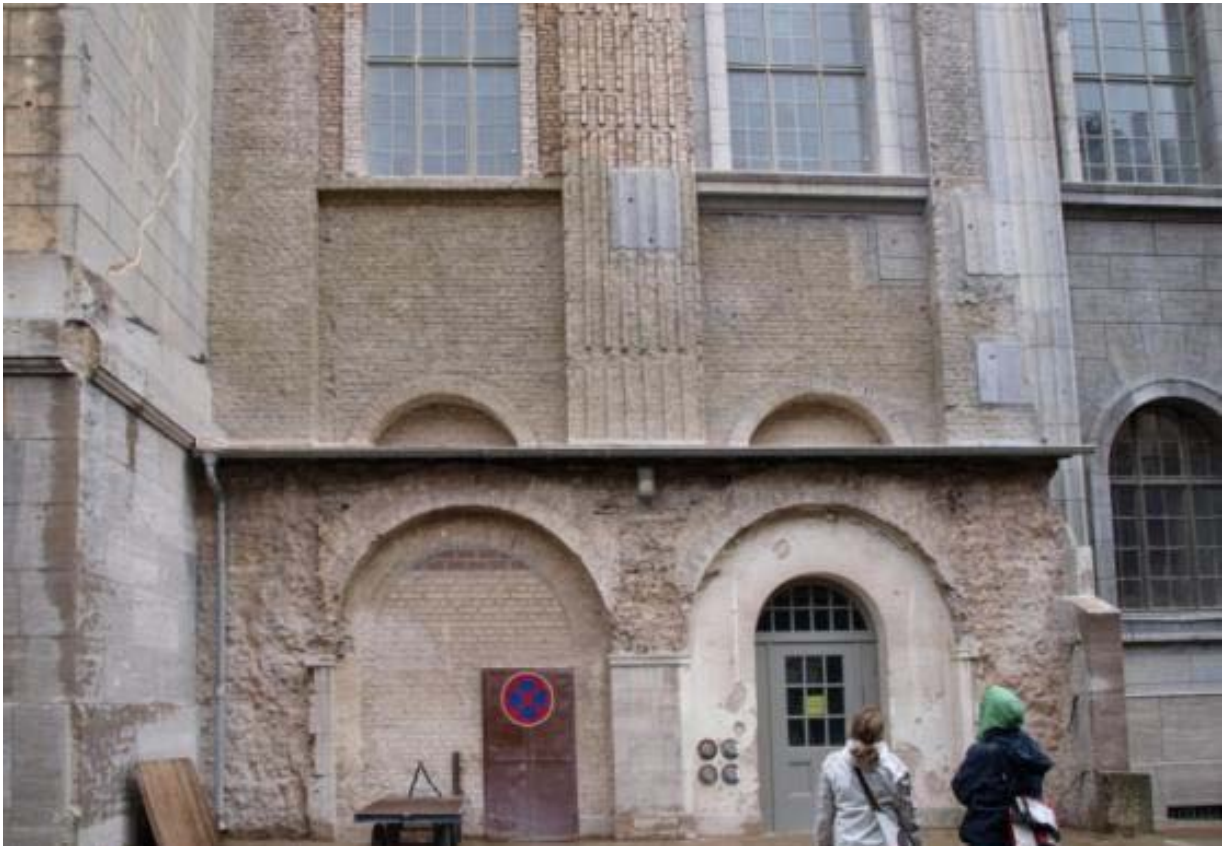
Abb. 508: Ergänzungsputz Typ B (Metope) und Typ A (Triglyphe) Das Foto verdeutlicht das Fehlen des blaugrauen Farbstichs im Ergänzungsmörtel.
