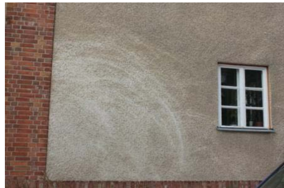
Abb. 114: Entfestigung und Absanden kann durch mechanische Belastung sichtbar werden (hier evtl. durch einen vorher dort wachsenden Strauch). Parchimer Allee in der Hufeisensiedlung (Objekt-Nr.:1200).
