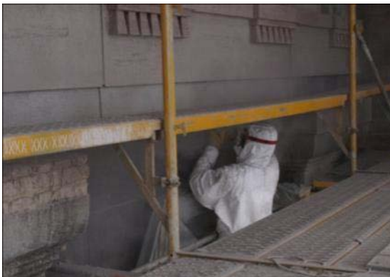
Abb. 514: Schleifen der Steinputzoberfläche mittels Winkelschleifgerät, Sanierungsarbeiten 2009/2010
