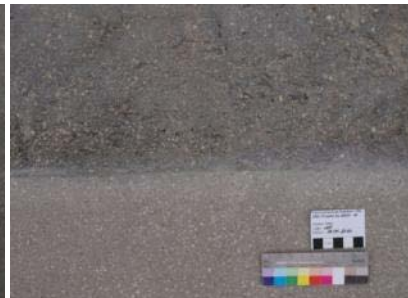
Abb. 510: Oben bauzeitlicher Putz, unten Typ B mit hellen feinen Zuschlägen
