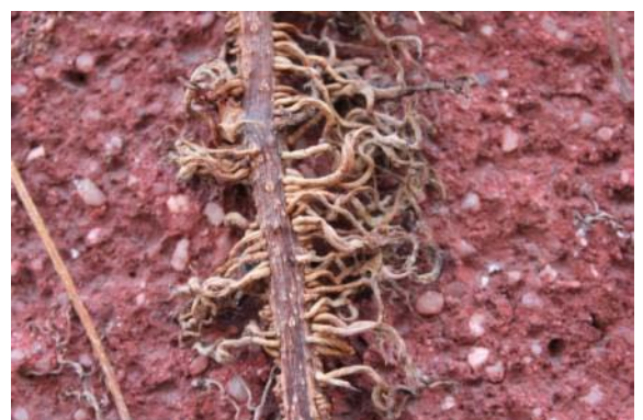
Abb. 103: Detailaufnahme mit Haftwurzeln. Miningstraße der Hufeisensiedlung (Objekt-Nr.: 1200).
