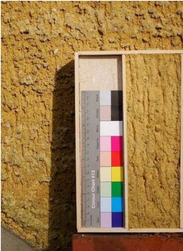
Abb. 472: Buddhistisches Haus/ Gartenhaus, links und oben im Bild Originalputz in situ, rechts nachgestellter Edelputz
