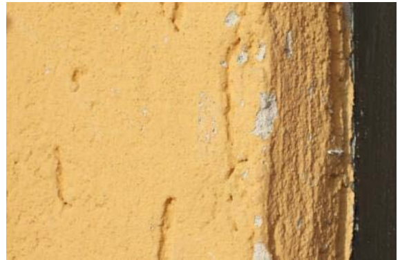
Abb. 138: Fehlstellen in der gelben Fassung legen den darunter liegenden weißen Edelputz frei. Stavenhagener Straße in der Hufeisensiedlung (Objekt-Nr.: 1200).
