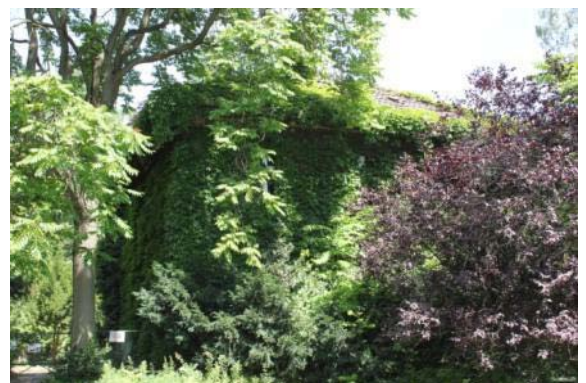
Abb. 102: Das komplett zugewachsene Inspektorhaus des Krematoriums in Berlin- Wedding (Objekt-Nr.: 6301).
