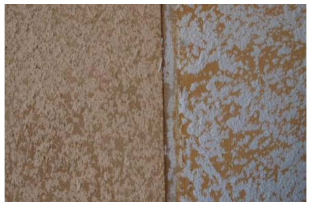
Abb. 463: Probeflächen mit Werk trockenmörteln
