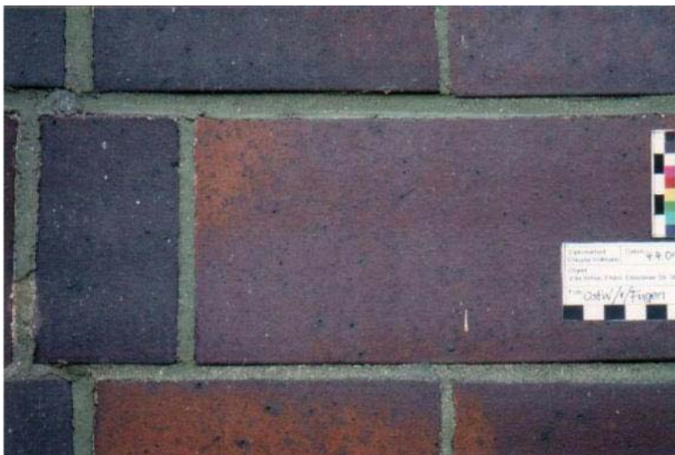
Abb. 85 + Abb. 86: Aufnahmen des farbigen Fugemörtels an der „Villa Vehse“ in Elster
