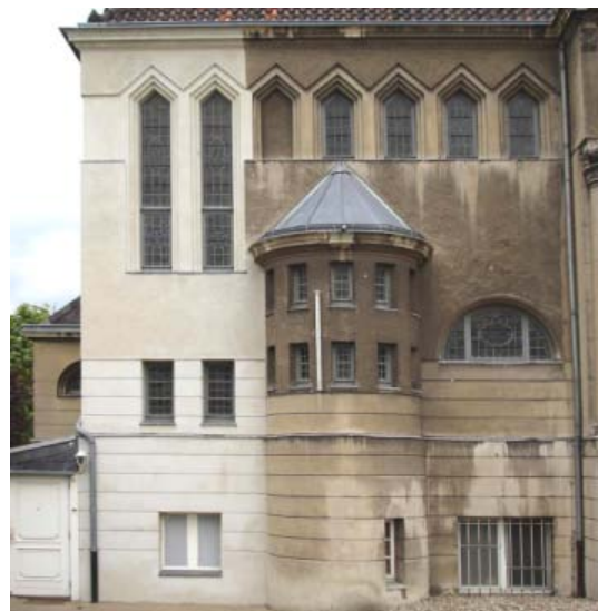
Abb. 372: Lessing-Loge, Ostfassade, mit Pilotfläche, nach 6 Monaten
