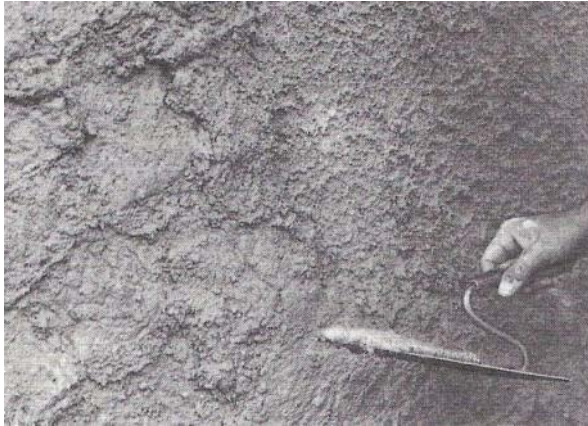
Abb. 9: Anwerfen des Mörtels mittels Kelle
