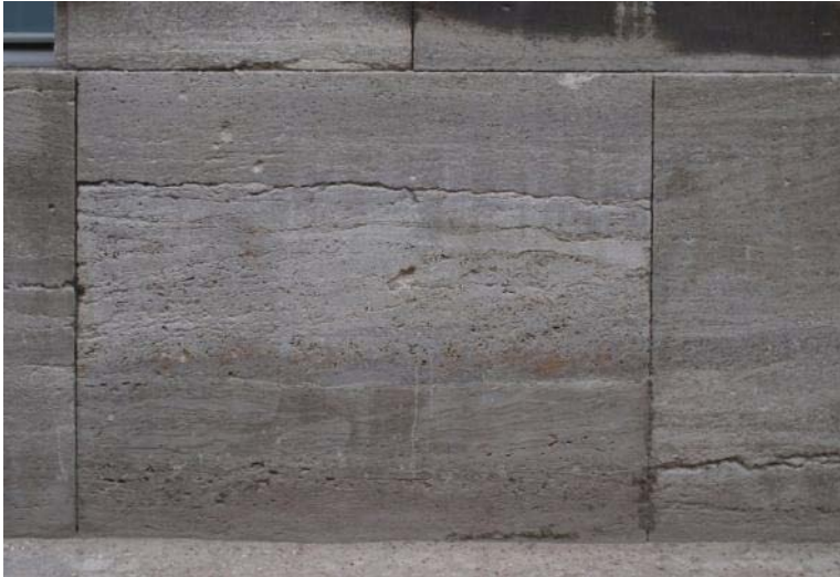
Abb. 479: Natursteinverkleidung an Nordfassade Nordflügel-Kopfbau
