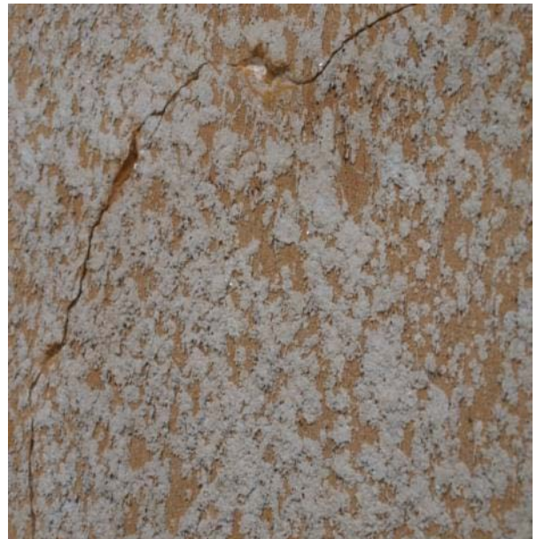
Abb. 8: Ein Sonderfall ist die Kombination aus Reibeputz und einer Besenspritzputztechnik am Landhaus Abraham (s. Objekt-Nr.: 2501)
