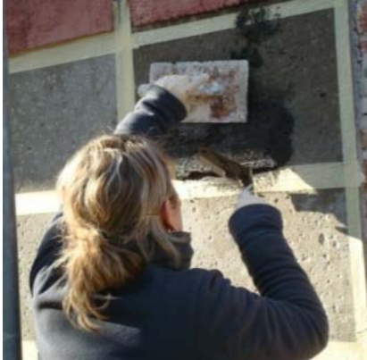
Abb. 537: Applikation des Steinputzes PMUDR01 WAND auf der aufgerauten Oberfläche des Zement-Unterputzes
