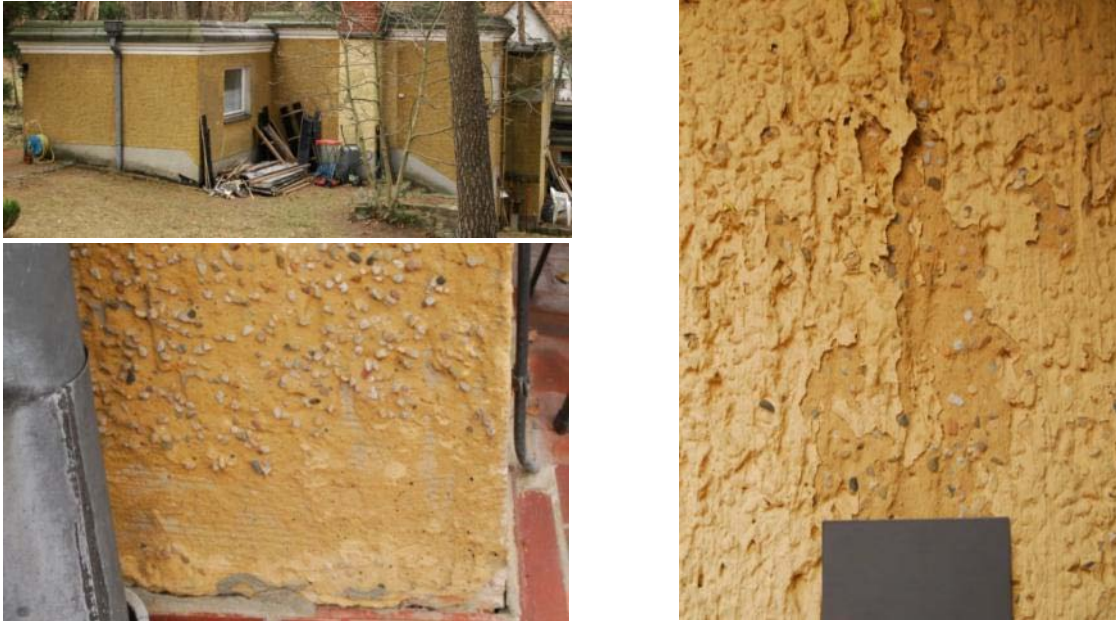
Abb. 249: Gartenhaus Buddh. Haus, Gesamt- und Detailansichten Oberputz, 2011
