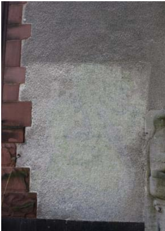
Abb. 137: Partielle Überfassung an der Johann-Peter-Hebel-Grundschule & Cäcilien-Grundschule (Objekt-Nr.: 4302).
