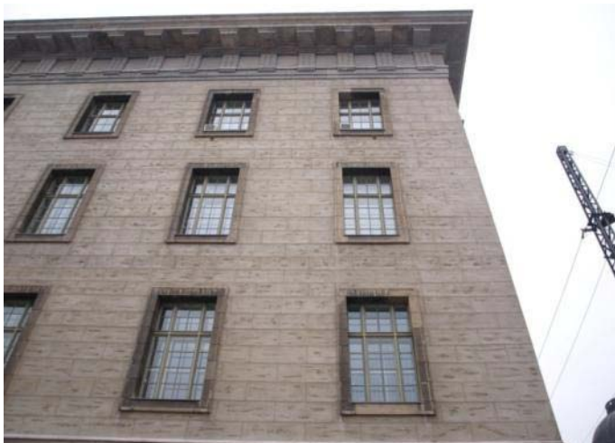
Abb. 484: In den 1980er Jahren erneuerter Steinputz Ostfassade Mittelbau Nord
