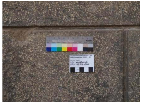
Abb. 502: Detail der Quaderung mit Scheinfugen
