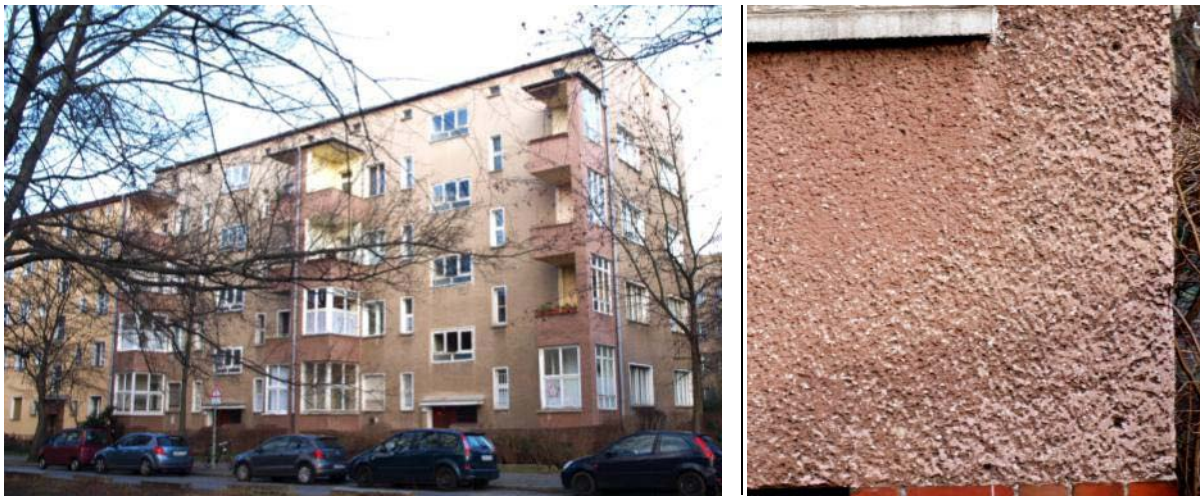
Abb. 216: Fassaden mit alten Edelputzen Ocker und Rotbraun; Bebauung an der Karlstadter Str. 4 (Kastanienhof)
