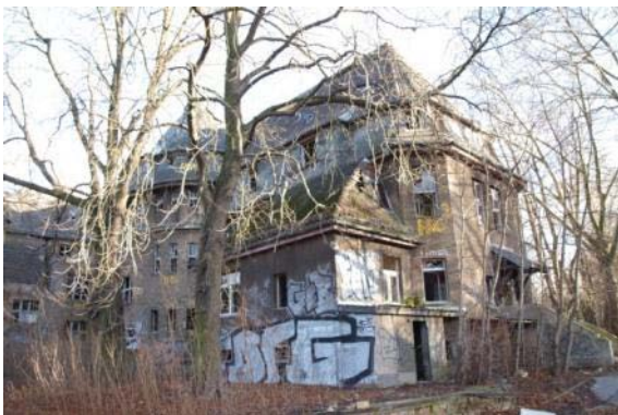
Abb. 143: Graffiti an dem verfallenden Gebäude des Säuglingskrankenhauses in der HansasträÙe (Objekt-Nr.: 4006).
