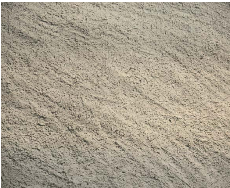
Abb. 51: leicht diagonal strukturierter Rappputz
