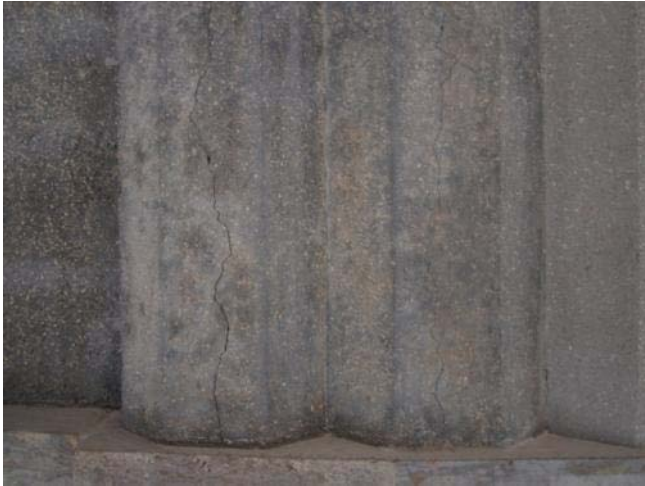
Abb. 495: Steinputz Nordfassade Nordflügel Triglyphenfries, links Auswaschungen und aktuell erneuerter Bereich
