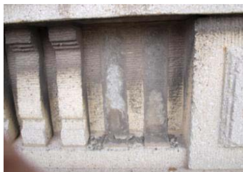
Abb. 257: Wertheim-Haus Lehrter Straße, Berlin-Moabit, rechts Schmuckelemente aus Vorsatzbeton
