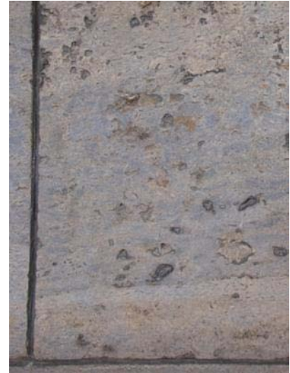
Abb. 480: Detail Südfassade NF
