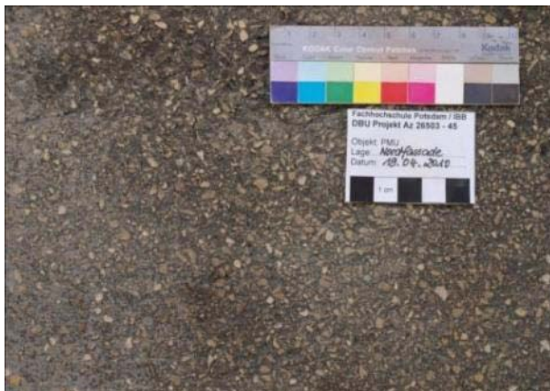
Abb. 499: Steinputzoberfläche mit sichtbarer Körnung, zum richtigen Zeitpunkt durchgeführte OF-Bearbeitung
