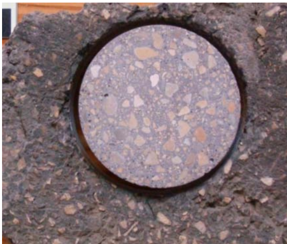
Abb. 567: Vergleich Steinputzmörtelprobe PrMi 04 mit Fragment Bestandsputz (bewitterte Oberfläche).
