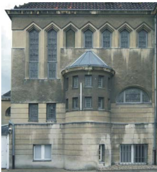
Abb. 371: Lessing-Loge, Ostfassade, vor Bearbeitung
