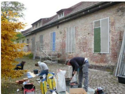
Abb. 153: Musterfelder am Casinogebäude der FHP
