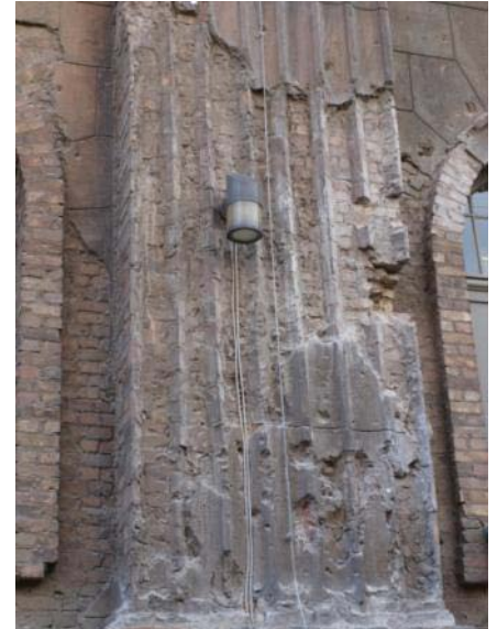
Abb. 490: starke Zerstörung an der Kannelurenmauerung Pilaster 14, 2010
