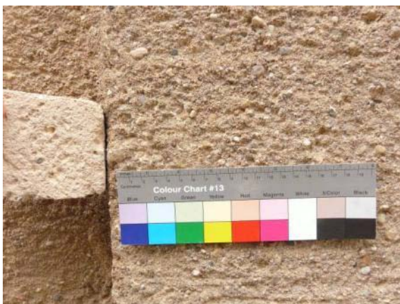
Abb. 475: Liebermann-Villa, links im Bild nachgestellter Edelputz auf Probepatte, rechts im Bild Originalputz in situ
