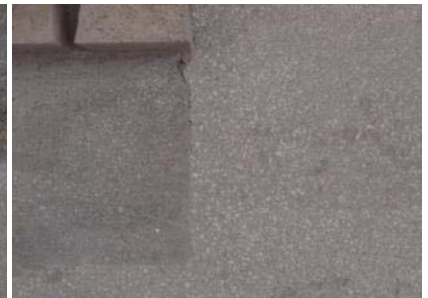
Abb. 511: links bauzeitlicher Putz, rechts Typ C mit hellen feinen Zuschlägen; Bindemittel etwas dunkler als bei Typ B
