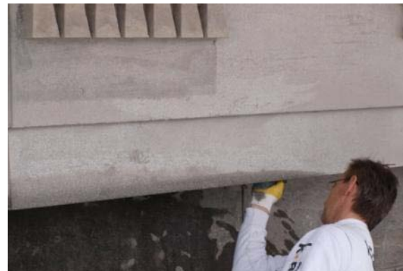
Abb. 515: anschließender Feinschliff mit Schleifsteinen, Sanierungsarbeiten 2009/2010.
