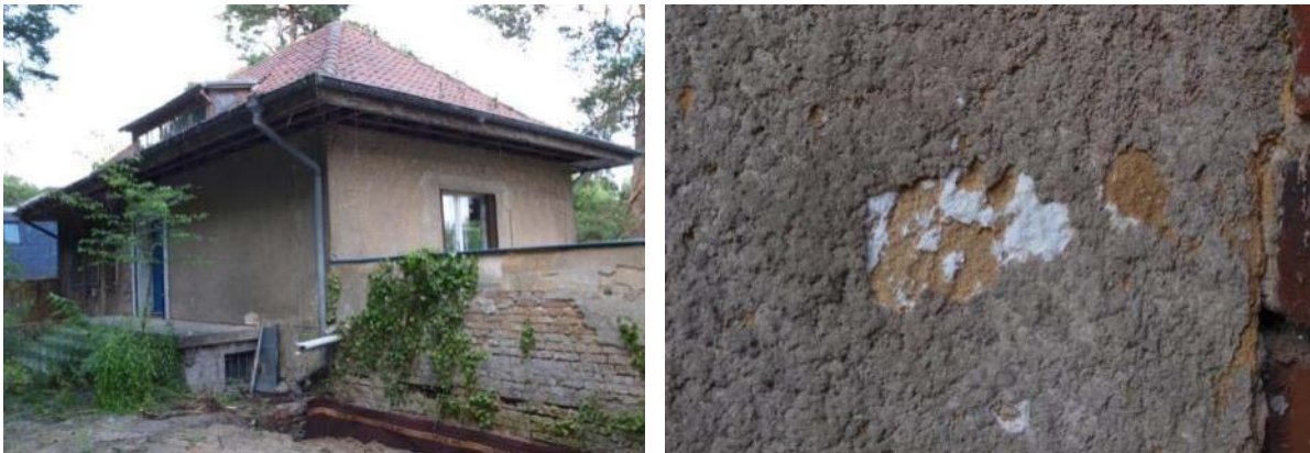
Abb. 239: Landhaus Abraham, Straßen- und Terrassenfassade und Detail überspritzter Originalputz, vor Sanierung 2010
