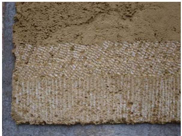
Abb. 166: Steinmetzmäßig bearbeitete Probefläche der Steinputz- Baustellenmischung rechts gelber Granit mit Grauzement (Nr. 17)
