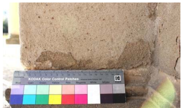
Abb. 127: Schalenbildung an der Orangerie im Park Sanssouci (Objekt-Nr.: 3103).
