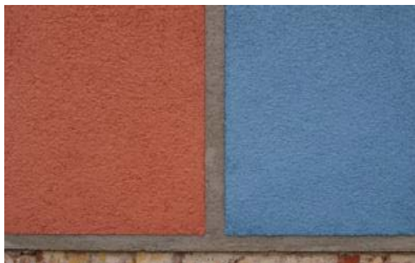
Abb. 157: Probefelder mit Putz der Fa. Sakret (Nr. 7 u. Nr. 6)
