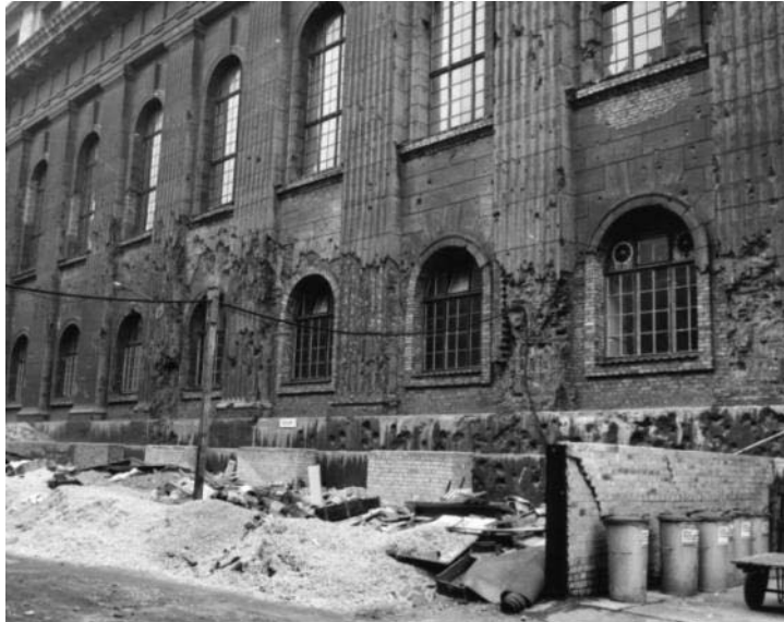
Abb. 489: historische Aufnahme der Nordfassade mit sichtbaren Kriegsschäden (Datierung unbekannt)
