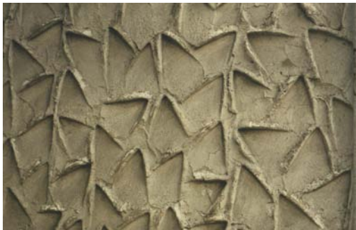
Abb. 27: Ein Kellendruckputz mittels Dreieckskelle ausgeführt
