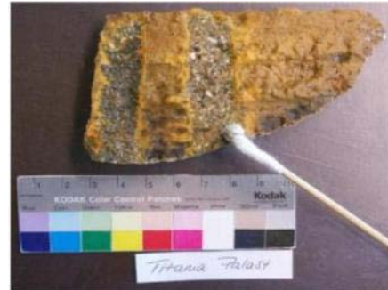
Abb. 387: Links Probefeld mit Gipskruste, rechts Probefeld mit sichtbarer Steinputzoberfläche
