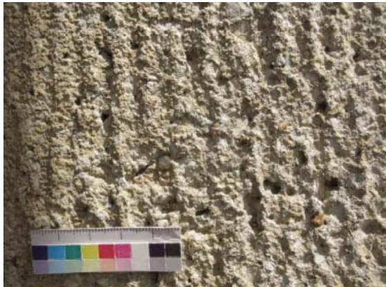
Abb. 270: KuFa 03, Kunstwerksteinfelder: Guss- / Stampfverfahren, scharriert; Gesims: Handantrag, Schablonenzug, scharriert
