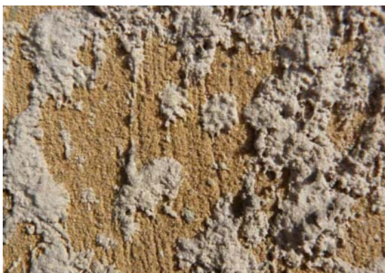
Abb. 462: Detailaufnahme des historischen Edelputzes mit Spritzbewurf
