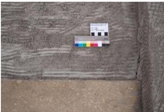
Abb. 512: Unterputz für den Steinputzergänzungsmörtel Typ C
