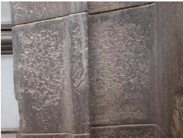
Abb. 496: Steinputz Nordfassade Nordflügel Pilasterreihe, Auswaschungen, an den Rändern dunkle Krustenbildung
