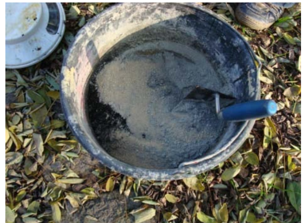
Abb. 535: Trockenes Vormengen der Mörtelmischung aus Splitt, Bindemittel und Pigment.
