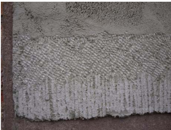
Abb. 165: Steinmetzmäßig bearbeitete Probefläche der Steinputz-Baustellenmischung Alpengrün mit Grauzement (Nr. 15)
