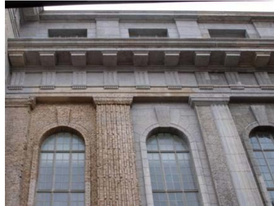
Abb. 517: Triglyphenfries nach Abschluss der Arbeiten 2010.
