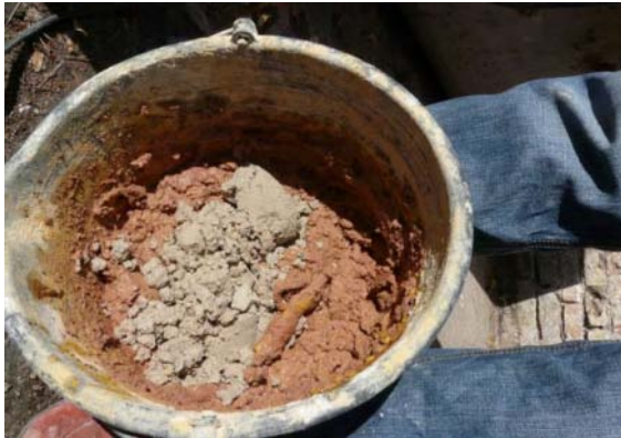
Abb. 464: Anfertigen der Baustellenmischung
