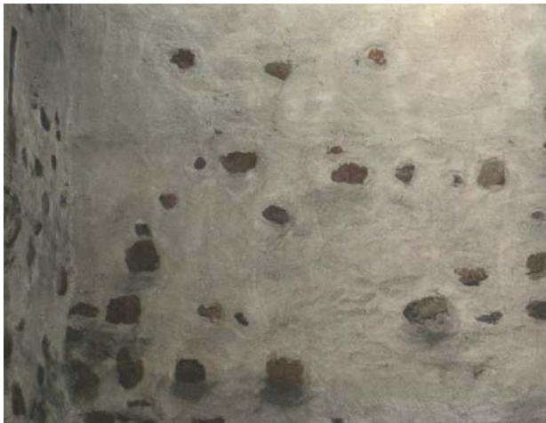
Abb. 18: Natursteinmauerwerk ist im Kellenglattstrichputzes integriert
