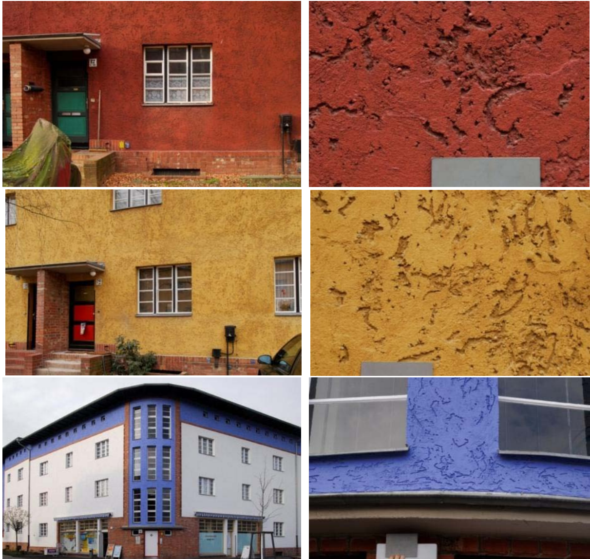
Abb. 176: Hufeisensiedlung Berlin-Britz, Fassaden mit neuen Edelputzen in Rot, Gelb und Blau
