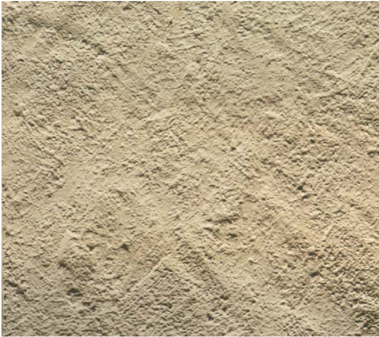
Abb. 50: Rappputz mit erkennbaren Werkzeugspuren
