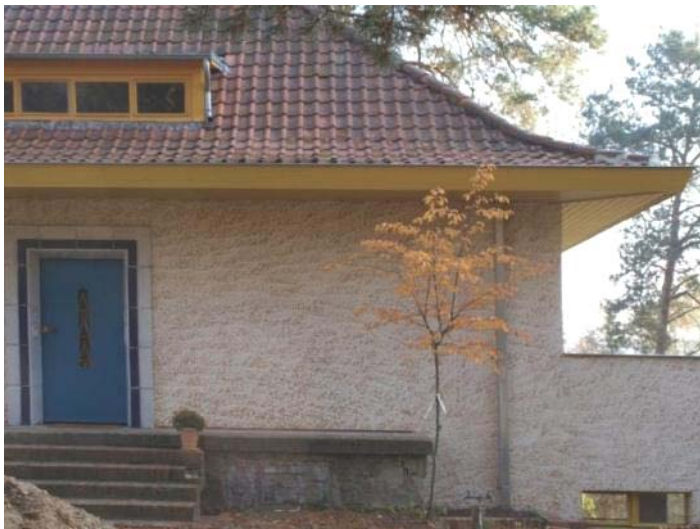
Abb. 468: Handwerkliche Nachstellung mit Werkrockenmörtel, Ausführung Ende 2010
