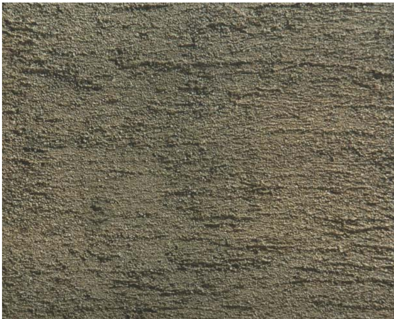
Abb. 54: horizontal verschleppter Putz
