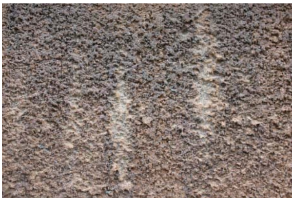
Abb. 399: Schadensbild Gipskrusten mit hellen Läufern
