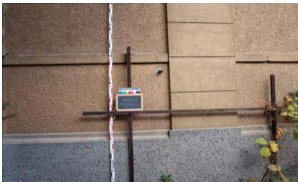
Abb. 402: Ansicht der zu bearbeitenden Wand, Vorzustand
