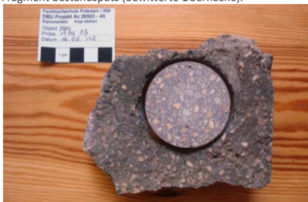
Abb. 557: Vergleich Steinputzmörtelprobe PrMi 03 mit Fragment Bestandsputz (bewitterte Oberfläche).
