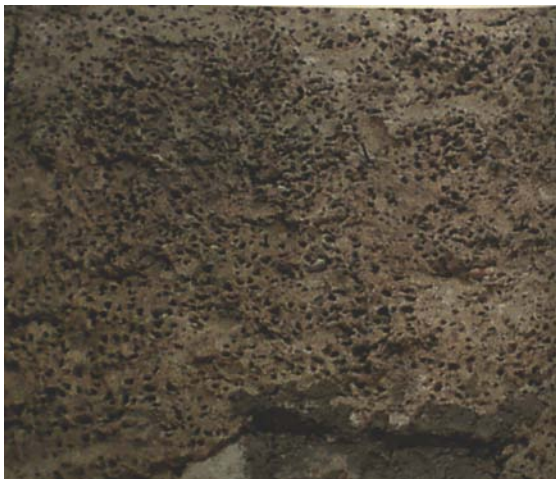
Abb. 44: Kombination aus Kellenwurf-Struktur und Rutenbesenstipp-Strukturen
