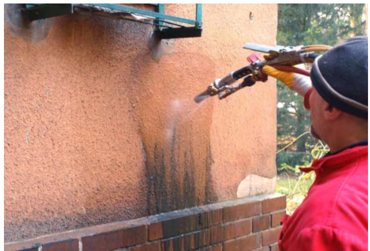
Abb. 412: Maßnahme Feuchtreinigung
