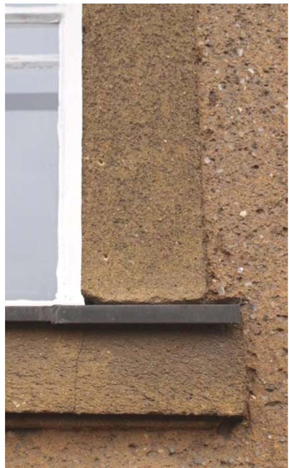
Abb. 471: Wohnhaus Potsdam, gelber Faschenputz (Scheibenputz), rechts Kratzputz in situ
