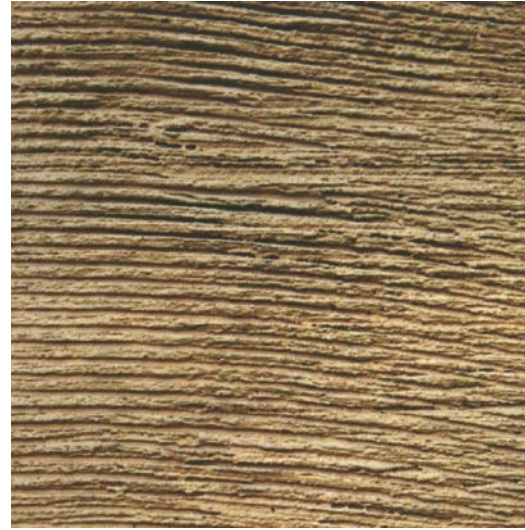
Abb. 35: horizontal gezogener Besenstrichputz
