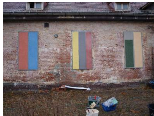
Abb. 156: Edelputzmuster am Casinogebäude der FHP
