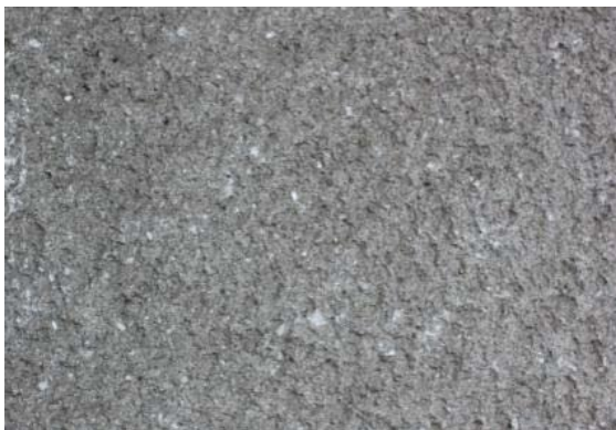
Abb. 70: Kratzputz am sog. „Langen Jammer“, Siemensstadt in Berlin (Objekt-Nr.: 1100)
