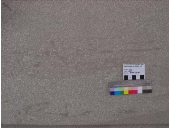
Abb. 516: Oberflächenbearbeitung, Nachstellung der Natursteintextur im Ergänzungsputz Typ C
