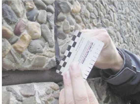
Abbildung 2.2 Fugenabdichtung wenige Millimeter stark
