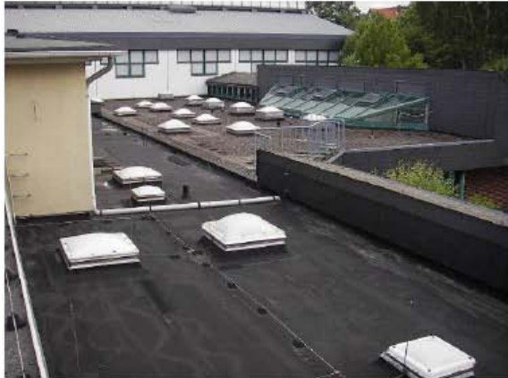
Abbildung 3.1 Überblick Flachdach eingeschossiger Bereich
