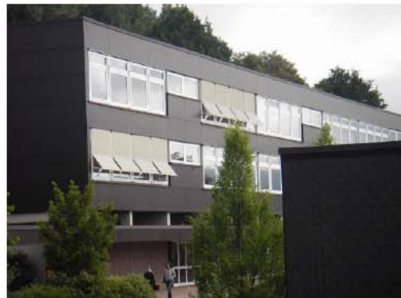
Abbildung 2.24 Bei einer umfassenden Sanierung könnte man sich optisch am Nachbargebäude orientieren.
