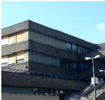
Bild 14: Bestand Fassade Seesen
