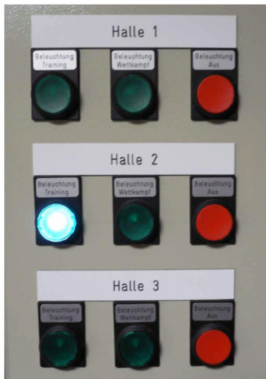
Abbildung 34: Schalttableau der künstlichen Beleuchtung
