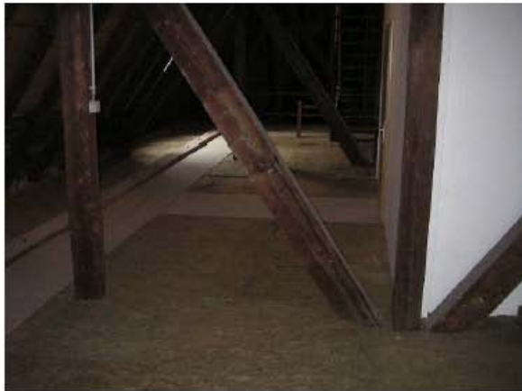
Abbildung 3.7 Gedämmte oberste Geschossdecke des Hauptgebäudes mit begehbarem Streifen
