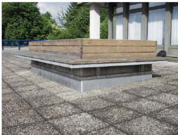
Abbildung 2.9 potentielle Wärmebrücke Oberlicht
