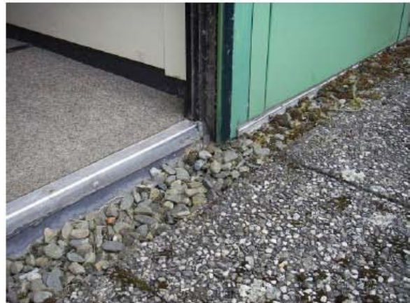
Abbildung 4.10 Anschluss der Abdichtung im Türbereich
