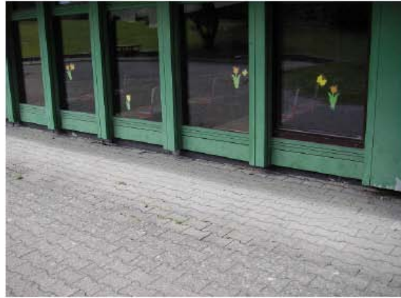
Abbildung 4.14 Die selbe Wand von außen
