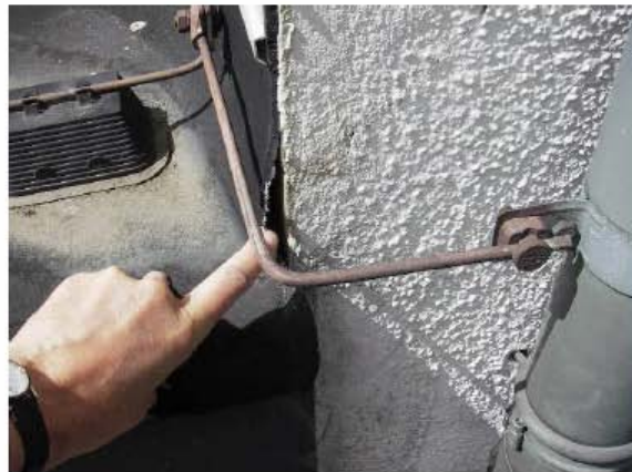
Abbildung 3.4 Fehlender Abschluss rechts
