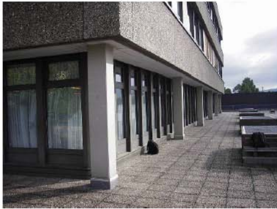
Abbildung 2.7 Stahlbetonstützen durch die Dämmebene
