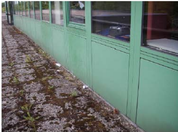
Abbildung 4.7 Flachdach Nordseite und aufgehende Wand Überblick zu den folgenden Bildern
