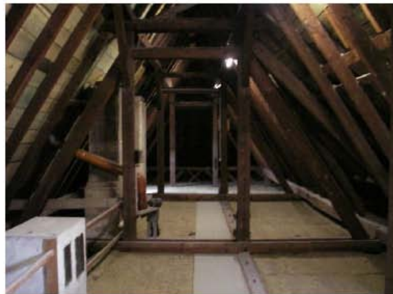
Abbildung 3.6 Gedämmte oberste Geschossdecke des Hauptgebäudes mit begehbarem Streifen
