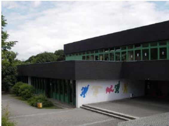
Abbildung 4.1 Eingeschossiger Vorbau auf der Nordseite
