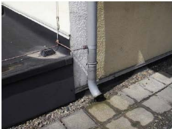
Abbildung 3.3 Anschluss Flachdach an alte Turnhalle
