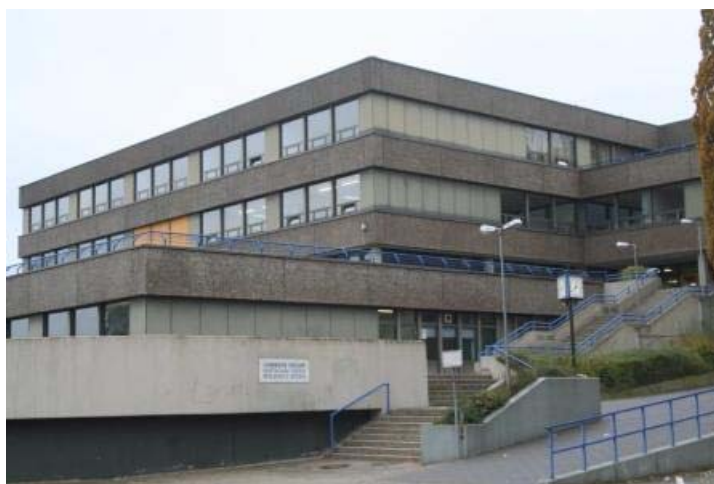
Abbildung 2-1: Eingangsbereich der Haupt- und Realschule Seesen (Süd-Ost-Ansicht)
