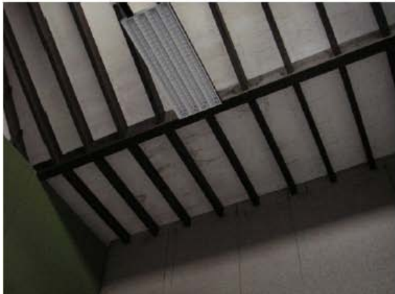
Abbildung 4.17 Holzbauteile im Sporthallendach mit Spuren einer früheren Durchfeuchtung
