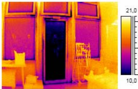
Raum 006 (EG Ostseite)
