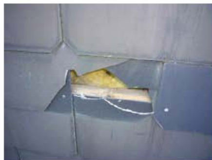
Bild 17: beschädigte Faserzementplatten
