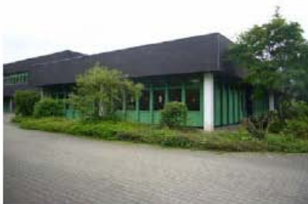
Bild 16: Bestand Fassade Liebenburg
