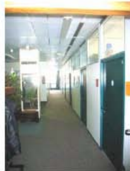
Bild 19: Wand mit Oberlicht
