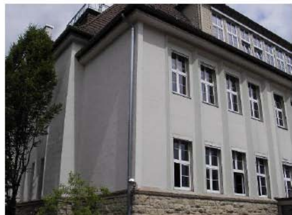
Abbildung 3.12 Noch ungedämmte Fassade(SO) mit Anschluss an die gedämmte Fassade(SW)
