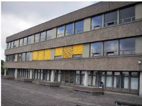
Abbildung 2.23 Jeweils drei Jalousien werden über einen Schalter angesteuert. Die Motoren laufen allerdings verschieden schnell, eine optimale Funktion ist dadurch nicht möglich.
