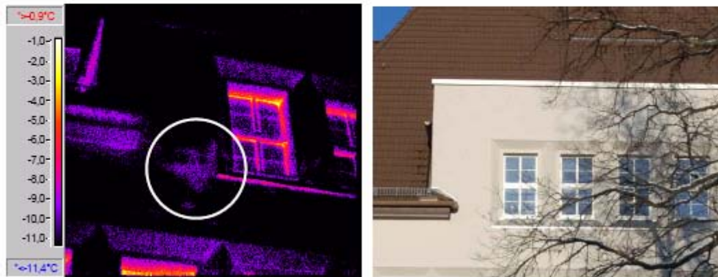
Bild 2.1.2: Detailansicht Fassade Hauptgebäude
