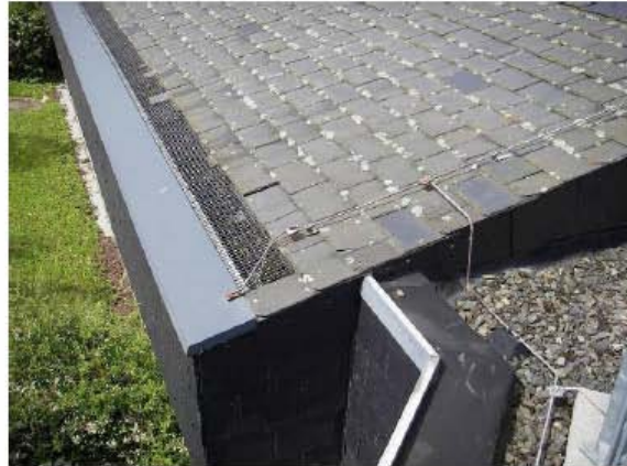
Abbildung 3.2 Dachanschluss im eingeschossigen Bereich.
