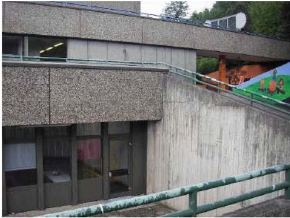
Abbildung 2.19 Aufgang zu Dachterrasse 1. OG NO Überblick zu folgendem Bild
