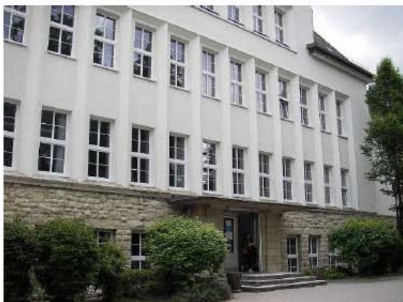
Abbildung 3.11 Bereits gedämmte Fassade (SW)
