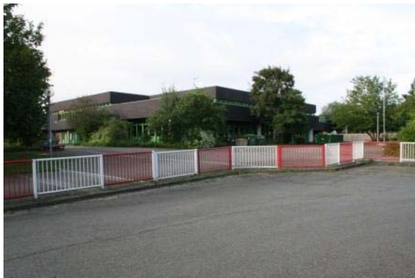
Abbildung 2-3: Eingangsbereich Schulzentrum Schule am Schloss Liebenburg (Nord-Ansicht)
