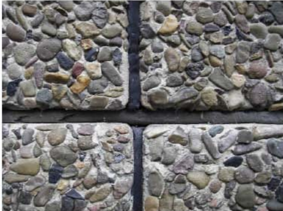
Abbildung 2.1 Fehlende Fugenabdichtung
