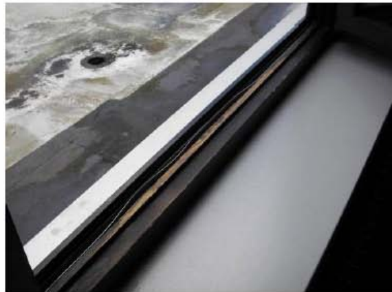
Abbildung 2.4 Fensterflügel im 3.OG – hängt in Beschlägen
