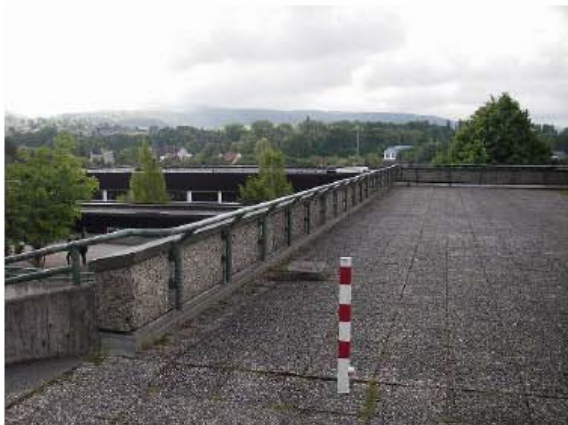
Abbildung 2.17 Dachterrasse 1. OG NO Überblick zu folgendem Bild
