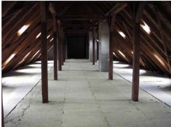
Abbildung 3.9 Gedämmte oberste Geschossdecke des Fachtraktes mit begehbaren Streifen
