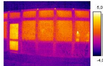
Außentür (1.OG Gang zwischen Raum 105 und 104) einfach verglast
