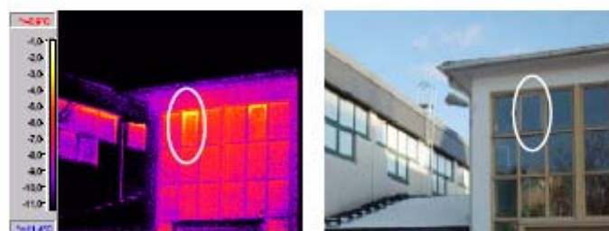
Bild 2.3.3: Detailansicht, erhöhte Temperatur an Kipp-Fenstern der alten Sporthalle
