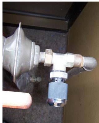
Abbildung 41 Thermostatventil Klassenraum
