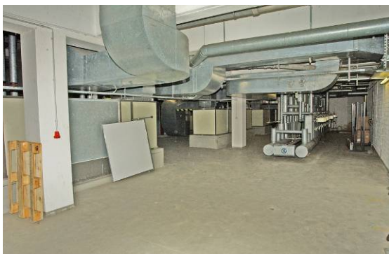
Abbildung 44 Lüftungsanlagen UG
