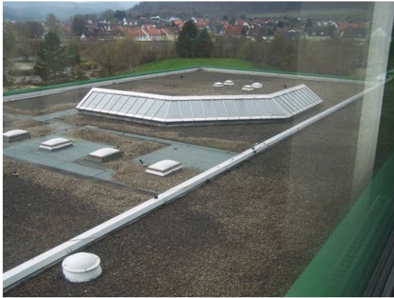
Abbildung 19 Dach EG Forum
