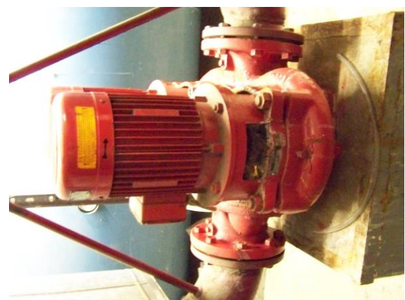
Abbildung 36 Heizkreispumpe
