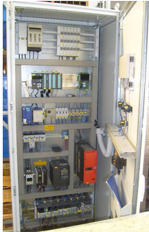
Abbildung 6: Schaltschrank Innenansicht
