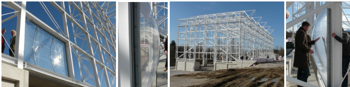
Abb. 3-5: montiertes MRM am Stahlbau der Bergwacht Bad Tölz
