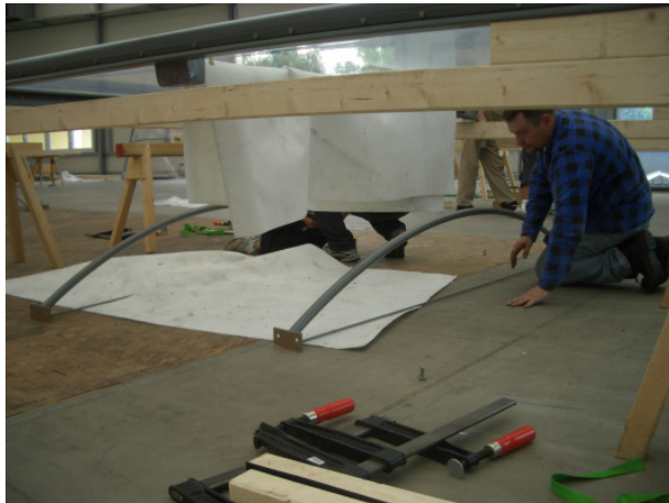
Abb.61 Montagevorbereitung der Bögen
