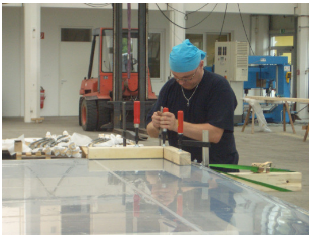
Abb. 59 Die Folie wird an eine äußeren Montagerahmen gespannt und fixiert
