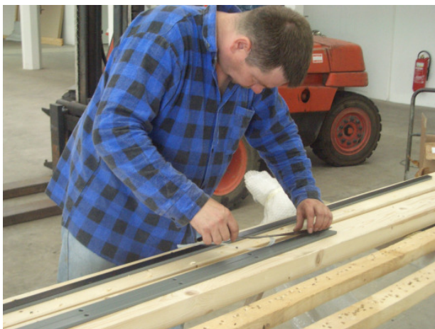
Abb. 60 Vorbereitung der Klemmschienen Aufkleben der EPDM Dichtungen
