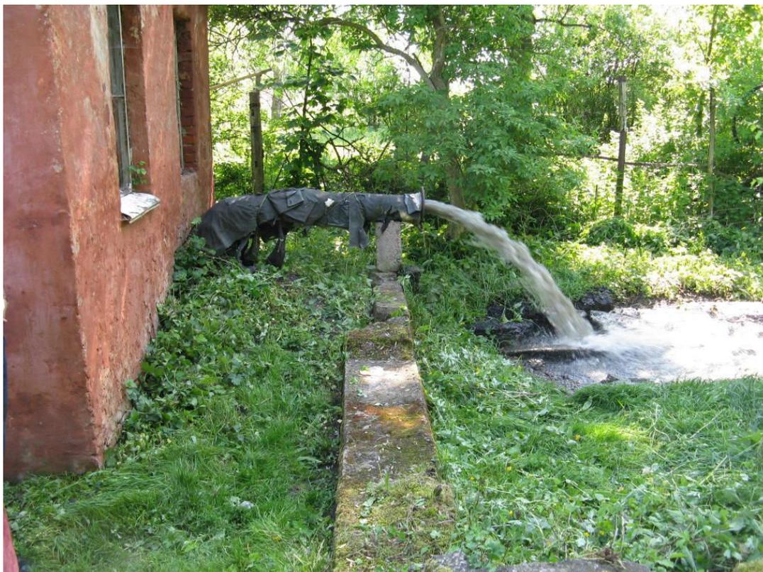
**Abb. 29: Ableitung ungereinigten Abwassers nach der Kläranlage Primorsk**
