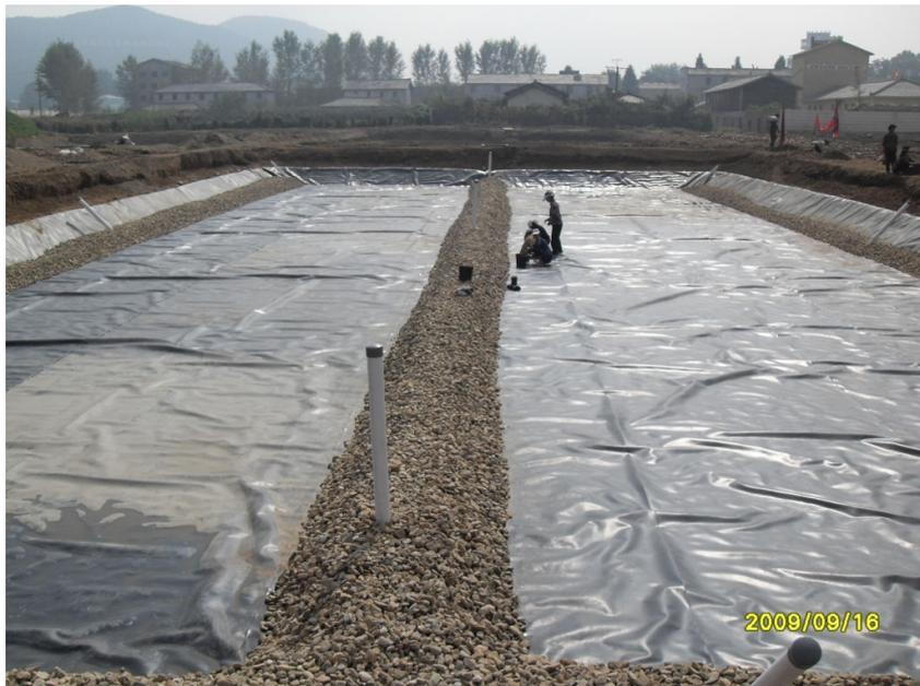
**Abb. 3: Bodenfilteranlage Yontan, Nord-Korea für 3.500 Einwohner**
