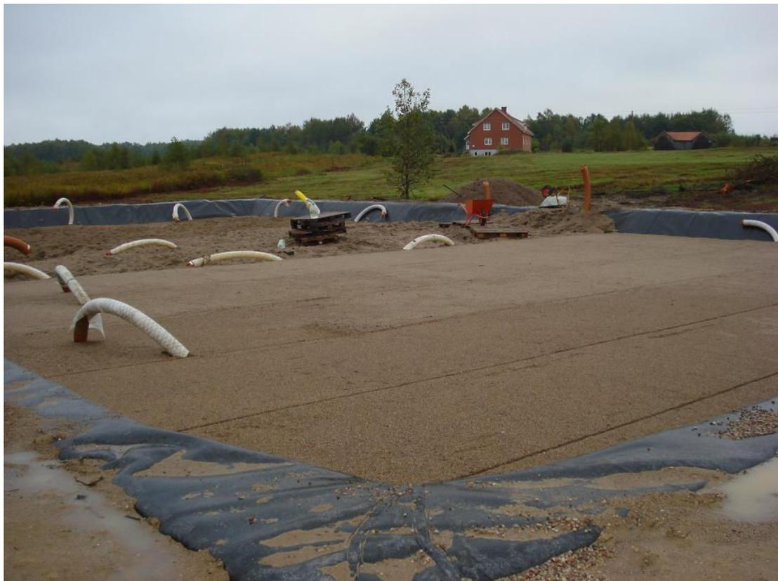
**Abb. 21: Herstellung des Bodenfilters, Filtersandoberfläche**
