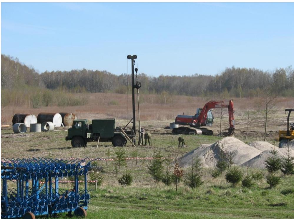
**Abb. 9: Baugrunduntersuchung auf Kläranlagengelände**
