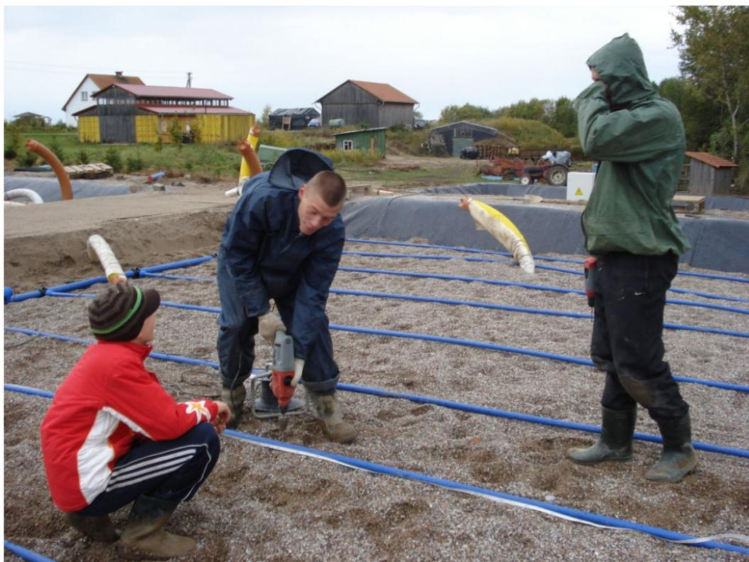
**Abb. 22: Herstellung des Bodenfilters, Installation Beschickungssystem**
