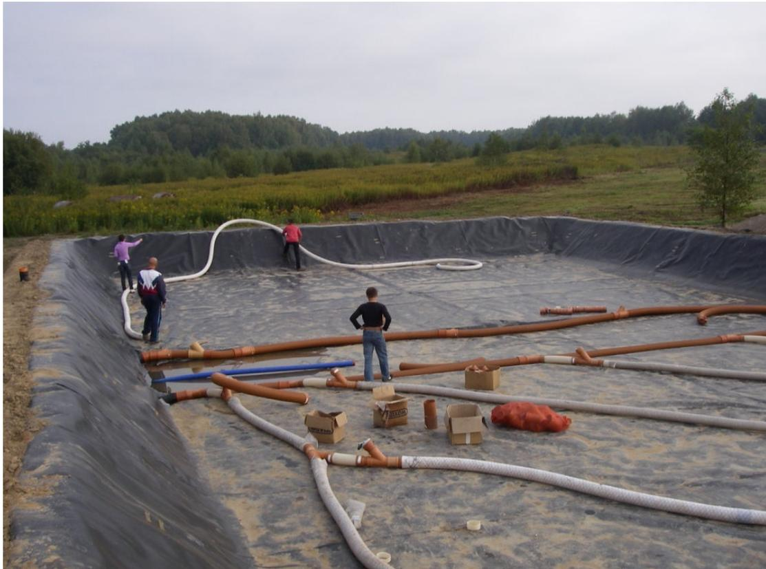
**Abb. 17 +18: Bodenfilter gedichtet, Verlegung des Dränsystems auf der Sohle**
