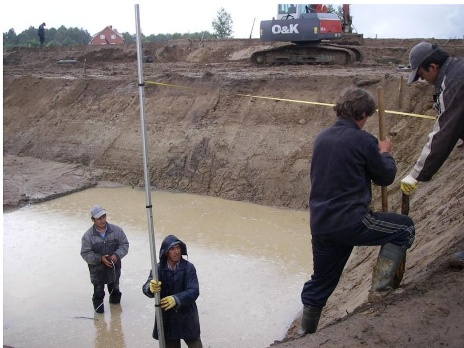
**Abb. 14: Herstellung des Abwasserteiches, usbekische Bauarbeiter kontrollieren die Abmessungen**
