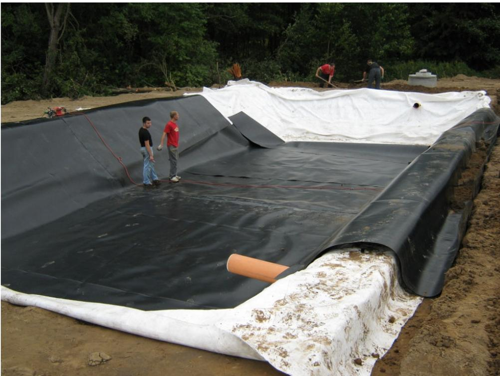
**Abb. 16: Herstellung des Nachklärteiches, Verlegung Schutzvlies und PE-Folie**
