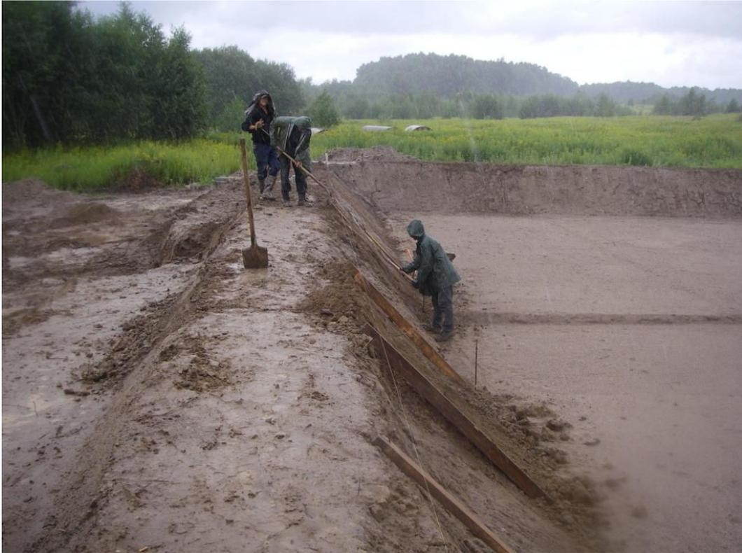
**Abb. 15: Herstellung des Erdbeckens des Bodenfilters**
