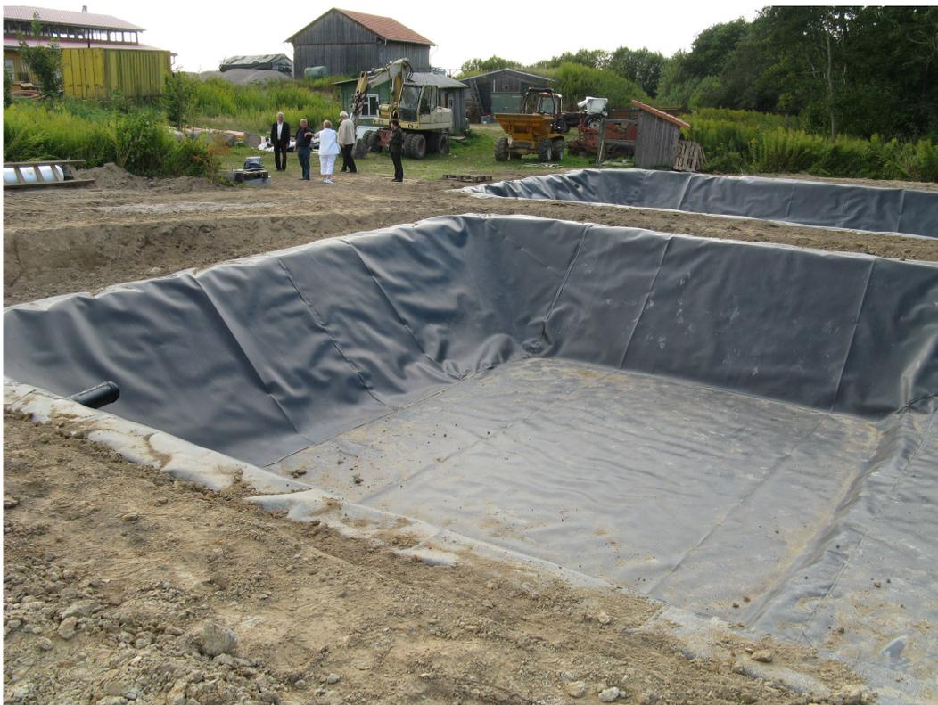
**Abb. 19: Vor- und Nachklärteich gedichtet, im Vordergrund Schlammfänge**
