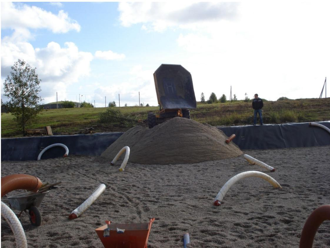
**Abb. 20: Herstellung des Bodenfilters, Einbau Filtersand**
