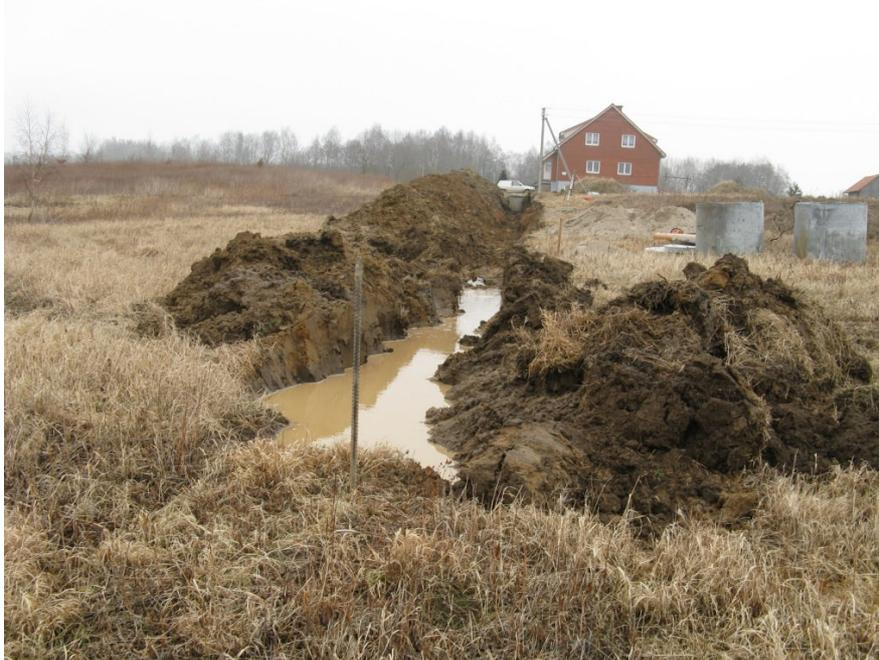
**Abb. 12: Hoher Grundwasserstand**
