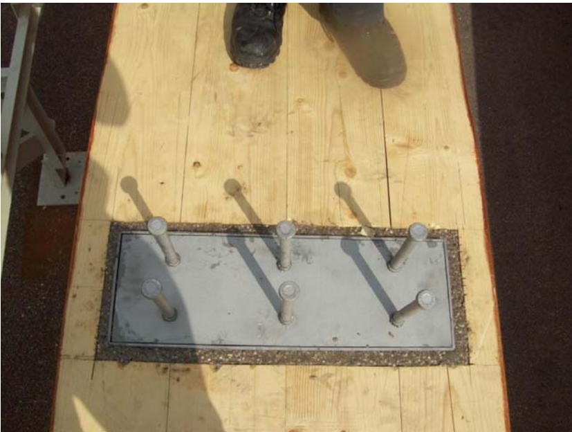
Bilder 70 und 71: Herstellung der Blockbalkenträger
