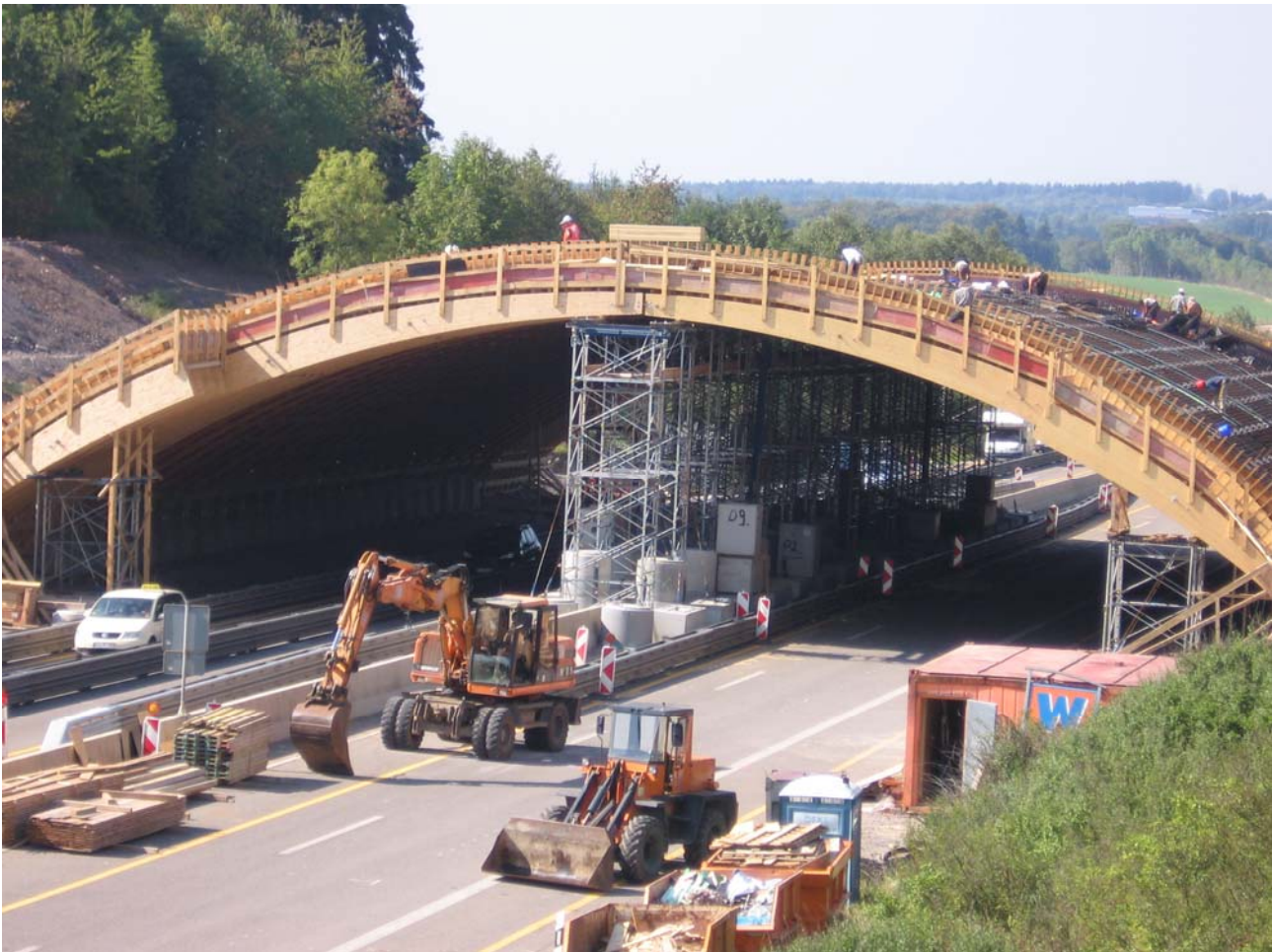
Bild 62: Bau der Bogenträger
