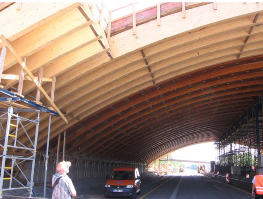
Bilder 65 und 66 sowie 67 und 68 folgend: Fertigstellung der Montage der Bogenträger
