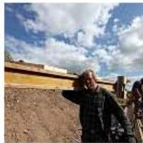
Die Vorbereitungen fürs Betonieren der Wildbrücke laufen auf Hochtouren. Unter anderem werden Vorrichtungen für die Betonglättung gebaut. (Bild: Hilgers)
