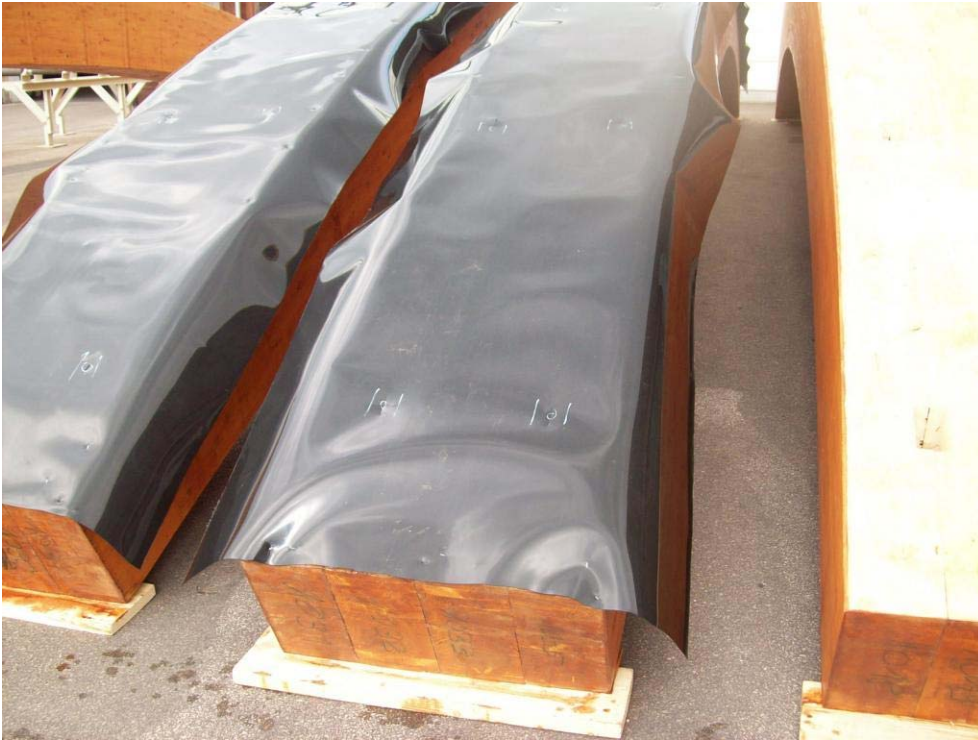
Bild 73: Blockträger mit Schutzfolie
