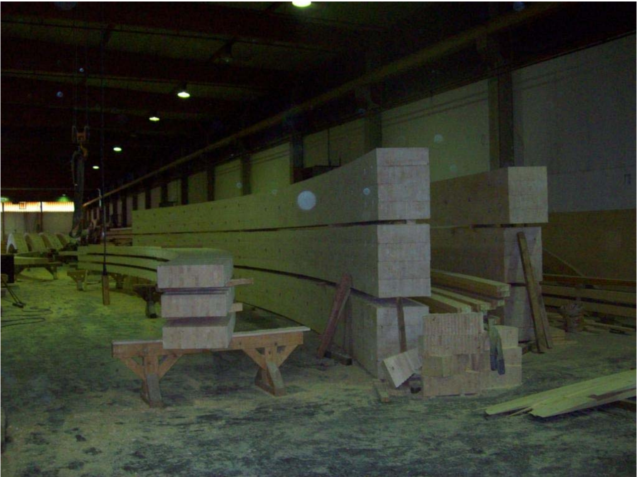
Bild 72: Herstellung der Träger im Werk
