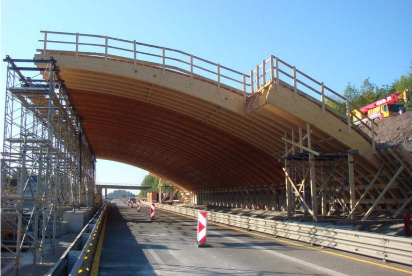
Bilder 40 und 41: Montage der Bogenträger
