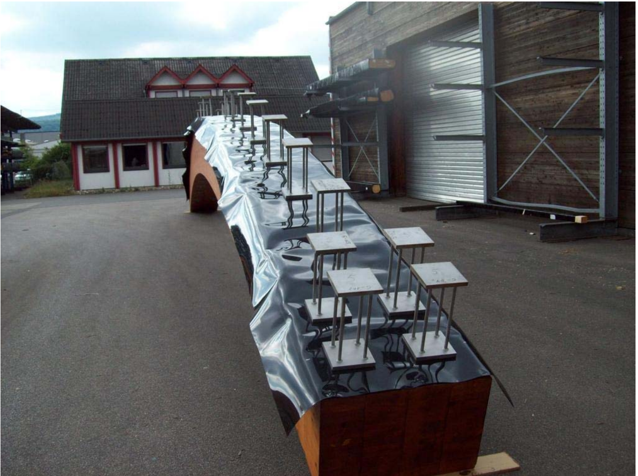
Bilder 70 und 71: Herstellung der Blockbalkenträger
