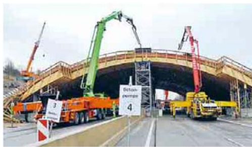
Aus vier Pumpen gleichzeitig wurde der Beton auf die Unterkonstruktion aus Holz und Stahl gegossen.
