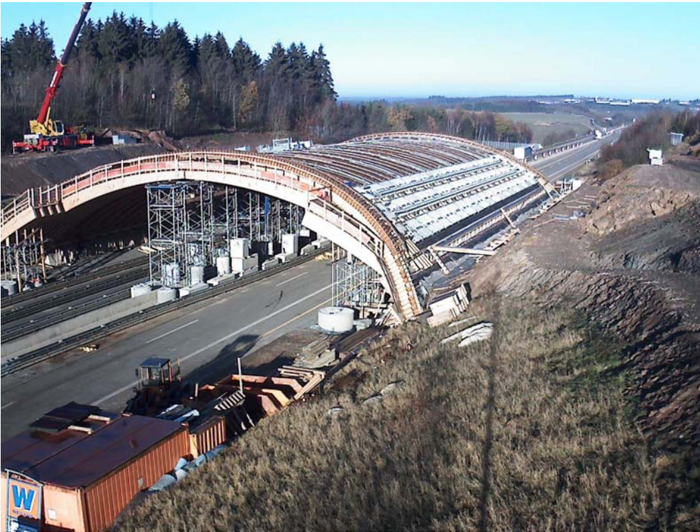
Bild 42: Vorbereitung der Betonage
