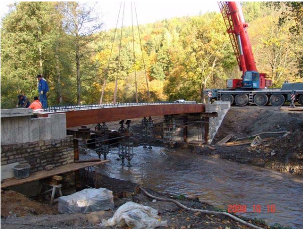
Bilder 50 bis 55: Montage der Brettschichtholzträger
