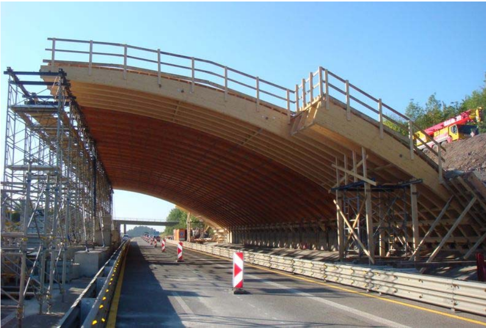
Bild 63: Montage der Bogenträger
