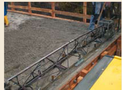
Überbaubetonage →
