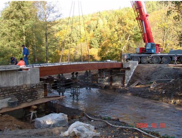
Bild 32 bis 37: Montage der Brettschichtholzträger
