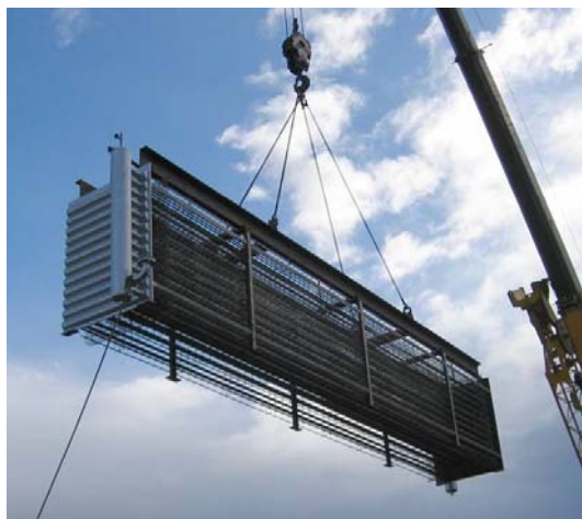
Bild 5.4: Rohrregister 400 kWh, Testmodul vor dem Vergießen mit Beton
