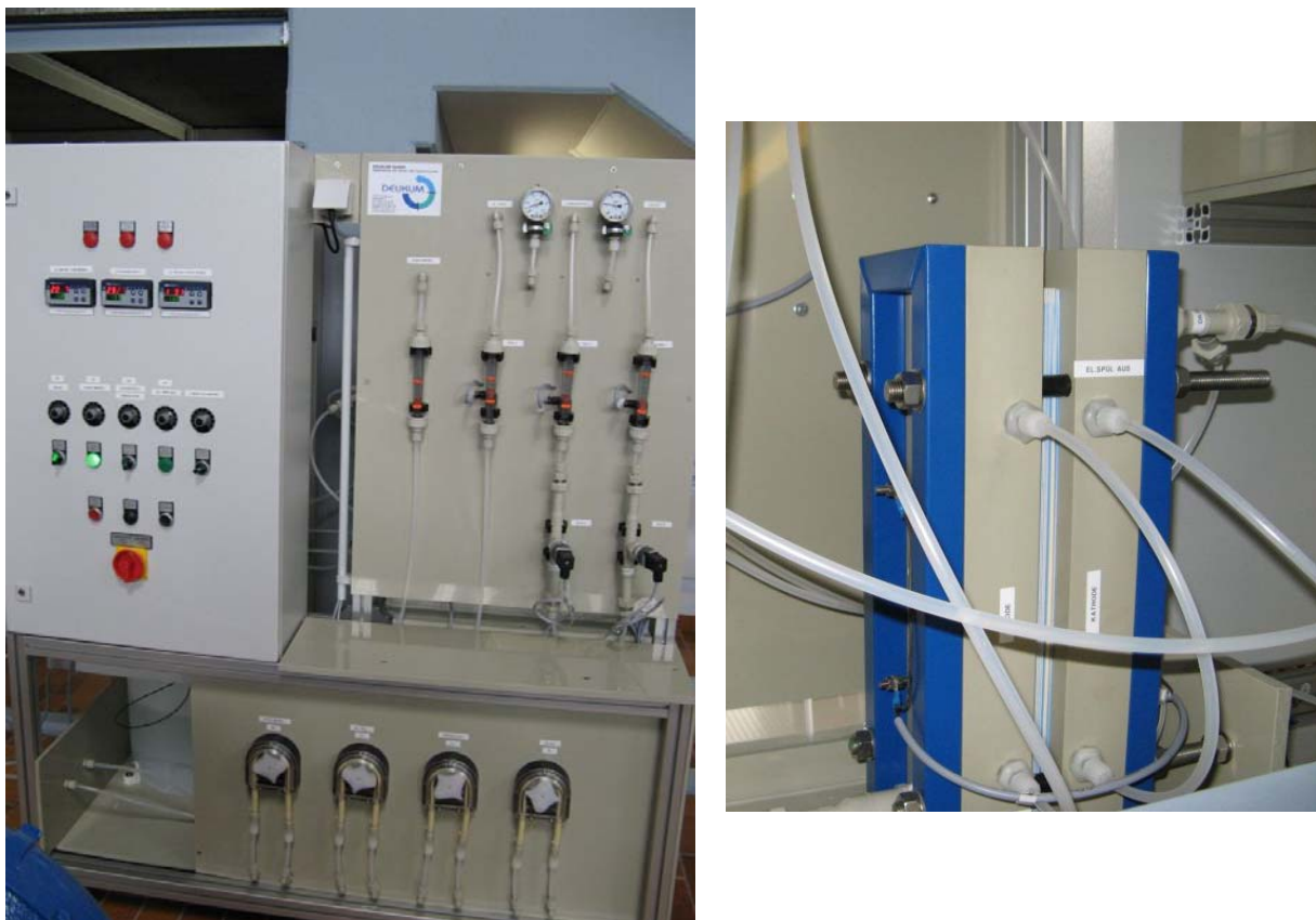
Bild 3.5: Ansichten der ED-Pilotanlage.
