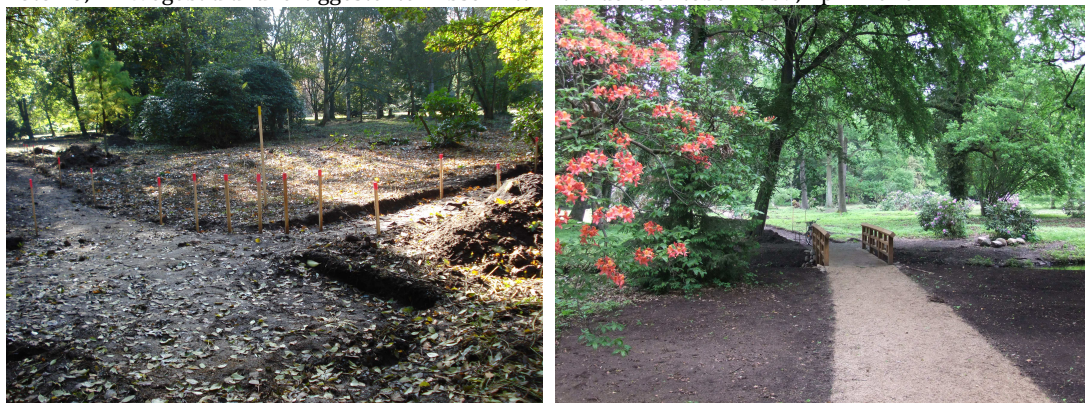
Foto 23,24: Wegebau und fertiggestellter Abschnitt mit Brücke Oktober 2009, April 2010
