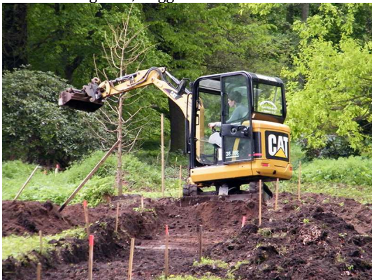
Foto 12: Wegebau, Baggerarbeiten
