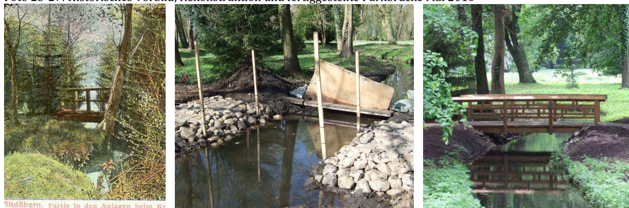
Foto 25-27: Historisches Vorbild, Rekonstruktion und fertiggestellte Parkbrücke Mai 2010
