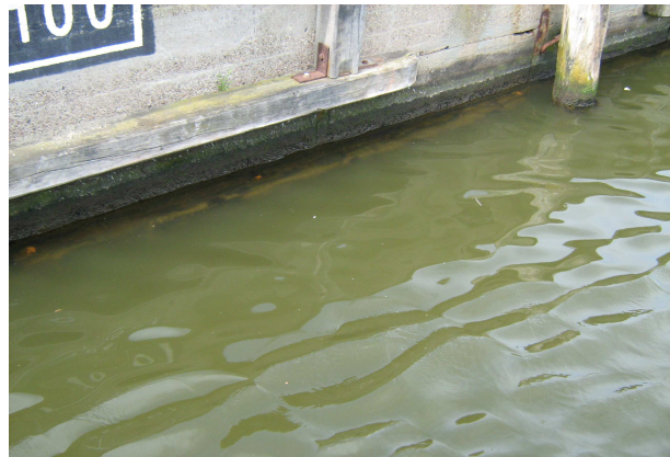
Abbildung 34: Ansicht der Kaikante am vorgesehenen Arbeitsort
