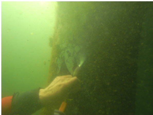
Abbildung 12: Reinigung mit Hochdruckreiniger: Wirksamkeit nur auf kurze Distanz
