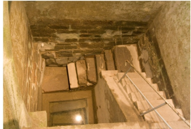
Abb.: 4 oben: Nach der Restaurierung unten: Tauchbecken mit Stufen (bearbeitet nach Schütte, 2012)
