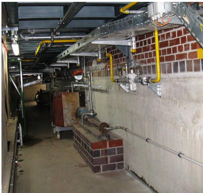
Abbildung 14: Einrichtung zum Auffangen überschüssiger Glasurflüssigkeit.
