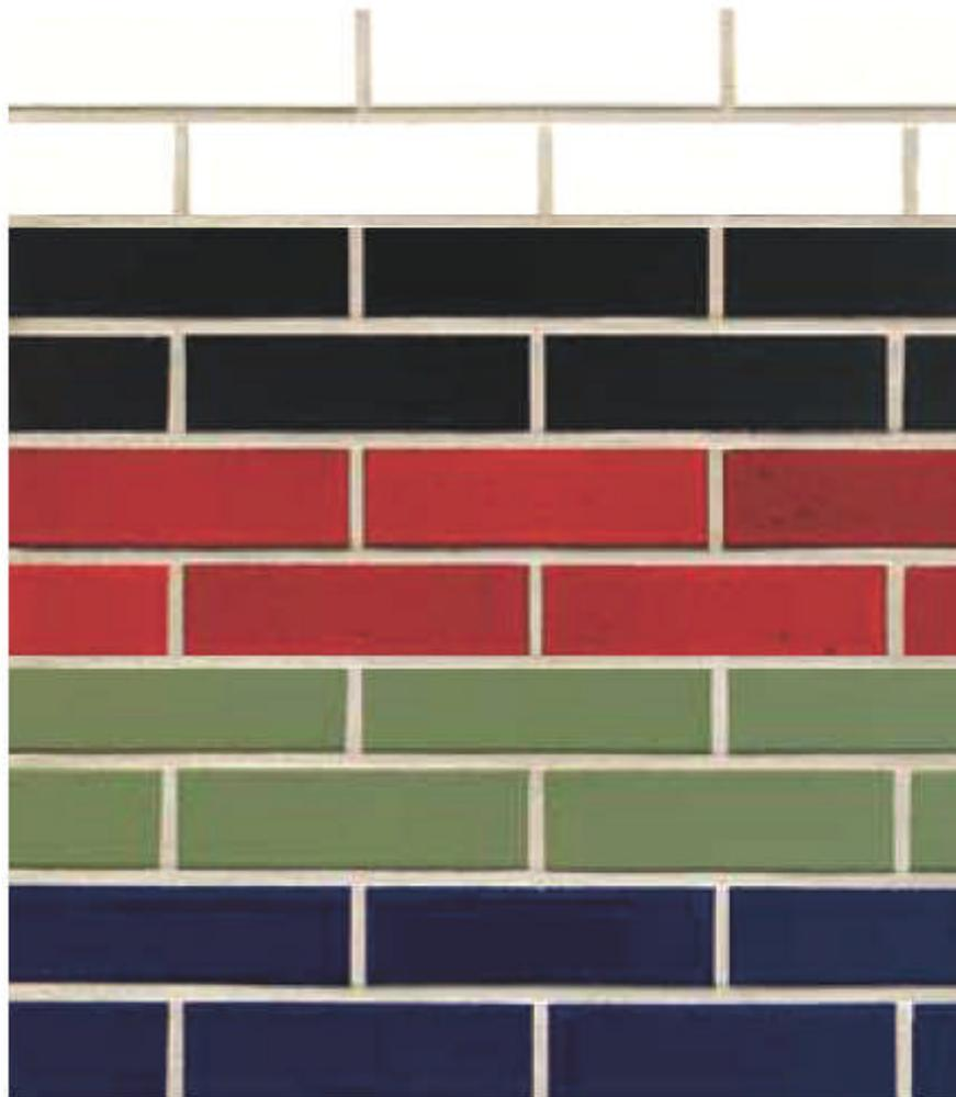
Abbildung 32: Farbvarianten glasierter Riemchen
