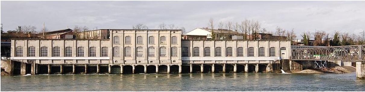
Bild 6: Altes Kraftwerk Rheinfelden (Foto: Wladyslaw Sojka, Quelle: www.wikipedia.org)
