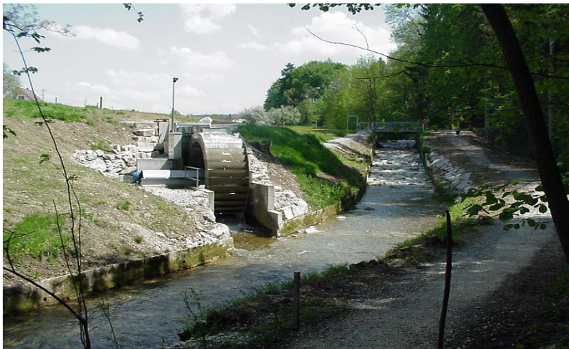
Bild 9: Wasserrad Grüntal (Schweiz) mit Fischaufstieg
