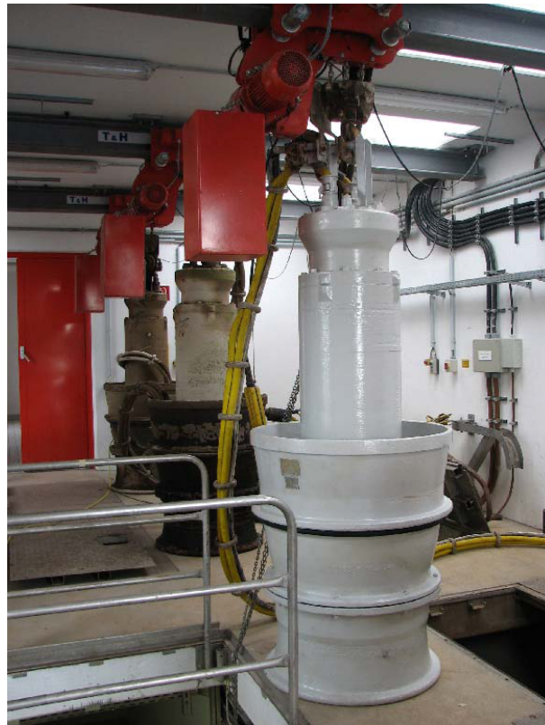
Bild 1: Rohrpropellerpumpen des Typs KSB Amacan
