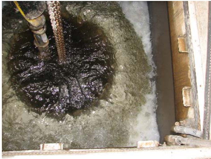
Bild 3: Typische Überfallhöhe am Rohrschacht
