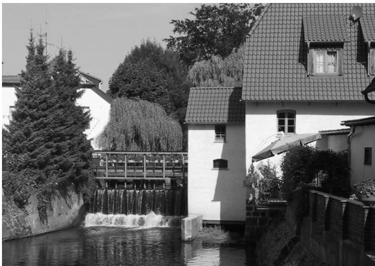
Bild 10: Stauanlage im westfälischen Borken – bisher ungenutztes Wasserkraftpotenzial
