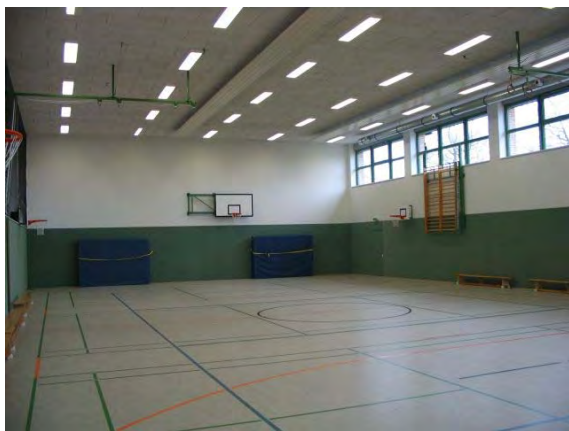
Abbildung 6: Skizze Lage Lüftungsanlage und Innenansichten (Zuluftrohr und zwei Reihen Deckenstrahlplatten)
