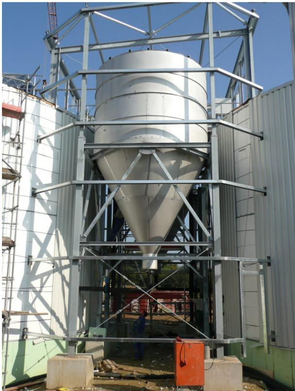
**Abbildung 3: Foto eines FAR kurz vor der Inbetriebnahme. Deutlich erkennbar ist der Trichterbereich über den die Rückführung des sedimentierten Schlammes in den jeweiligen Fermenter erfolgt.**
