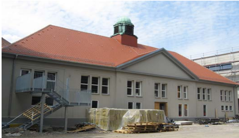
Einbau Mensa in denkmalgeschützte Feuerseehalle und Erweiterung Friedrich-Schiller-Gymnasium | Ludwigsburg
