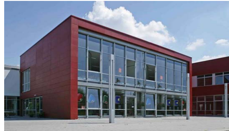
Sanierung, Umbau und Erweiterung Gymnasium mit Neubau Sporthalle | Gernsheim
