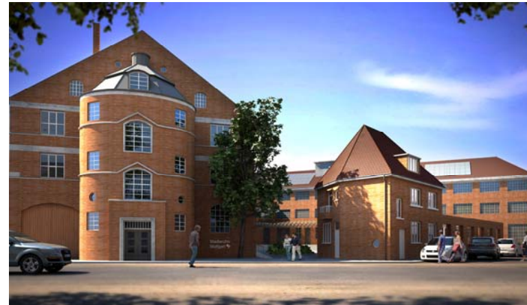
Sanierung des Stadtarchivs Bad Cannstatt | Stuttgart
