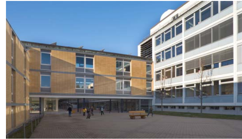
Generalsanierung Kepler-Gymnasium | Pforzheim
