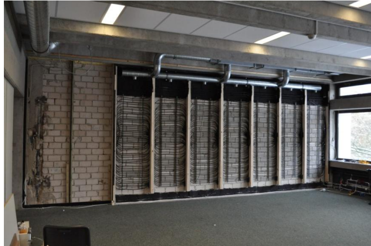
Abbildung 8-3: Ansicht der Klimawand im Rohbau
