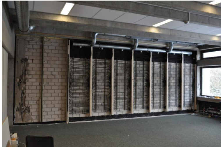
Abbildung 7-29: Ansicht der Klimawand im Rohbau (Sanierung)
