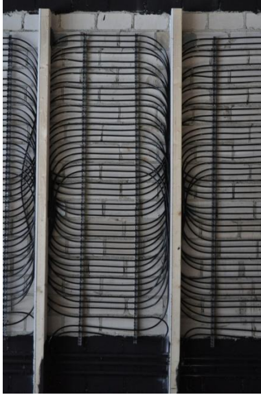
Abbildung 8-2: Schacht der Klimawand im Rohbau
