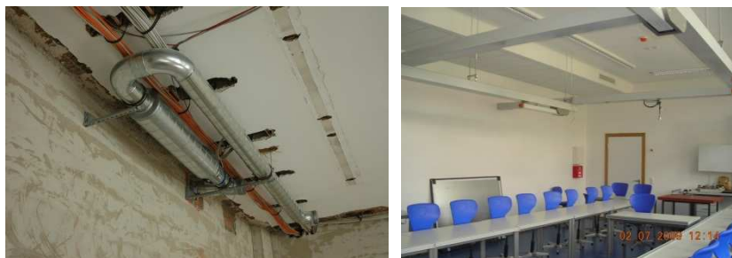
Zeichnung 9 / Bild 27: Lüftungsanlage Klassenräume, Planungsbüro Rauch & Richter
