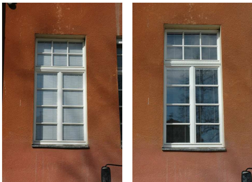
Bild 23: Holzverbundfenster mit ,innenliegender' Jalousie, AB Haase
