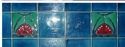
Bild 7 a, b: Flur mit hochwertiger Wandkeramik
