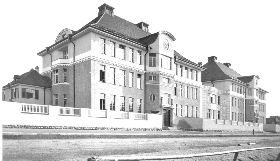
Bild 3: Ansicht von Nordwest / Ludwigstraße
