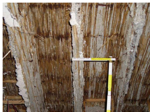
Bild 18: Aufschluss mit kompletter Freilegung der bauzeitlichen Rippendecke, AB Haase
