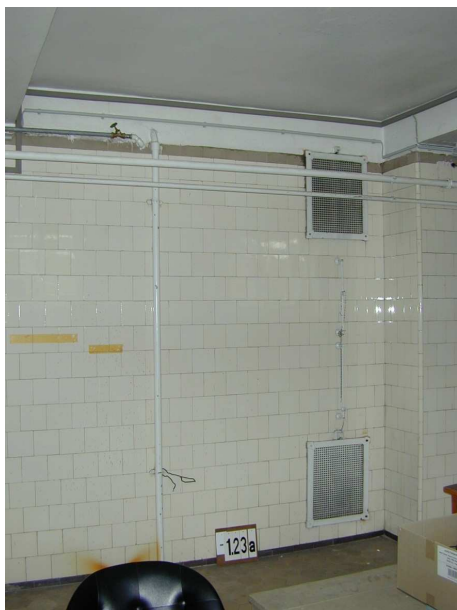
Bild 13: Lüftungsklappen des Ventilationskamins im ehemaligen Schulbad
