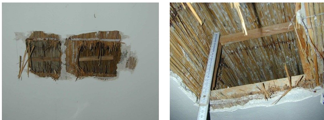
Bild 14: Bestandsuntersuchung bauzeitliche Rippendecke, AB Haase, 2005
