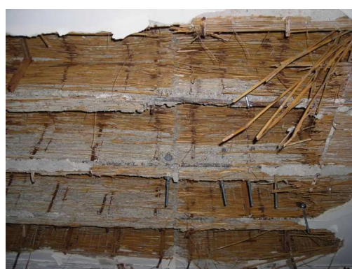
Bild 18: Aufschluss mit kompletter Freilegung der bauzeitlichen Rippendecke, AB Haase
