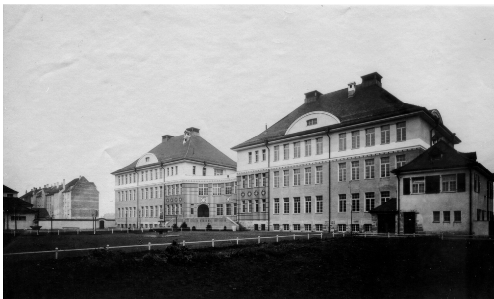
Bild 1: Ansicht von Südost
