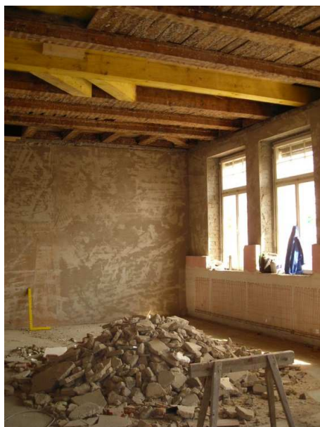
Bild 17: Fertiggestellte Hausschwammsanierung, AB Haase
