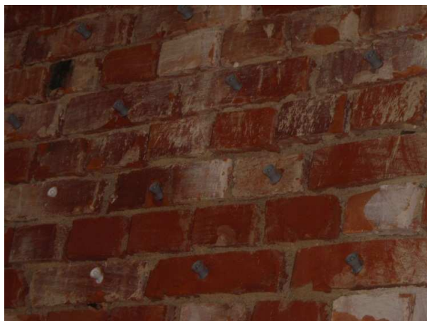
Bild 17: Fertiggestellte Hausschwammsanierung, AB Haase
