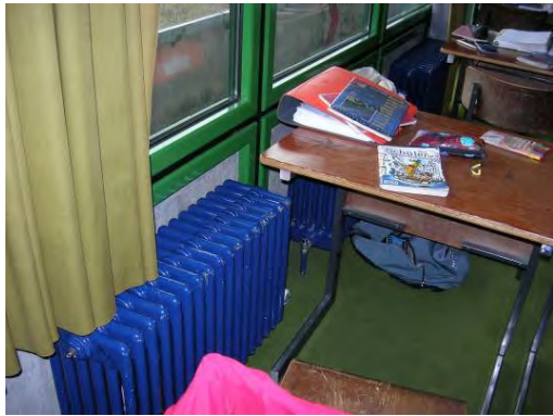
Bild 13 Fassadenelement mit voluminösem Heizkörper, AB Haase
