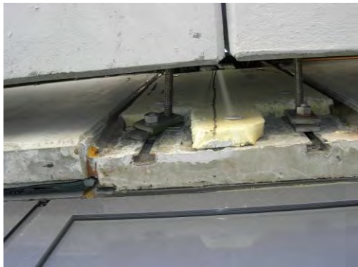
Bild 7 Vorgehängte Attika, AB Haase
