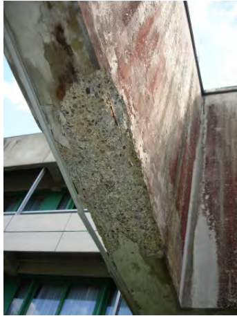
Bild 9 Witterungsexponierte Unterzüge, AB Haase
