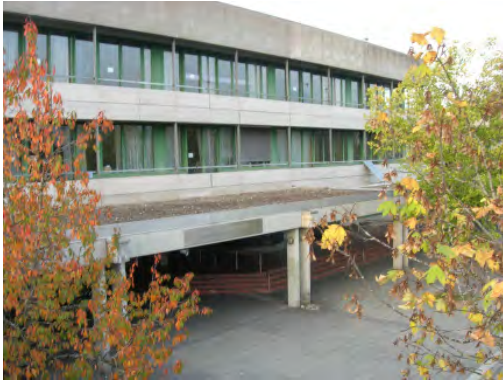
Bild 16 Massive Überdachung im Bereich des Haupteingangs zur Aula, AB Haase
