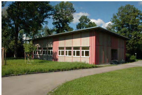
Bild 5 Pavillongebäude, AB Haase
