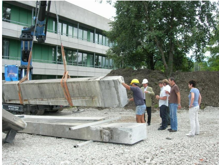
Bild 2: Teilabbruch des Fachklassentraktes
