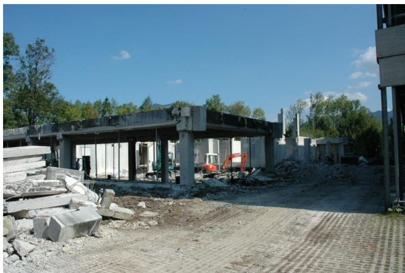
Bild 1: Teilabbruch des Fachklassentraktes
