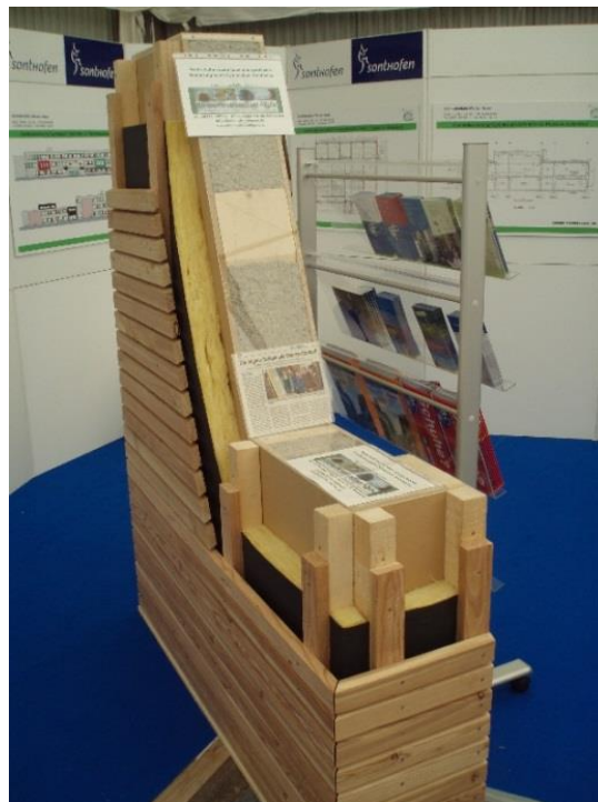
Bild 4: Muster Wandaufbau
