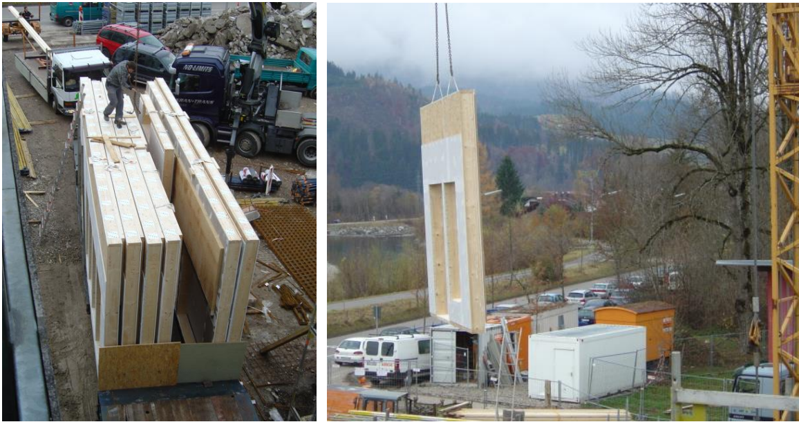
Bild 3: Holz-Fertigteil-Fassade
