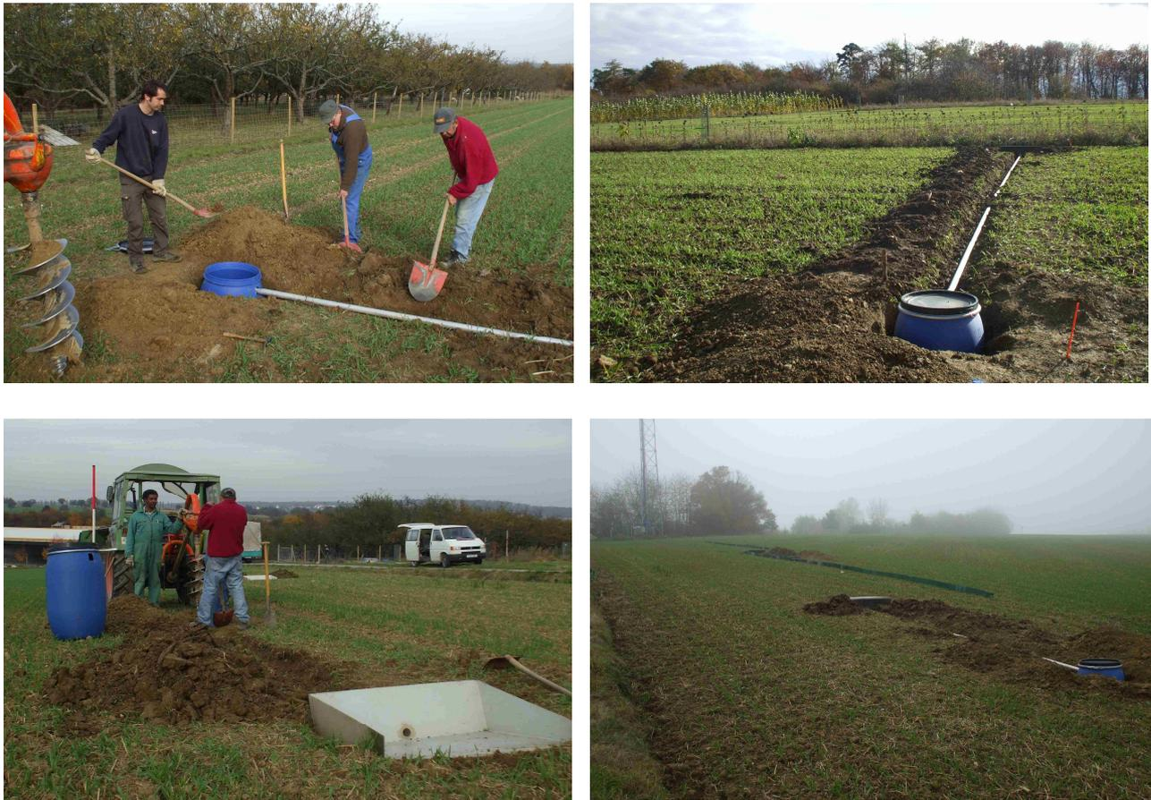
Abbildung 15: Bilder 1 bis 4: Einbau der Feldkästen mit Überlaufassern (oben: Agroforstfläche, unten Nachbarfläche mit seitlicher Begrenzung) Bilder: F. SEIDL
