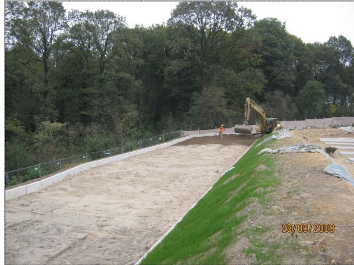
Abb.5.26: Arbeiten zum Versickerungsbecken hinter der nordwestlichen Haftmauer
