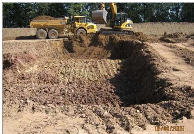
Abb. 5.30: Ausschachten einer Baugrube
