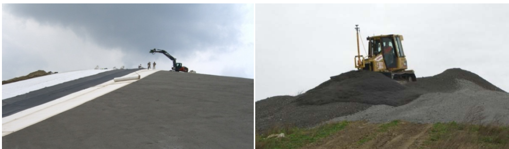
Abb. 5.6: Ablassen einer GTD-Rolle, Einbau der Gasdrän- bzw. Auflagerschicht
