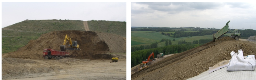
Abb.5.4: Laden und Einbau des Rekubodens
