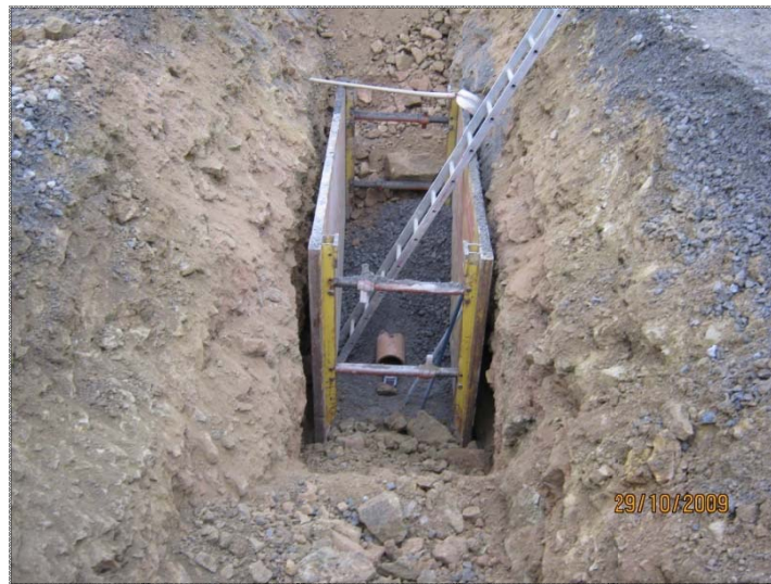
Abb. 5.24: Kanalverlegung am Sportplatz der JVA
