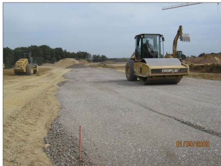
Abb. 5.22: Verdichten einer Baustraße
