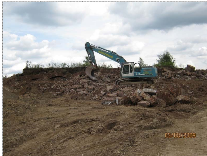
Abb. 5.28: Abtrag von Betonresten der ehemaligen Schießwand
