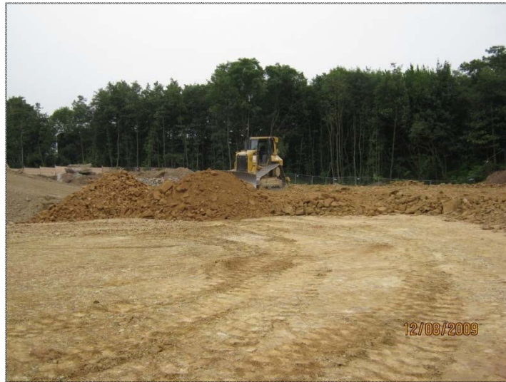
Abb.5.18: Planierung einer Baustraße
