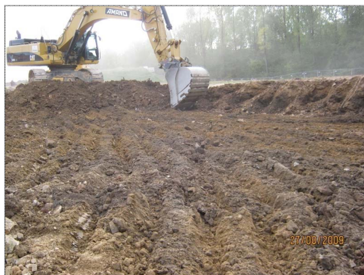
Abb.5.10: Bagger beim Ausheben von Lehmboden
