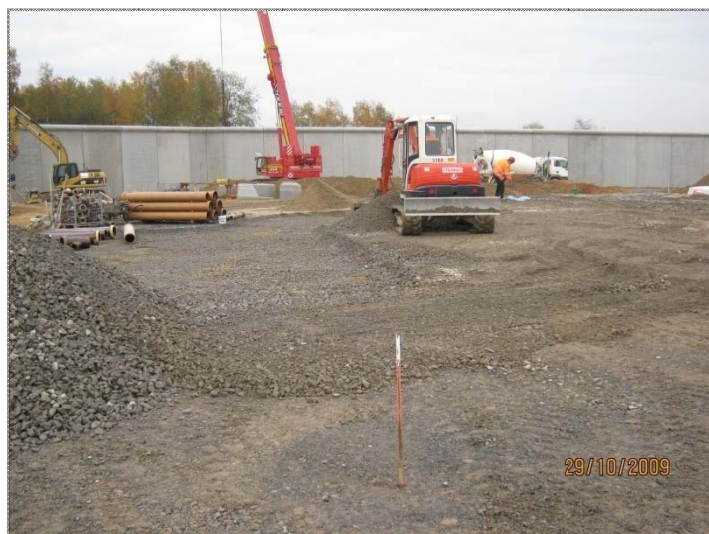
Abb.5.20: Erstellen eines Schotterplanums
