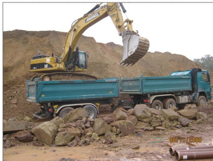
Abb.5.12: Beispiel Umschlagen von Bagger auf LKW
