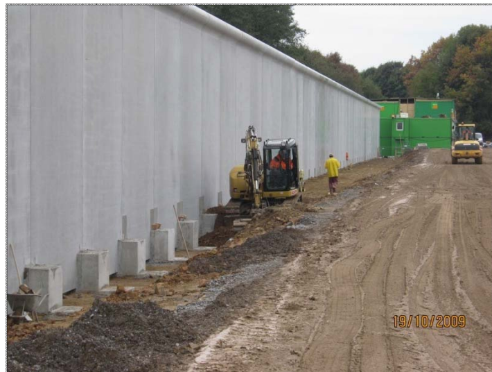
Abb.5.16: Verfüllen der Fundamente der Haftmauer
