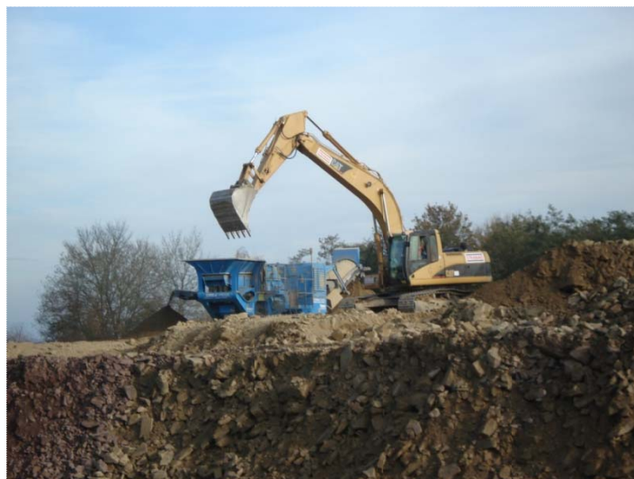
Abb.5.14: Brechen von Fels auf der Miete der JVA
