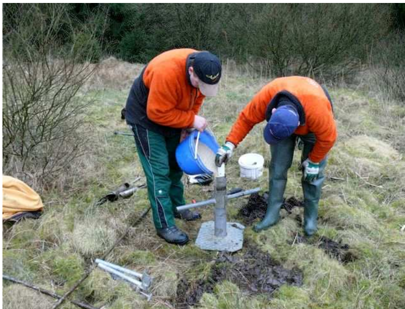
Abb. 6: Mitarbeiter des Forstamtes Neuenburg bei der Installierung der Messpegel
