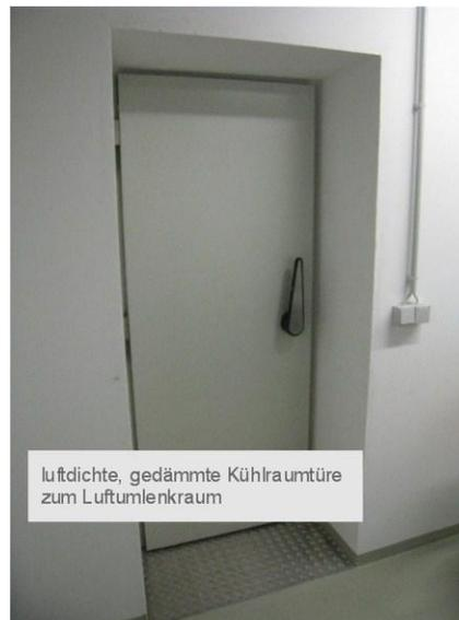
luftdichte, gedämmte Kühlraumtüre zum Luftumlenkraum
