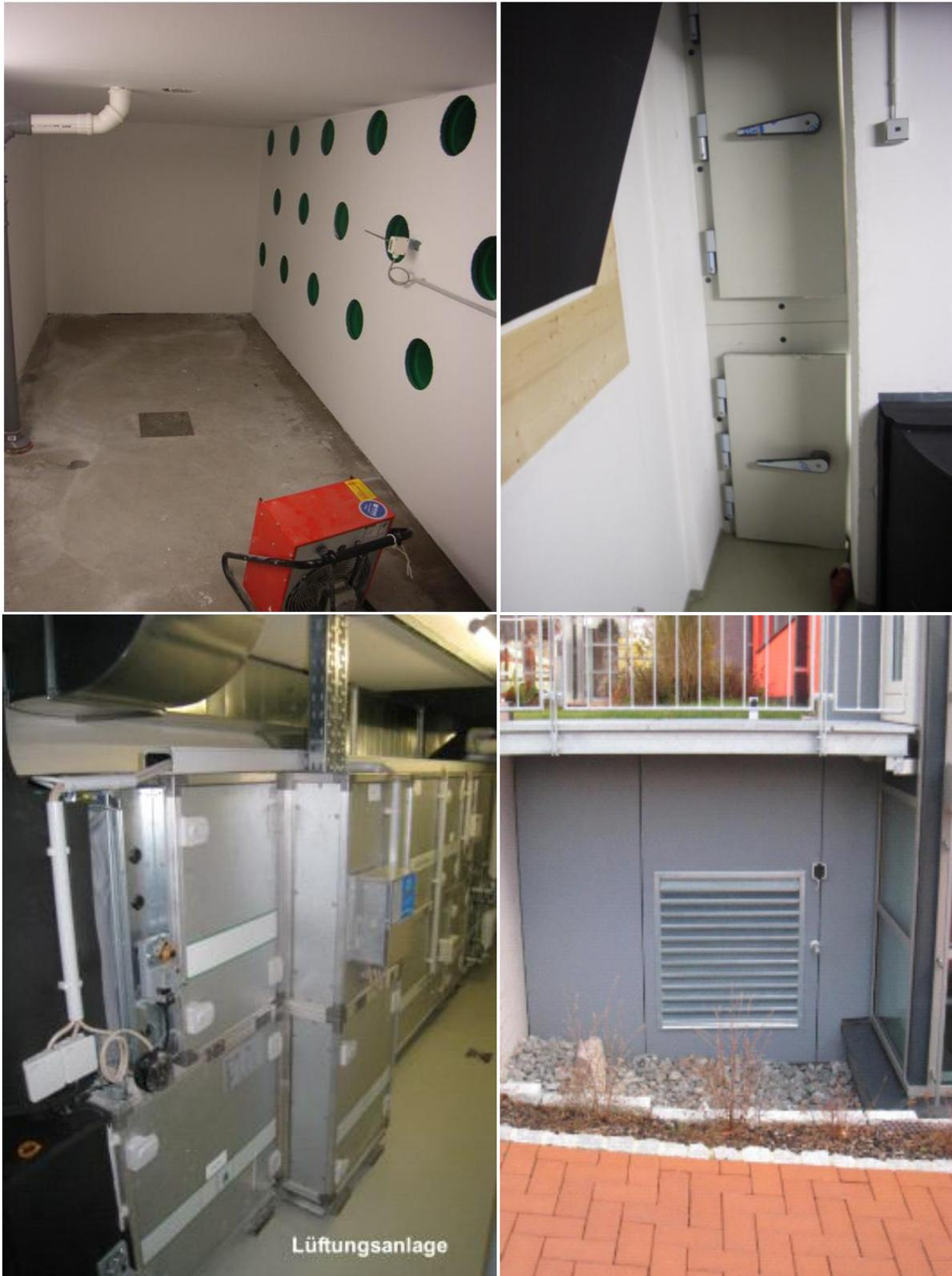
Abbildung 12: Zuluftaustrittsraum (oben links); luftdichte Türen zum Lufteintritts- und Austrittsraum en rechts);
