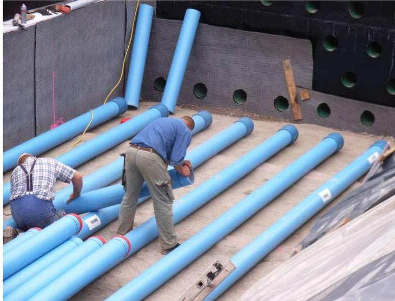
Abbildung 10: Verlegung der Erdwärmetauscherrohre im Kalksand.
