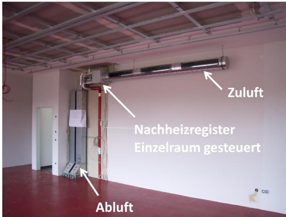
Abbildung 14: Lüftungsinstallation im Klassenzimmer.
