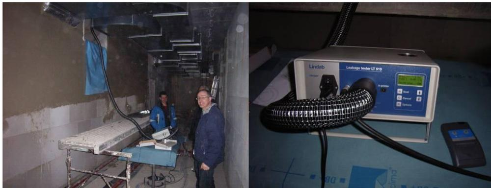
Abbildung 15: Referenzmessung der Dichtigkeit der Lüftungsrohre.
