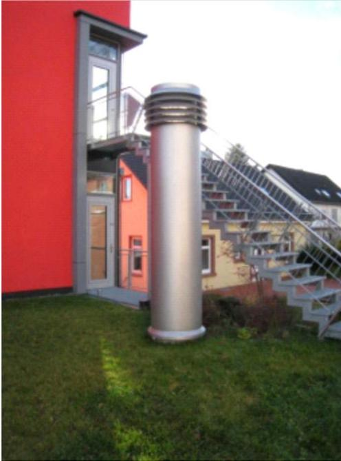
Abbildung 8: Ansaugturm  $\varnothing$  75 cm;
