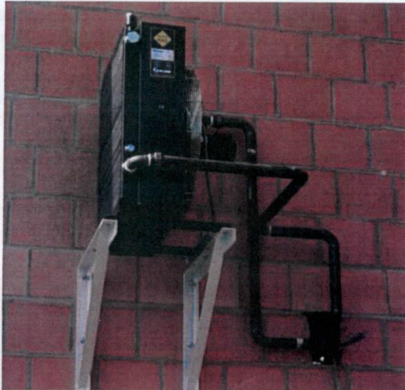
Abbildung 44: Lamellenwärmeübertrager W3
