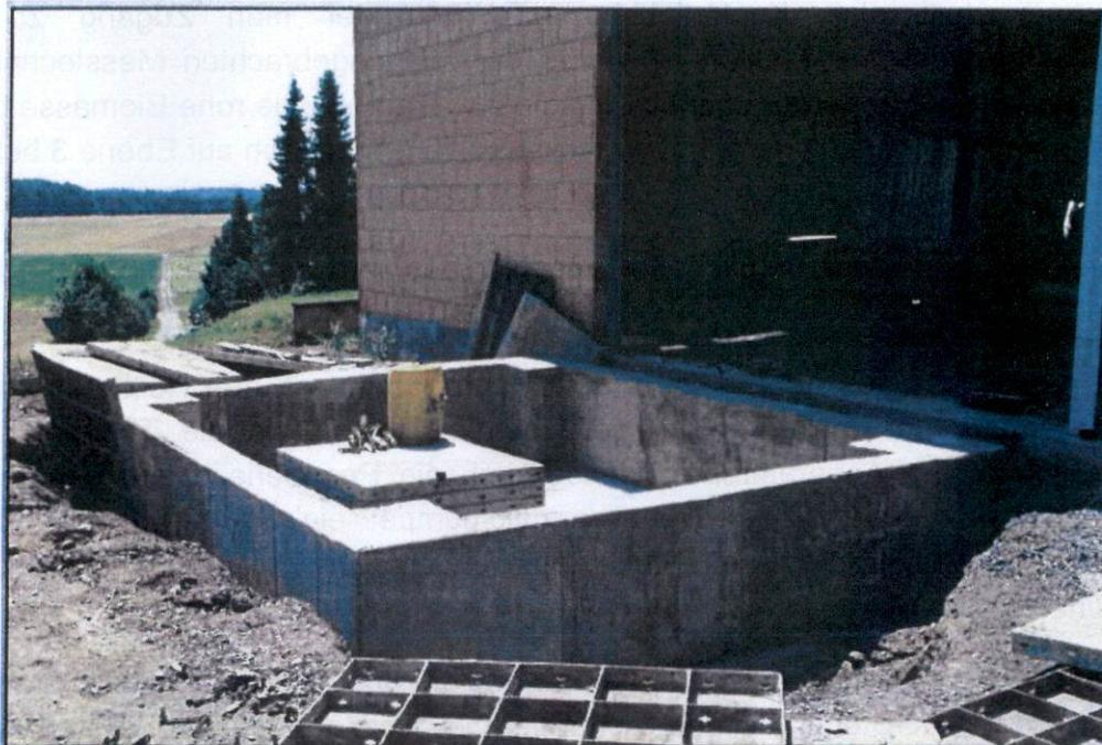
Abbildung 31: Fundament des Reaktorhauses (Stand Mai 2008)
