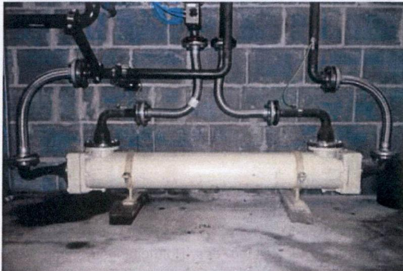
Abbildung 43: Rohrbündelwärmeübertrager W1
