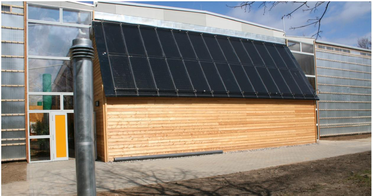
Abbildung 15: Südfassade mit Solarthermie, Luftkollektoren und Außenluftturm
