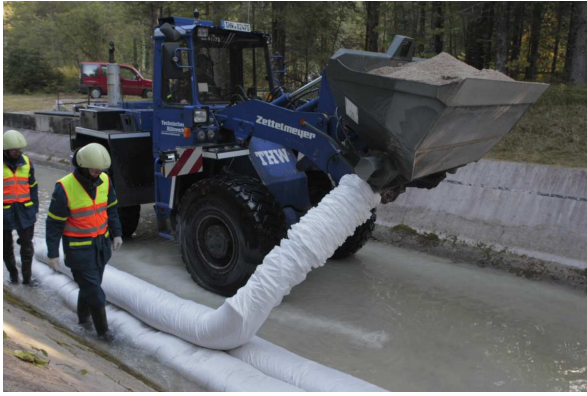
Foto 9: Dammbau in fließendes Gewässer
