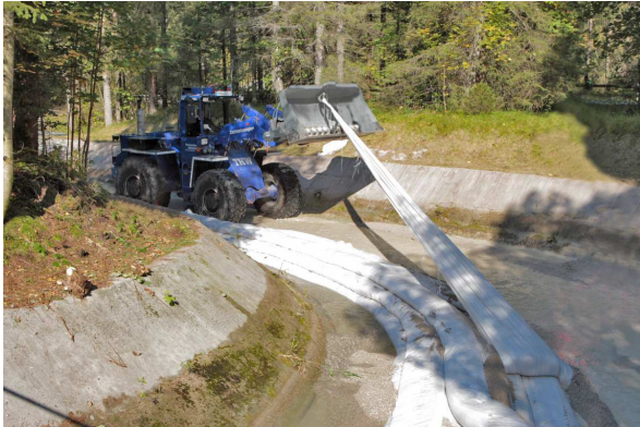
Foto 11: Abbau des Sandschlauchdammes
