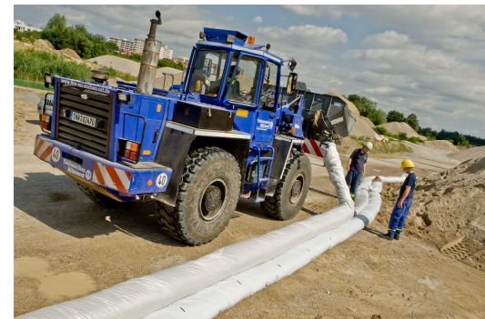
Foto 6: Auslegen der Folien- Sandschläuche
