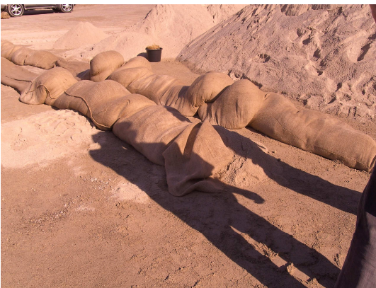
Foto 3: Ungleichmäßiges Befüllen und Auslegen der Juteschläuche
