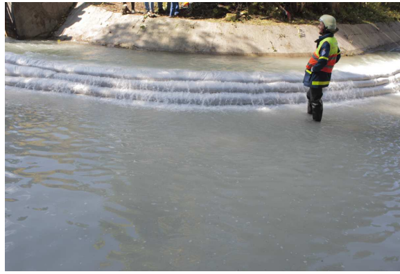
Foto 10: Fertiger Damm aus 10 Schlauchlagen
