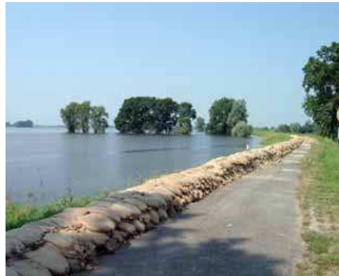
Beispiel Sandsackdamm: Elbdeich bei Wehningen in Niedersachsen, August 2002; Bildrechte: Niedersächsischer Landesbetrieb für Wasserwirtschaft, Küsten- und Naturschutz
