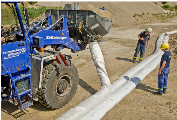
Foto 12: Förderschaukel und Sandschlauch, Hochwasser der flexible, schnelle Hochwasserschutz
