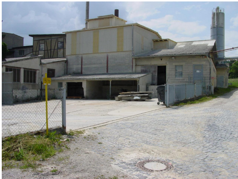
Abb. 2.10: Aufstellungsort vor Baubeginn
