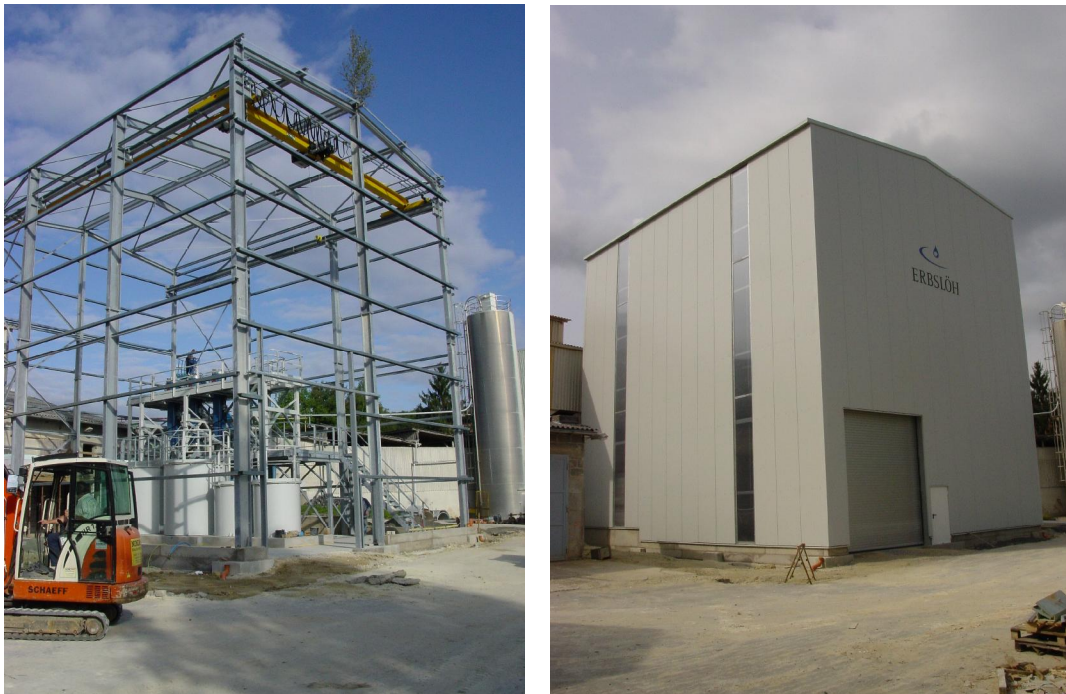
Abb. 2.12: Stahlbauhalle, Rechts: Stahlgerüst, Links: mit fertig gestellter Fassade
