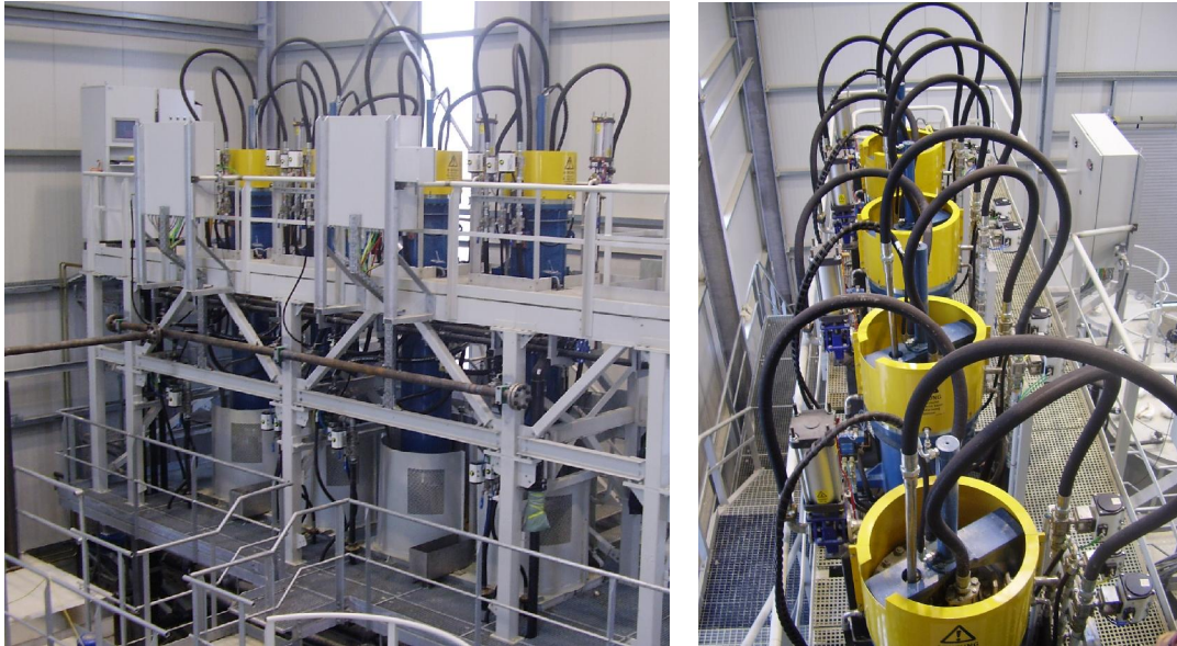
Abb. 2.13: Röhrenpressen fertig installiert
