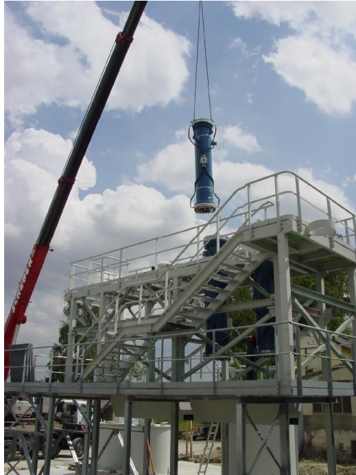
Abb. 2.11: Montage der Röhrenpressen
