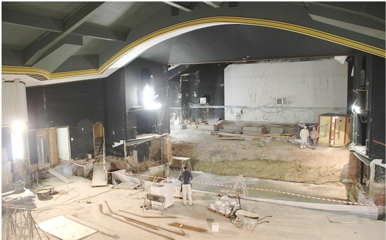
Abb.41 Vorbereitungsarbeiten für den Bodenausbau im Bereich Saal, Orchestergraben und Bühne
