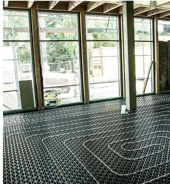
Abb.45 Fußbodenaufbau in der Kammerbühne, Abb.46 Fußbodenaufbau mit Fußbodenheizung in der Theaterklausur
