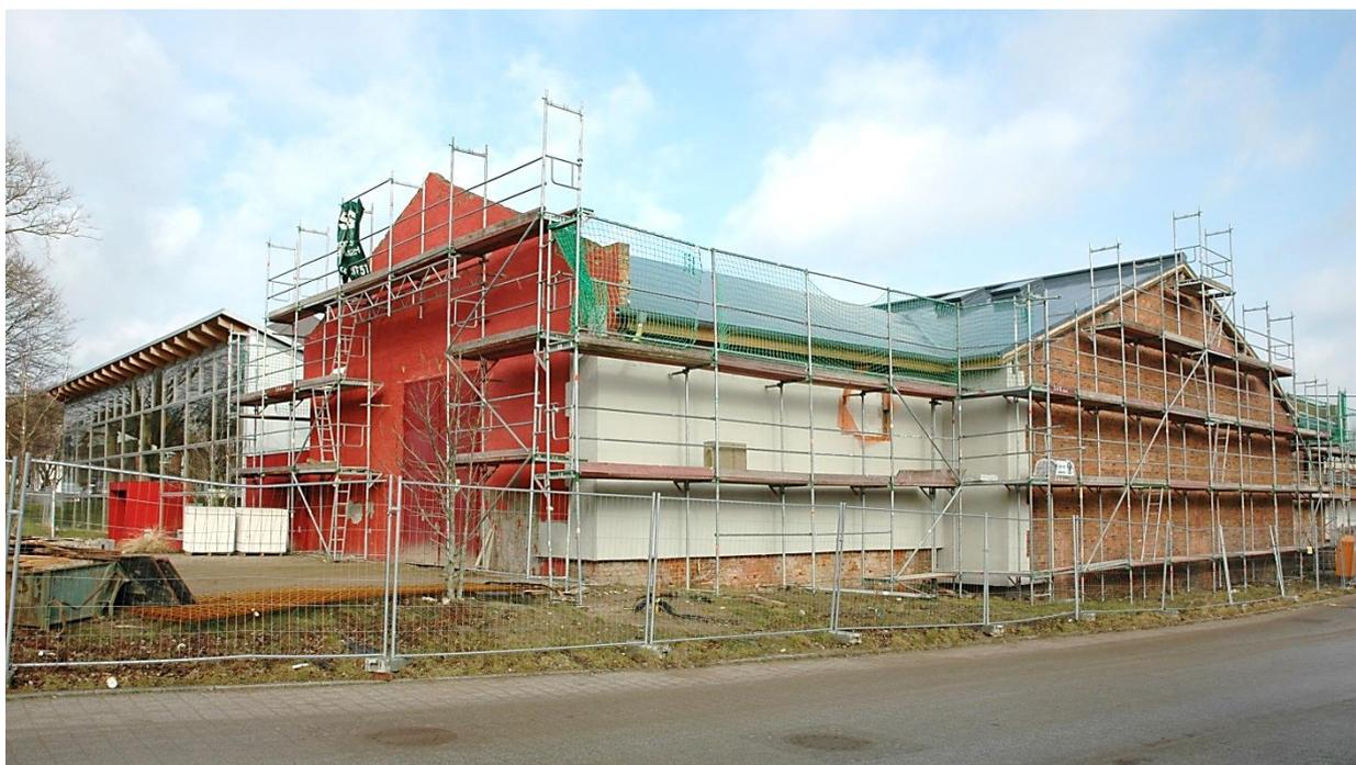
Abb.38 Außenansicht auf die Sanierung des Bühnenhauses in der Bauphase – Dämmen mit der Mineralwolle
