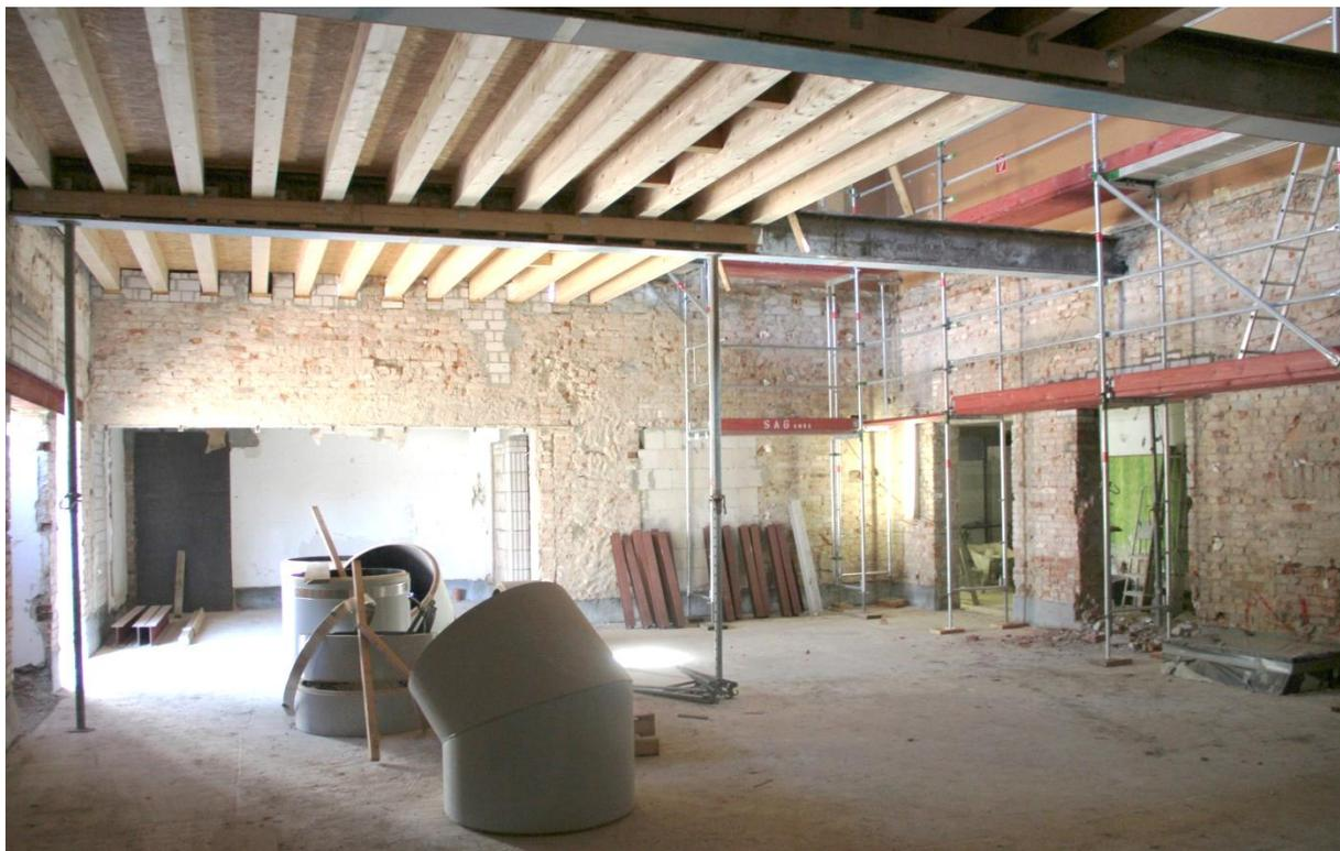
Abb.37 Vorfoyer Nordwest in der Bauphase – bestehendes Mauerwerk und neue Konstruktion aus Stahl/Holz
