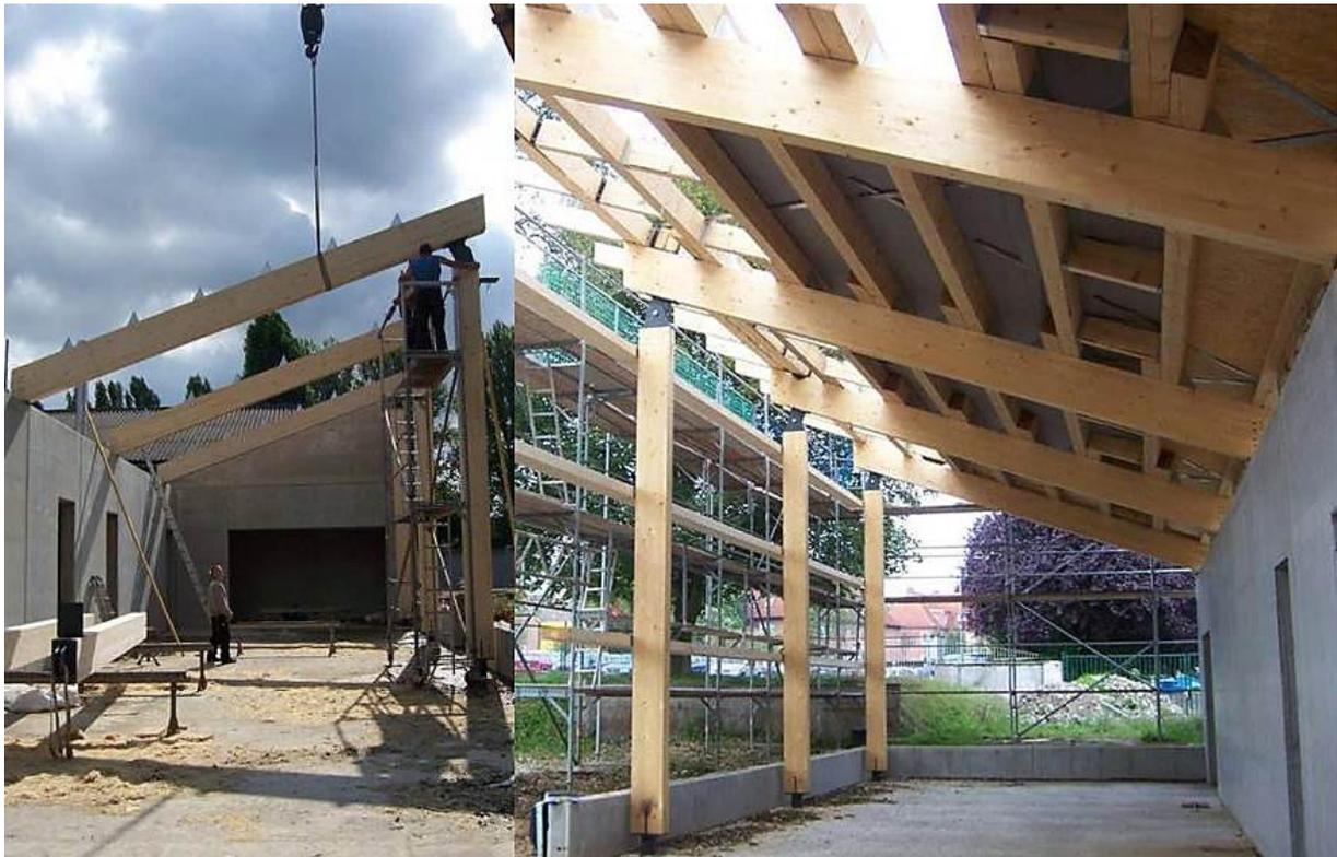
Abb.8-9 Konstruktion des Pultdaches im Bereich des Ergänzungsbaus Süd(west) Foyer
