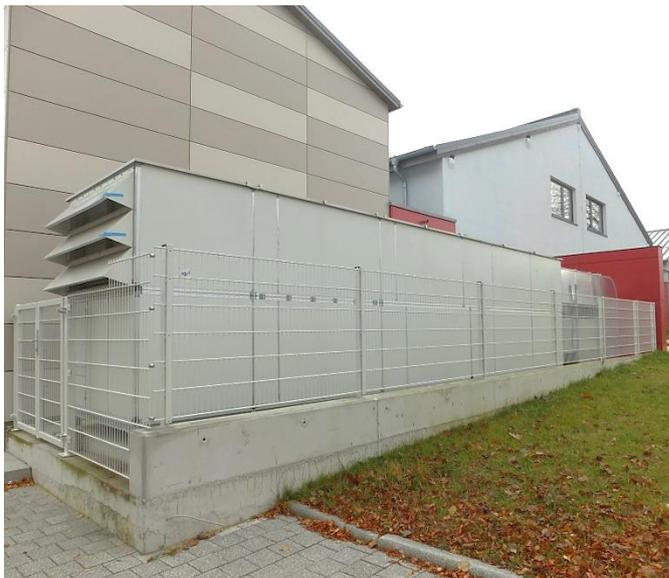
Abb.53 Die RLT-Anlage, die das Saalgebäude versorgt
