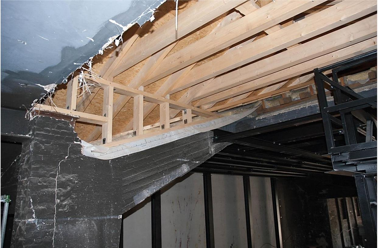
Abb.47 Holzkonstruktion des Satteldaches im Bereich Seitenbühne, die erneuert wurde
