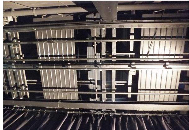
Abb.58-59 Strahlplattenheizung im Südfoyer und auf der Bühne
