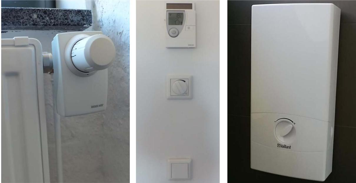
Abb.62-63 Bedarfsorientierte Steuerung der Temperatur in Garderoben
