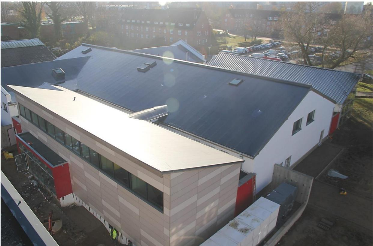
Abb.48 Die obere Dachhaut des Gebäudes besteht aus einer EVA-Dachbahn (Evalon, Alwitra)
