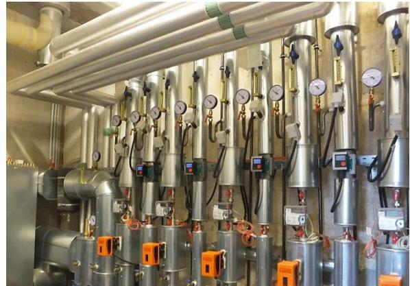
Abb.56-57 Brennwertkesselanlage und Heizkreisverteilungen im Heizraum
