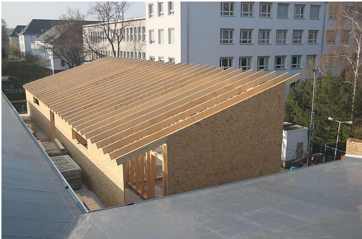
Abb.49 Konstruktion des Pultdaches im Bereich des Ergänzungsbau Nord(ost)
