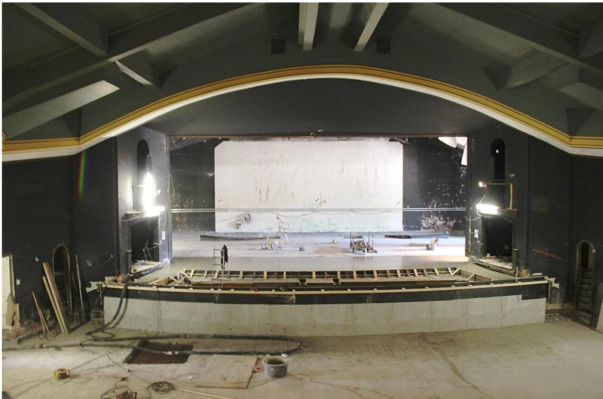
Abb.43 Fortsetzen der Bodenarbeiten – Wände von Orchestergraben als erhöhte Stufe des Bühnenbereiches
