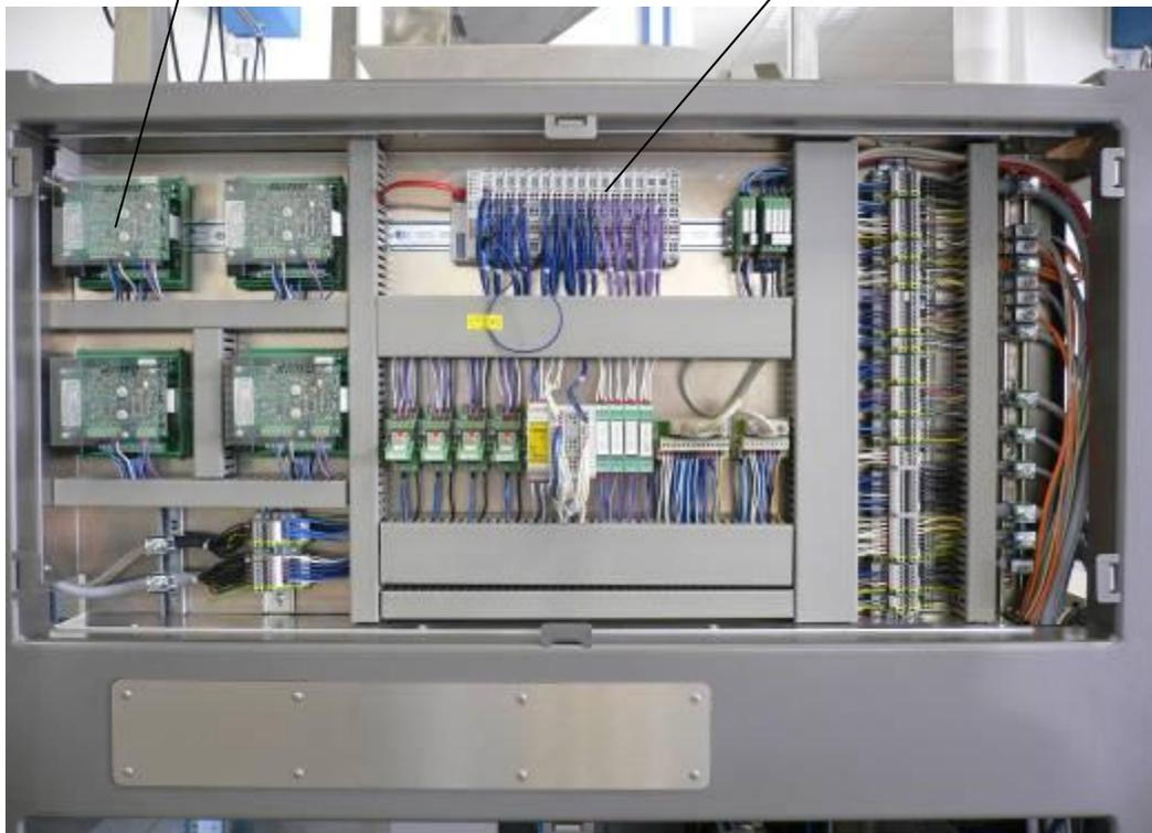
**Abb. 3: Anordnung der elektrischen Module im Schaltschrank**
