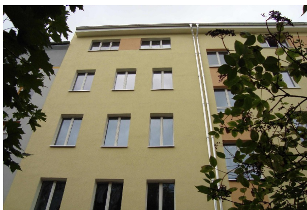
Abbildung 2: Westansicht nach Sanierung
