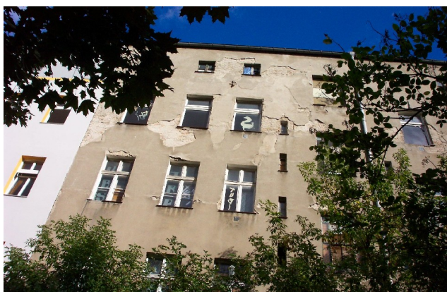
Abbildung 1: Westansicht vor Sanierung
