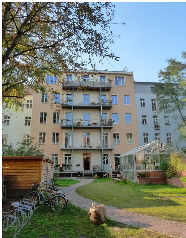
Abbildung 5: Ostansicht nach Sanierung mit Gewächshaus, Wasser-filteranlagen, Solar- und PV-Anlagen auf dem Dach
