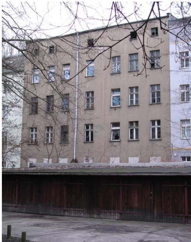
Abbildung 4: Ostansicht vor Sanierung mit vorgelagertem Garagenhof
