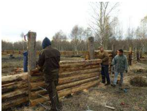
Bau des Fangstands mit Robiniensäulen und Querstangen aus Lärchenholz. Foto: A. Wenk
