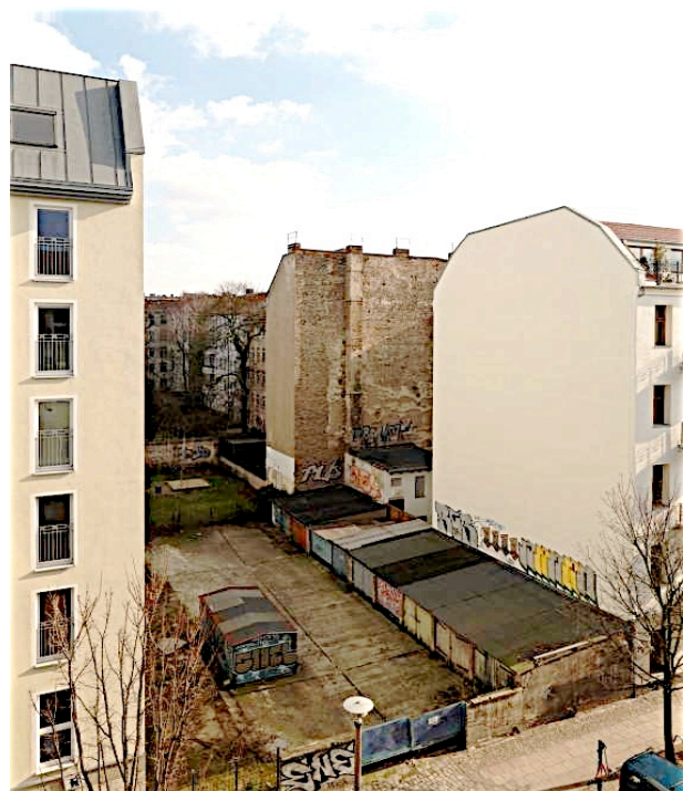
Bild 2: Baulücke Esmarchstraße 3, April 2006
