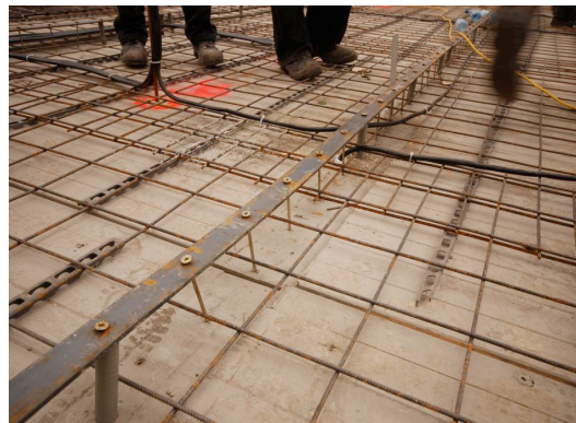
Bild 27: Die Holz-Betonverbunddecke; Herstellung des 1. Geschosse
