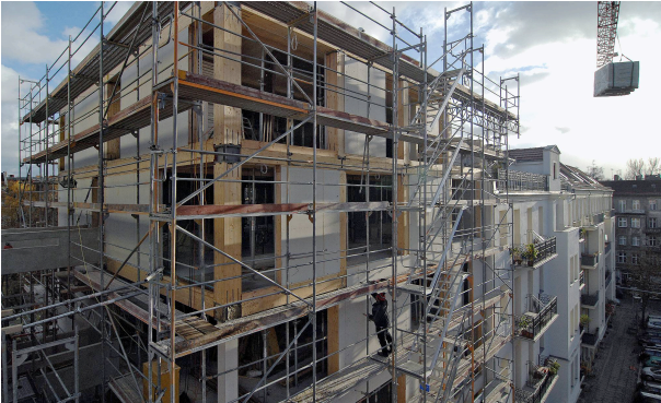
Bild 25: kurz vor Abschluss der Rohbauphase
