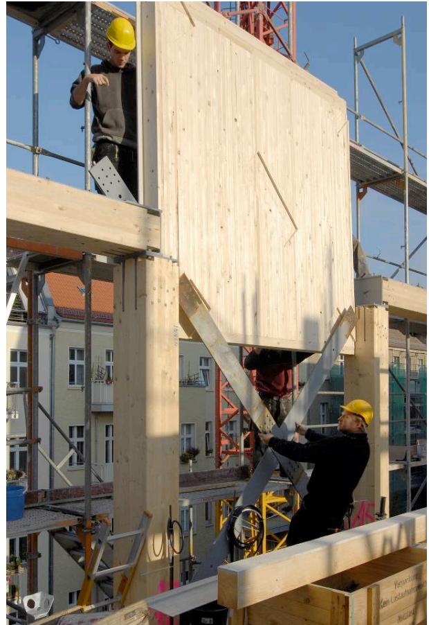
Bild 23: Montage der Holzwände
