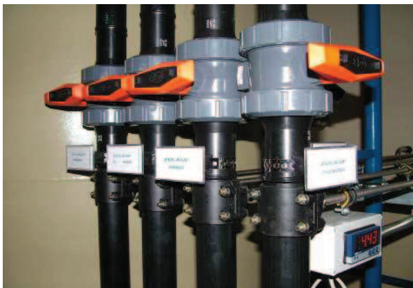
Abbildung 7) Vorratstank mit einem Volumen 20\text{m}^3 . Links oben: Aufsicht mit Wasserzuleitungen; links unten: Zuleitungshähne für verschiedene Wässer, digitale Füllstandsanzeige; rechts: technische Darstellung Vorratstank mit Zuleitungen und Mischsystem. (Quelle: UBA, ALTHOFF)
