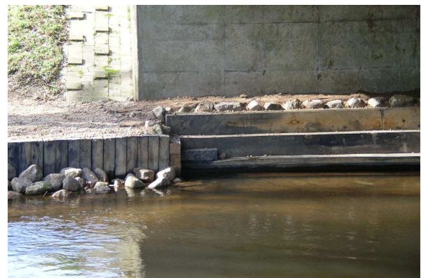
Abb. 96: Eingebaute Berme unterhalb der K20 bei Wetzen, März 2009.
