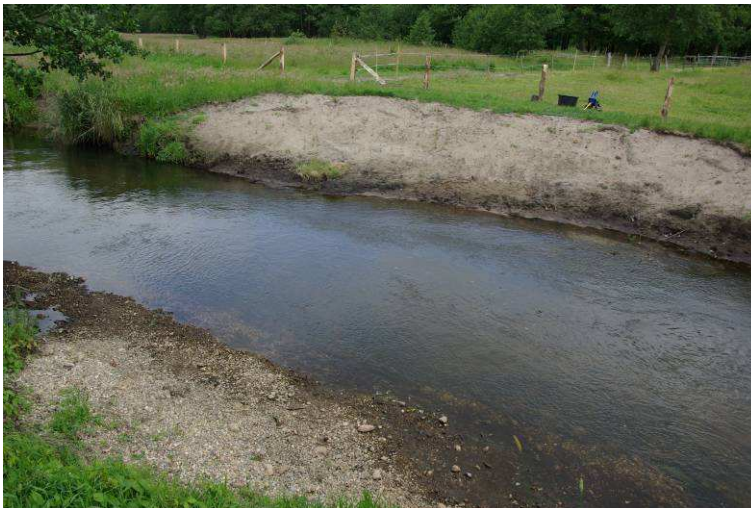
Abb. 102: Aufweitung und Kies-schüttung auf gegenüberliegenden Seite.
