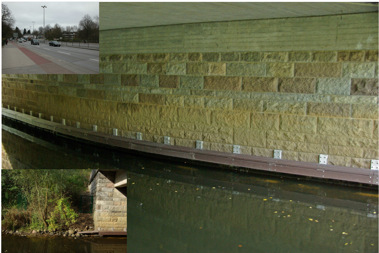
Abb: 55: Querungshilfe am Saseler Damm an der Alster.
