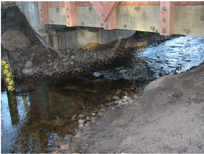
Abb. 97: Uferbermen an der Brücke in Bockum
