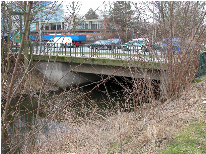
Abb. 17: Brücke an der Wandse ohne Bermen.
