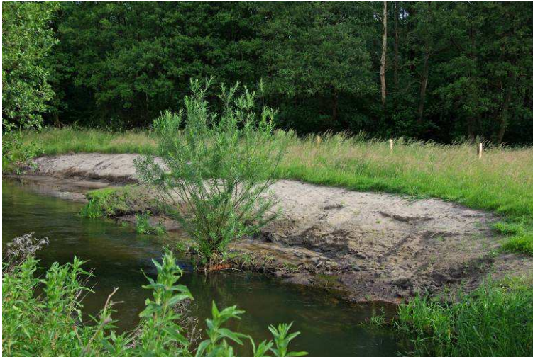
Abb. 101: Wundlegung und Aufweitung der Uferlinie.
