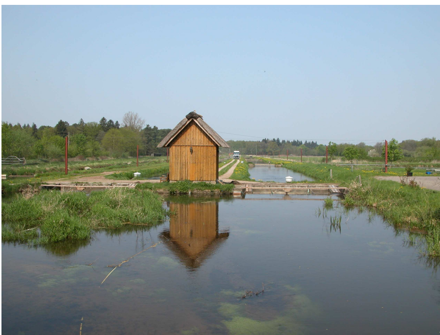
Abb. 98: Fischteichanlage bei Gut Schnede, ehemals größte europäische Forellenteichanlage.
