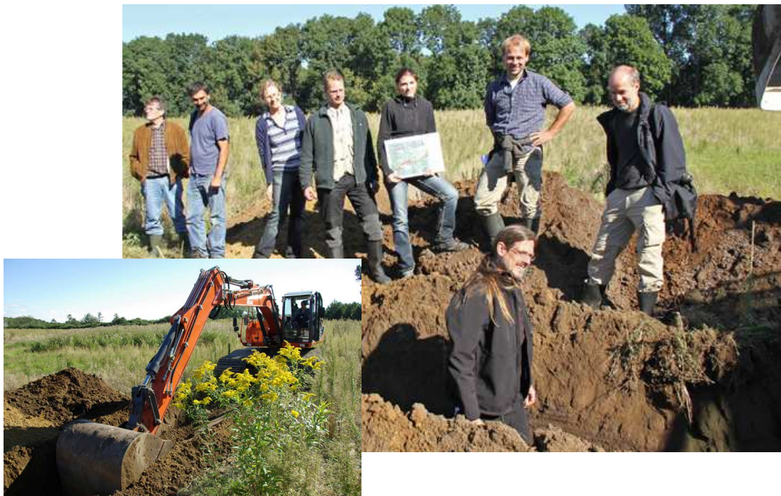
Abb. 65: Spatenstich bei Nütschau an der Pilkenbek.
