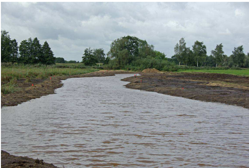
Abb. 116: Altarm 3.1 nordöstlich von Hohensand an der Ilmenau.
