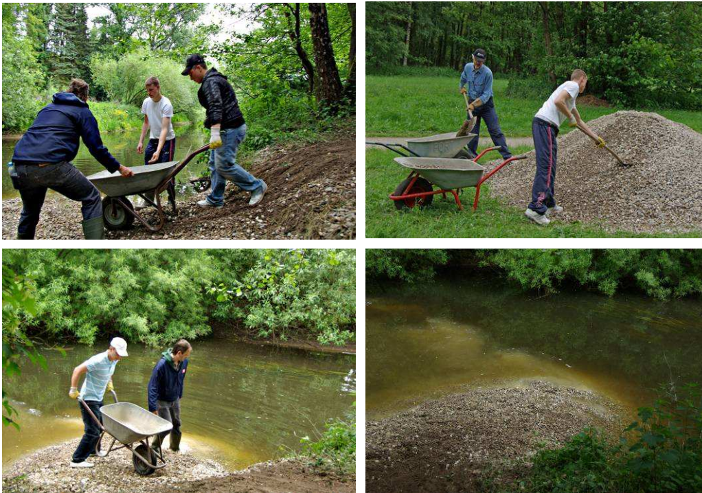
Abb. 57: 105 Tonnen Kies wurden in Handarbeit an mehreren Tagen in der Alster verbaut.
