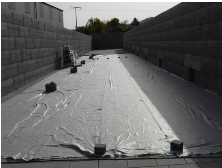
Abb.34: Halbseitige Abdeckung mit Geo-Vlies
