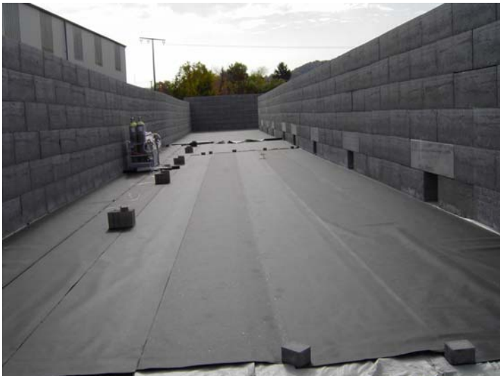
Abb.33: Halbseitige Abdeckung mit Dachpappe
