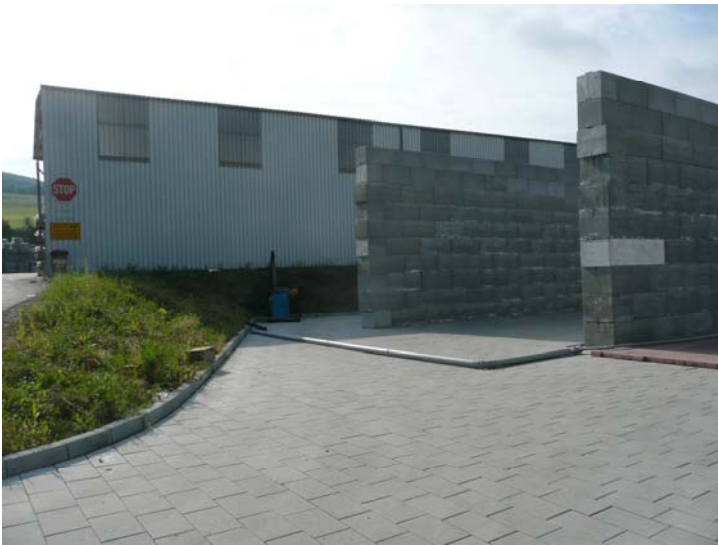
Abb.35: Zufahrt zur Canyon-Testfläche mit Standort Emissionsquelle
