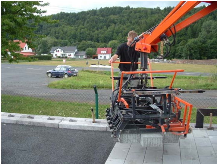
Abb.30: Verlegung von photokatalytisch aktivem Pflaster auf Canyon-Testfläche
