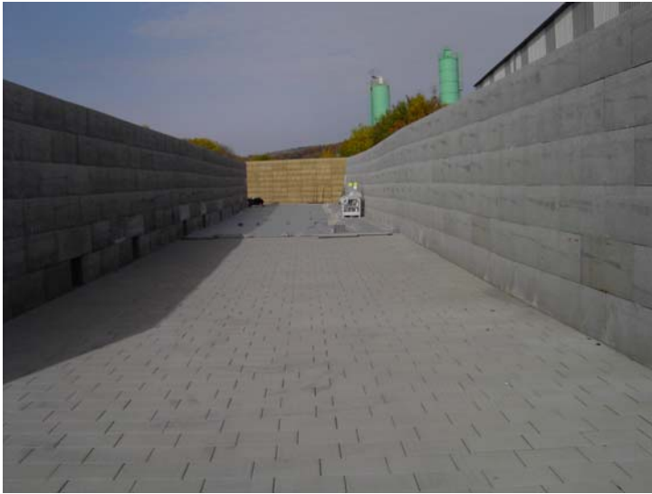
Abb.32 Canyonfläche halbseitig abgedeckt, mit Gasflaschen als NO x -Quelle
