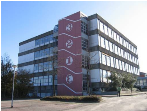
Bild 52 BT A Altbau Südansicht
