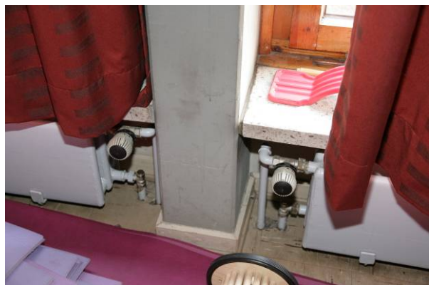
Bild 364 BT E Ostfassade
