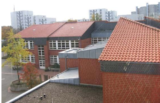
Bild 65 BT B Dachaufsicht
