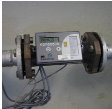
Bild 72 Wärmemengenzähler Fernwärme
