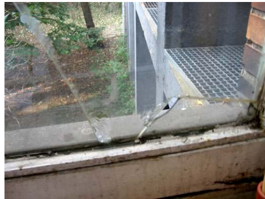
Bild 345 BT B Fenster Flur
