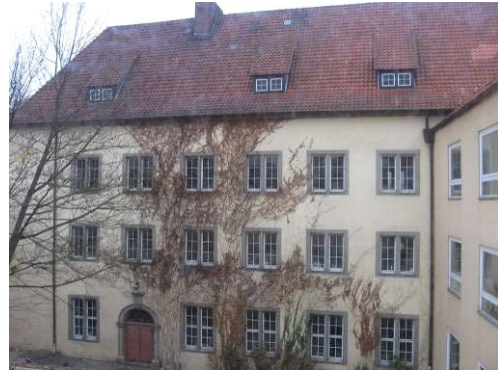
Bild 197 BT B Nordwand
