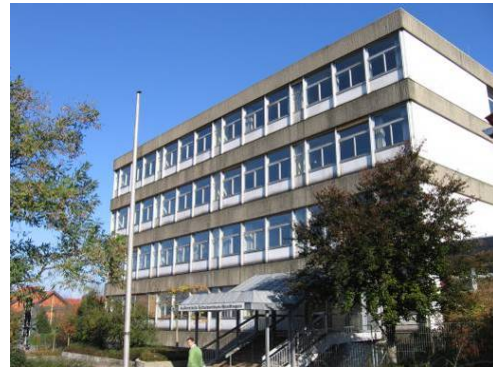
Bild 53 BT A Altbau Westansicht
