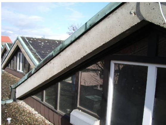
Bild 206 BT C Fenstergiebel West
