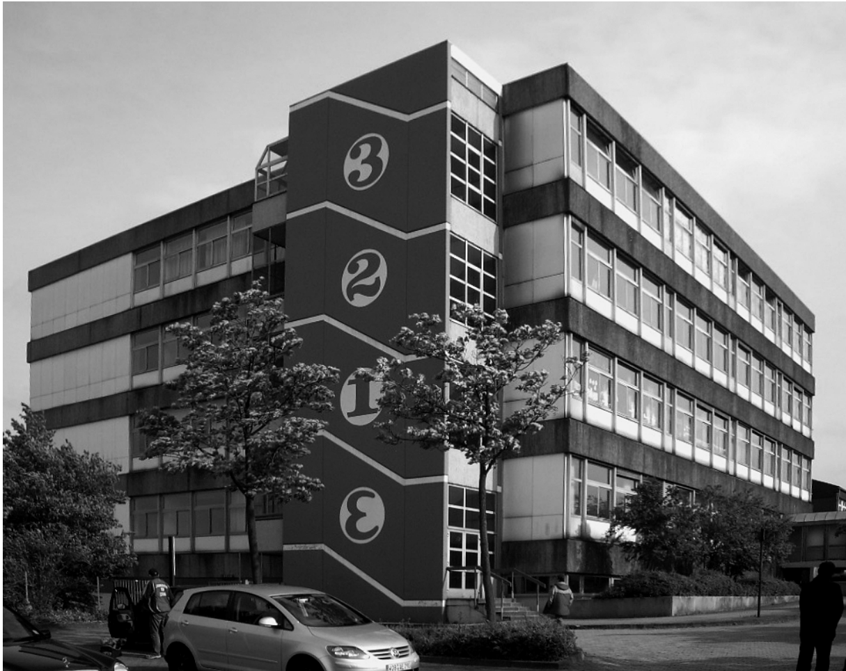
Bild 32 Ansicht Nordwest Altbau der Regenbogenschule Wolfsburg
