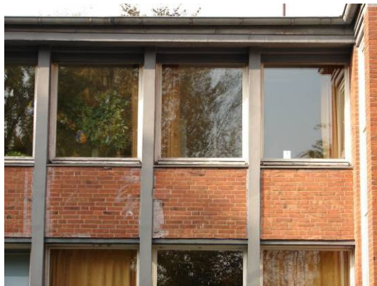
Bild 336 BT A Fassade West
