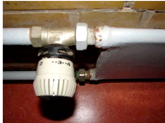
Bild 386 BT B Thermostatventile
