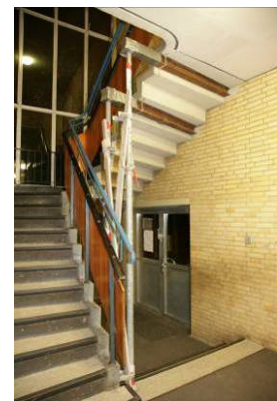
Bild 352 BT C Treppenhaus
