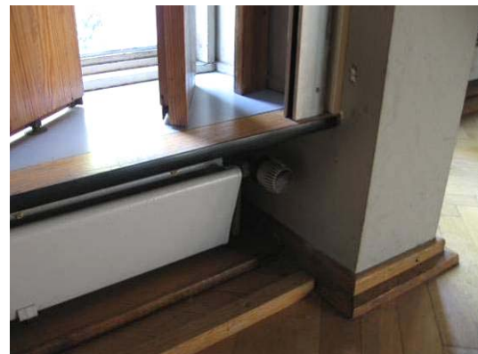
Bild 372 BT G Südwand
