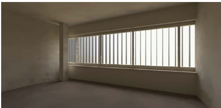
Bild 145 Vertikale, drehbare Aluminium-Doppellamelle mit 30% Durchlässigkeit
