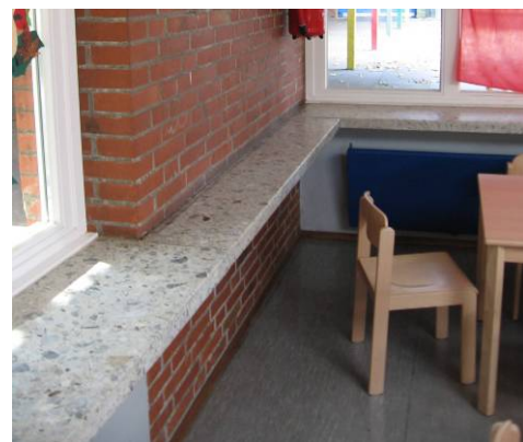
Bild 358 BT D Pausenhalle Südwestfassade
