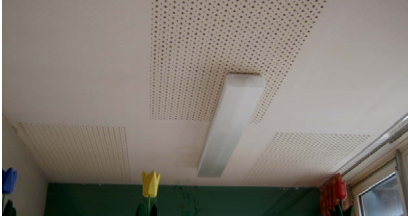
Bild 416 Ansicht der Decken in den Unterrichtsräumen, in einem Teil der Nebenräume und im Treppenhaus des Kreuzbaus
