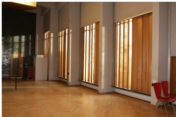
Bild 371 BT G Südwand
