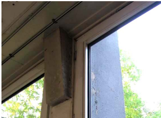
Bild 344 BT B Nebenfassade
