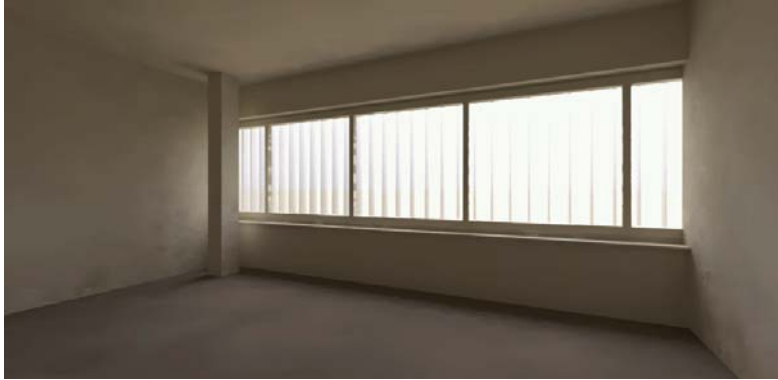
Bild 146 Vertikale, drehbare Aluminium-Doppellamelle mit 60% Durchlässigkeit
