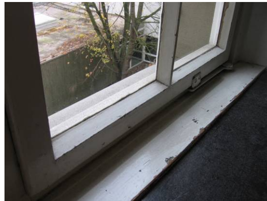
Bild 199 BT B Fenster Flur
