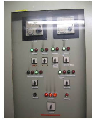
Bild 73 Heizungs- regelung
