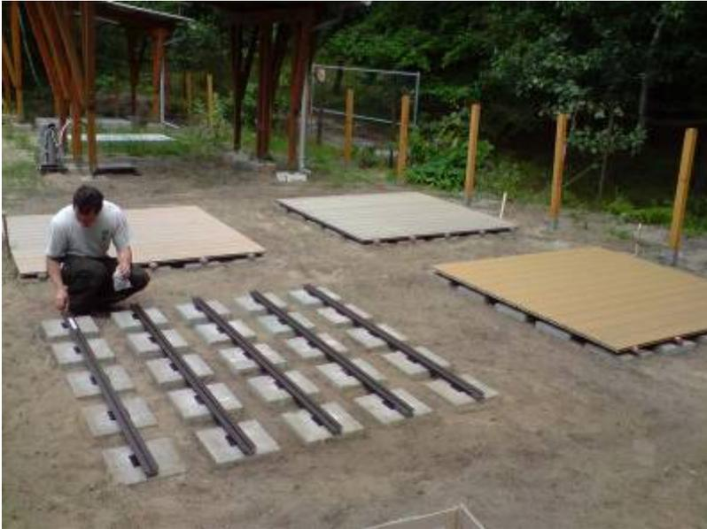
Abbildung 1: Verlegung der WPC-Terrassendielen (FH Eberswalde) nach Aufbauanleitung.
