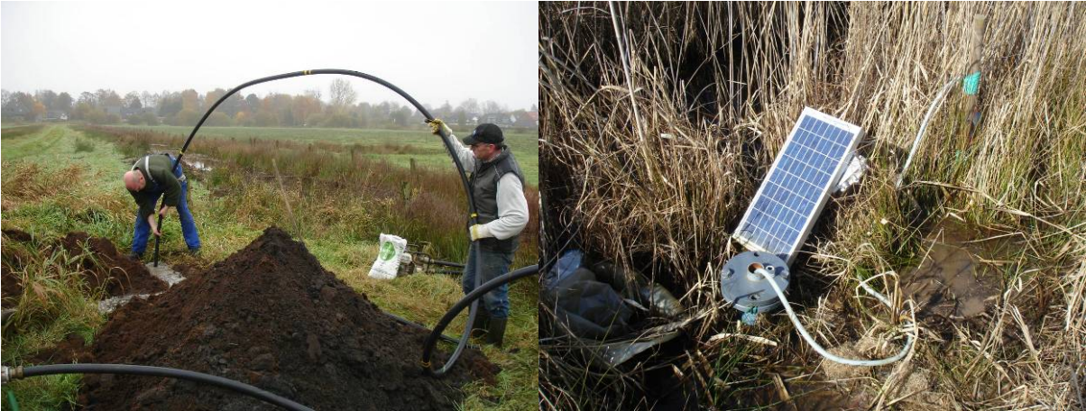
Abb. 15: Die Brunnenbauer beim Spülen des Grundwasserbrunnens an der Probestrecke 047 im Hollerland und die Pumpenstation an der Probestrecke HL004. Fotos: R. Kesel
