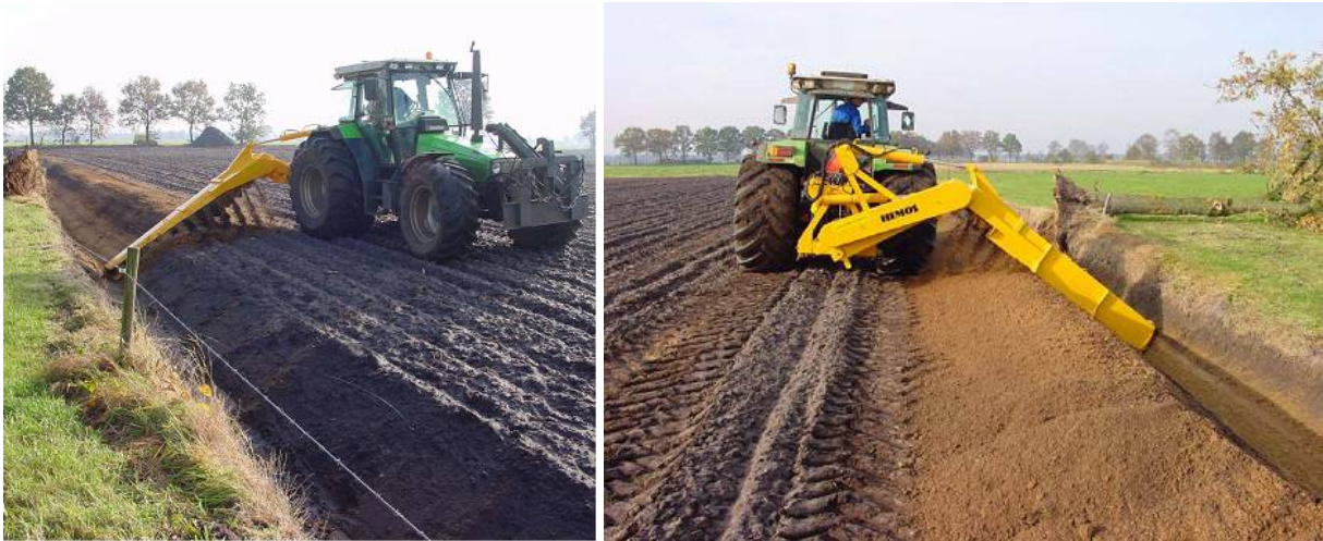
Abb. 8: Der Vijzelslootreiniger beim Einsatz zur Grabenprofilierung. (Fotos: www.hemos.nl )
